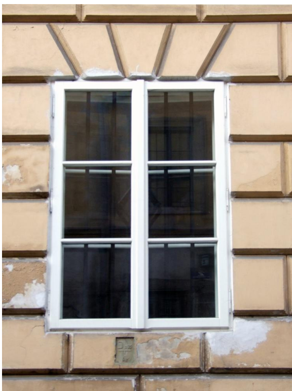
41. Kraków, ul.Kanonicza 1, fasada. Wadliwe uzupełnienia tynków związane z wymianą lub reperacją stolarki okiennej.
