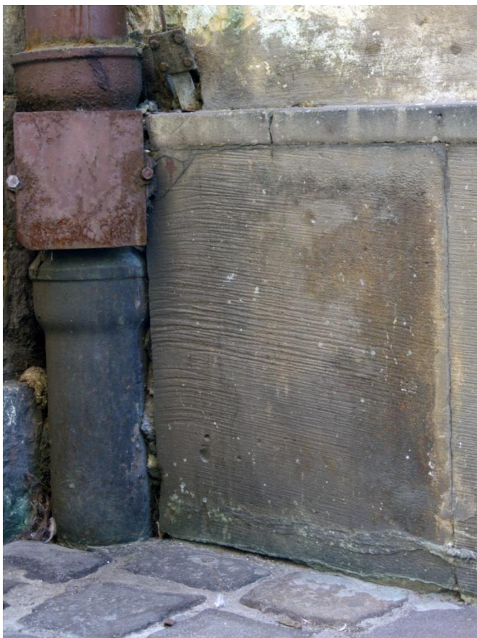
57. Kraków, ul.Kanonicza 1, elewacja północna od strony ul.Senackiej. Zaplamienia cokołu i ogniska korozji biologicznej w rejonie uszkodzonej rury spustowej.
