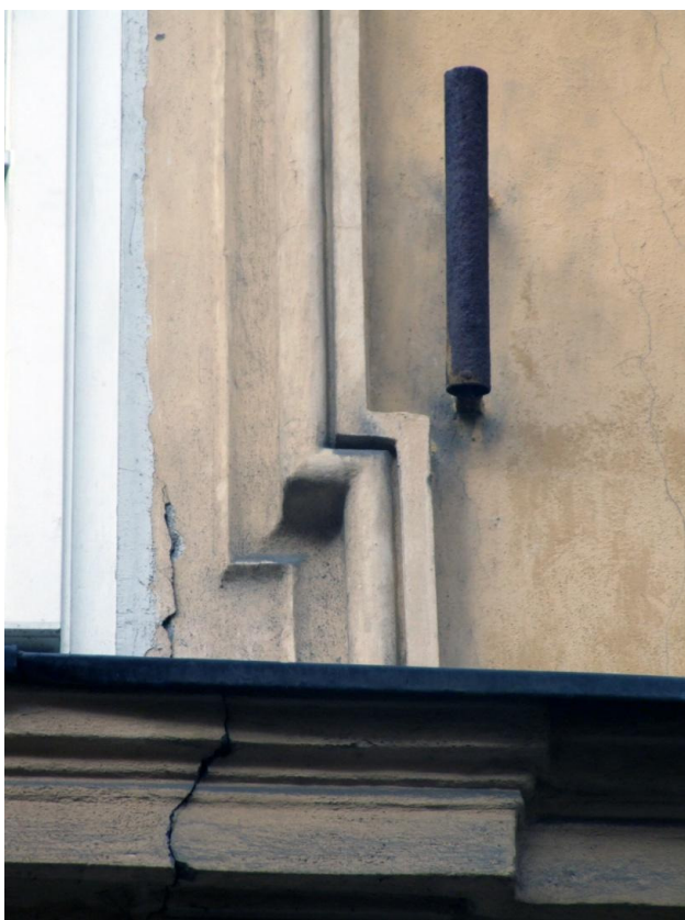
33. Kraków, ul.Kanonicza 1, fasada. Spękanie w dolnej części opaski i podokiennika okna I piętra.
