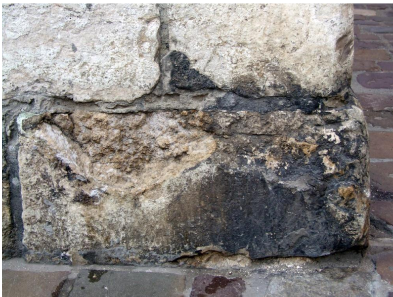
48. Kraków, ul.Kanonicza 1, fasada. Ciemne nawarstwienia na powierzchni ciosów cokołu przy podłożu.
