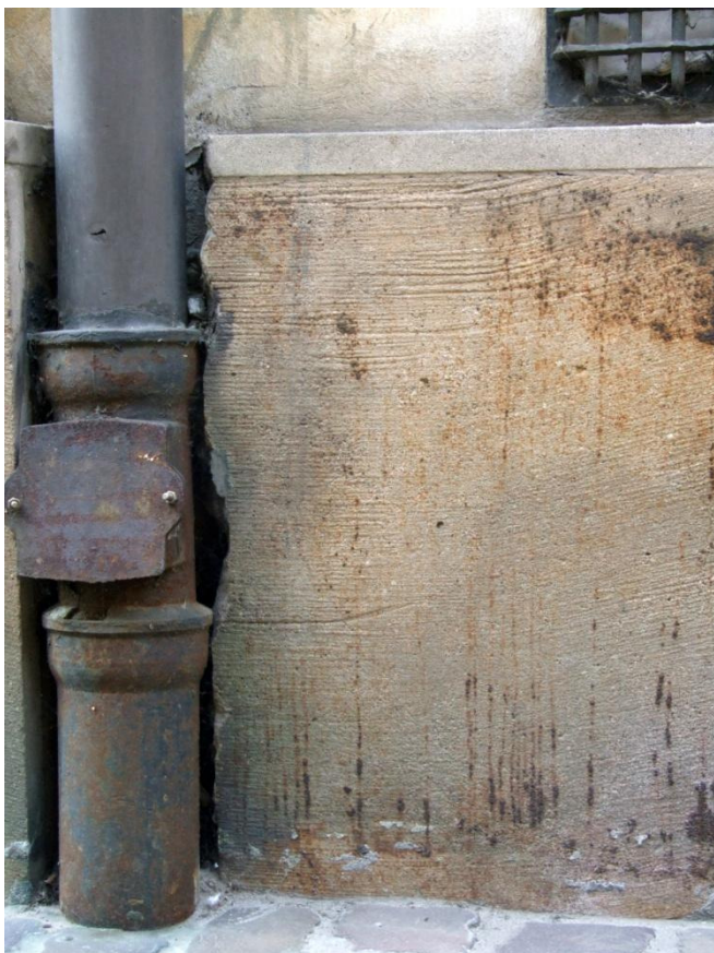
67. Kraków, ul.Kanonicza 1, elewacja północna od strony ul.Senackiej. Ubytki kamienia na krawędzi płyty okładziny cokołu i zaplamienia okładziny w rejonie sztyndra rury spustowej.
