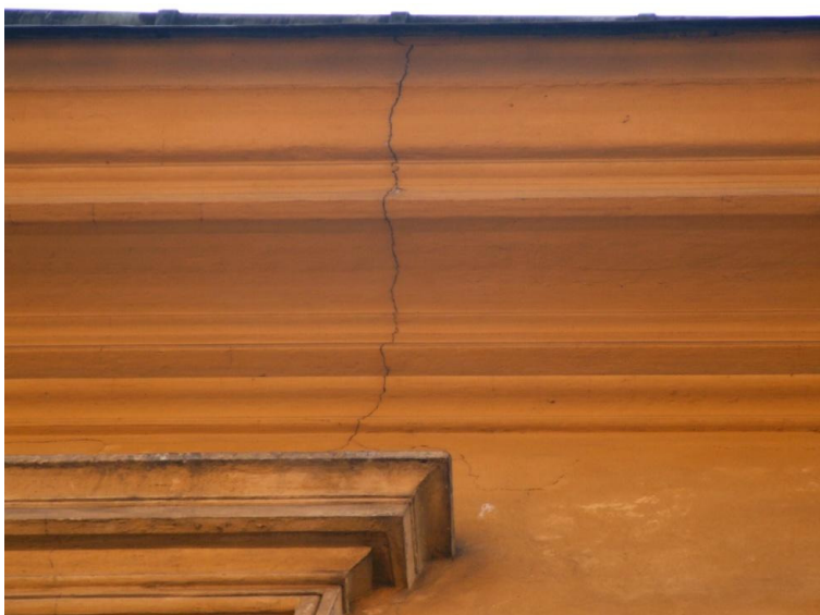
55. Kraków, ul.Kanonicza 1, elewacja północna od strony ul.Senackiej. Spękania gzymsu koronującego.
