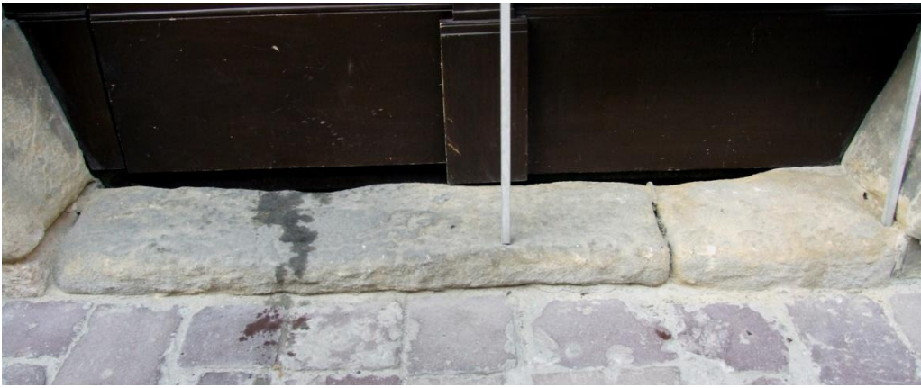
26. Kraków, ul.Kanonicza 1, fasada. Próg portalu - wyoblenia ciosów, ubytki spoinowania, tłuste zabrudzenia.
