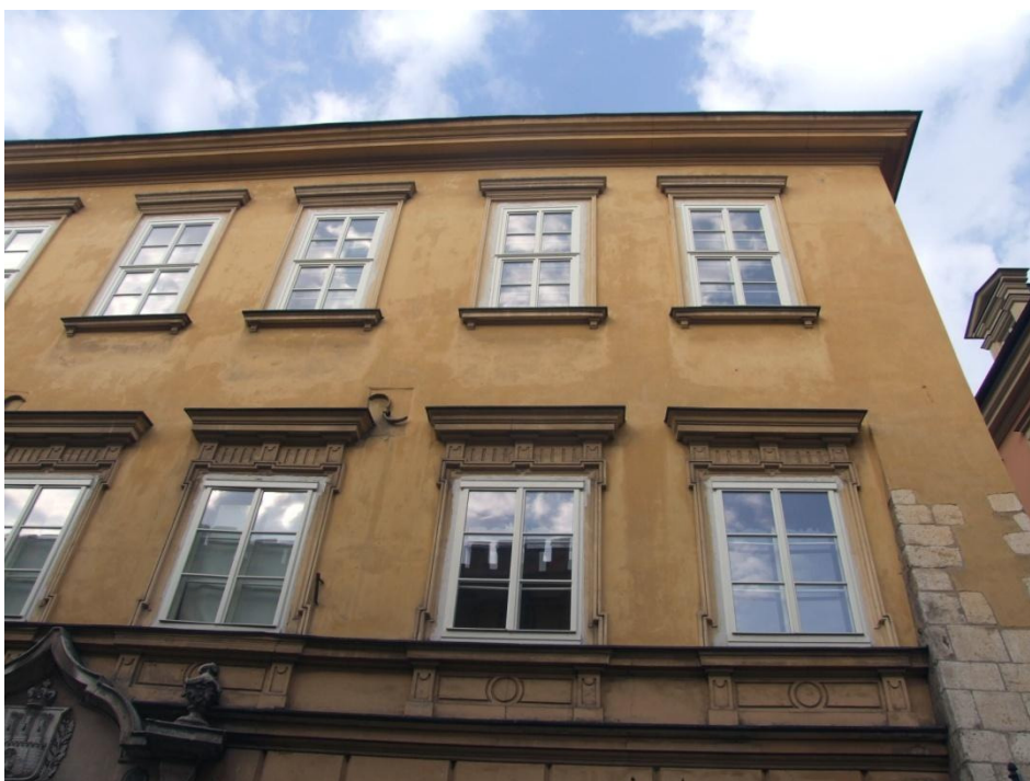
5. Kraków, ul.Kanonicza 1, fasada. Widoczne przebarwienia i zaplamienia farb elewacyjnych.
