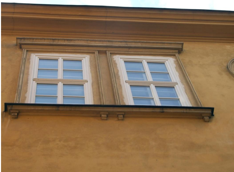
62. Kraków, ul.Kanonicza 1, elewacja północna od strony ul.Senackiej. Przebarwienia i zaplamienia farb elewacyjnych. Niestaranne uzupełnienia zaprawą o białym kolorze wokół stolarki okien. Spękania gzymsu wieńczącego.
