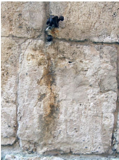
51. Kraków, ul.Kanonicza 1, elewacja północna od strony ul.Senackiej. Rdzawe zaplamienia na ciosie wapiennym cokołu powstałe wskutek wypłukania produktów korozji z elementu metalowego.
