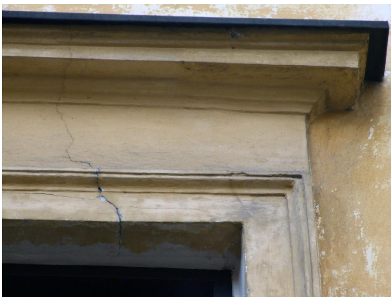
64. Kraków, ul.Kanonicza 1, elewacja północna od strony ul.Senackiej. Spękania w nadprożu okna.
