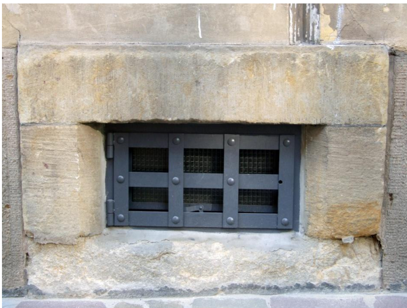
39. Kraków, ul.Kanonicza 1, fasada. Obramienie okienka piwnicznego - zniszczenia ciosu zlokalizowanego bezpośrednio wzdłuż podłoża.
