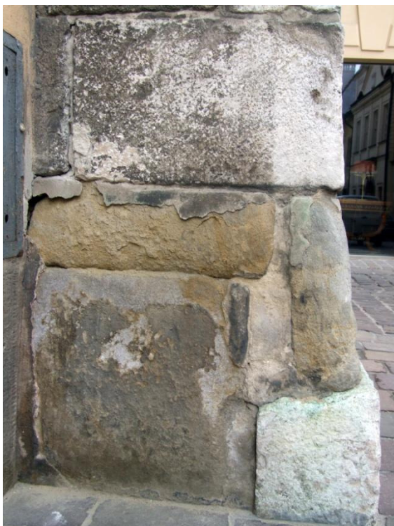
38. Kraków, ul.Kanonicza 1, fasada. Dolna część szkarpy - korozja ciosów piaskowcowych, zabrudzenia ciosów wapiennych, odstające i wykruszone spoinowanie.
