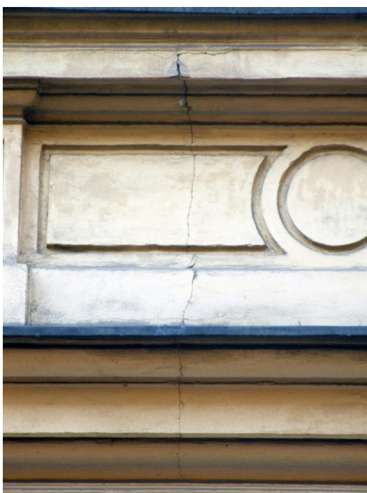
29. Kraków, ul.Kanonicza 1, fasada. Spękania podokiennika i płyciny podokiennej.
