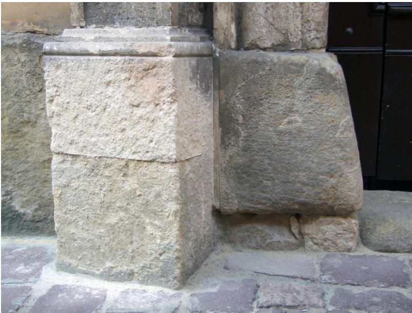
27. Kraków, ul.Kanonicza 1, fasada. Proszkowanie i osypywanie się kamienia w dolnych partiach portalu (część południowa).
