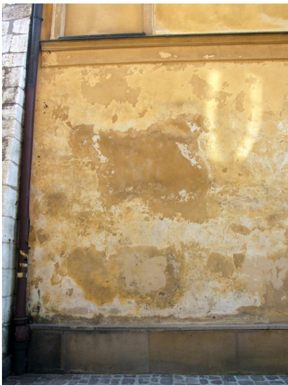
52. Kraków, ul.Kanonicza 1, elewacja północna od strony ul.Senackiej. Zaplamienia i złuszczenia farb elewacyjnych i tynków w rejonie uszkodzonej rury spustowej.
