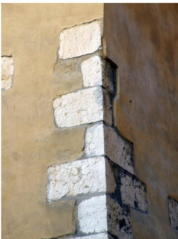
47. Kraków, ul.Kanonicza 1, narożnik północno-wschodni. Ciosy wapienia powyżej szkarpy - spoinowanie wykonane szarą zaprawą cementową.
