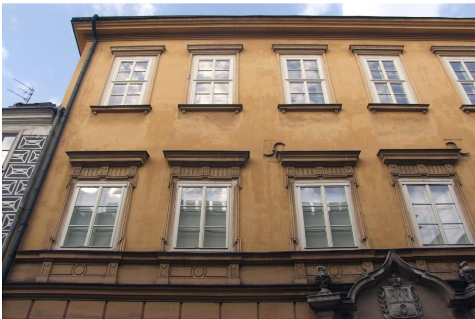
4. Kraków, ul.Kanonicza 1, fasada. Widoczne przebarwienia i zaplamienia farb elewacyjnych.
