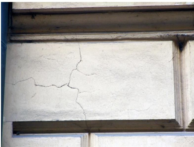
31. Kraków, ul.Kanonicza 1, fasada. Spękania tynków boniowania.
