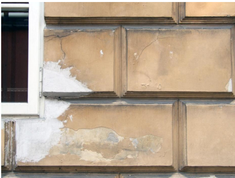
34. Kraków, ul.Kanonicza 1, fasada. Niestaranne uzupełnienia gipsem boniowania wokół okien parteru.
