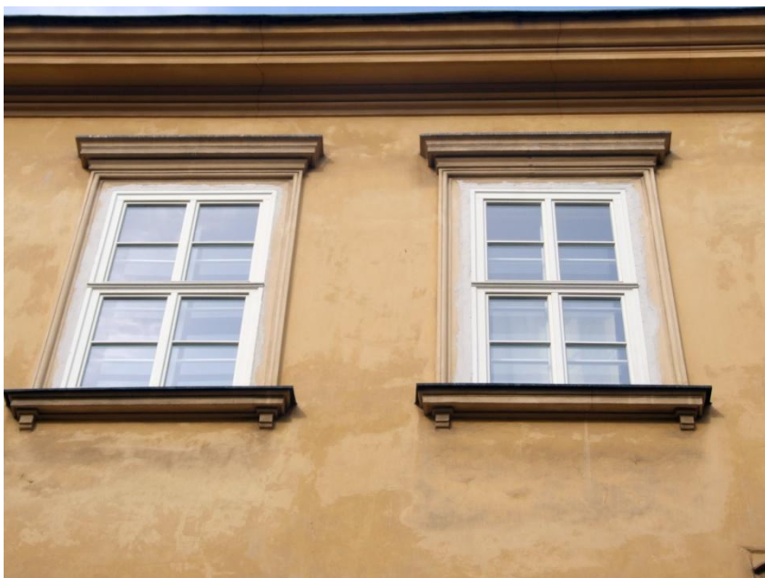
43. Kraków, ul.Kanonicza 1, fasada. Przebarwienia i zaplamienia farb elewacyjnych.
