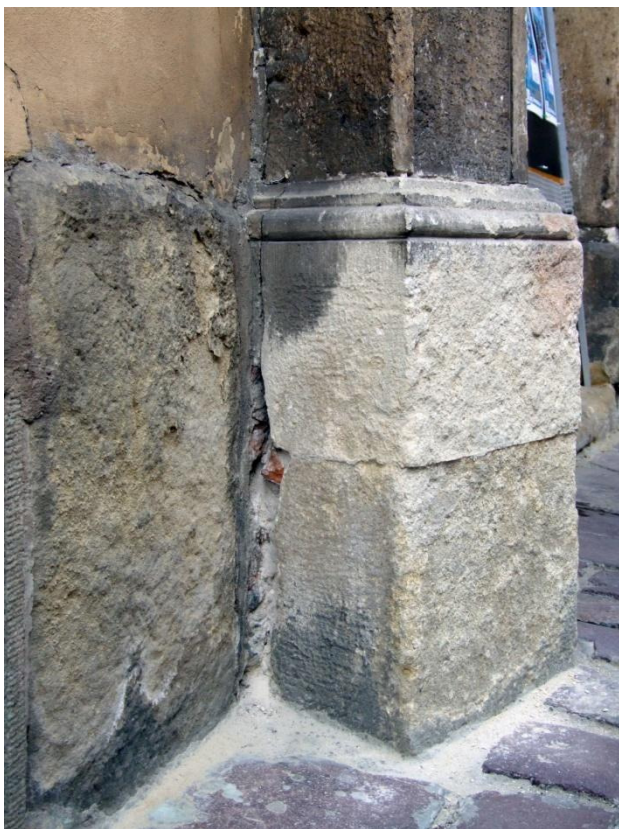
24. Kraków, ul.Kanonicza 1, fasada. Portal, węgar południowy - osypywanie się kamienia.
