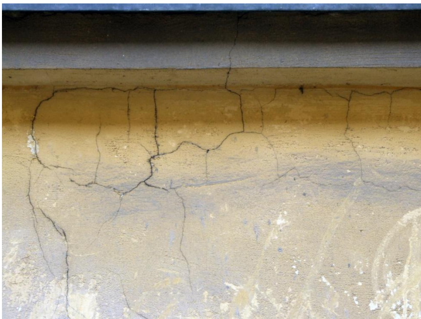
68. Kraków, ul.Kanonicza 1, elewacja północna od strony ul.Senackiej. Sieć spękań poniżej gzymsu kordonowego.
