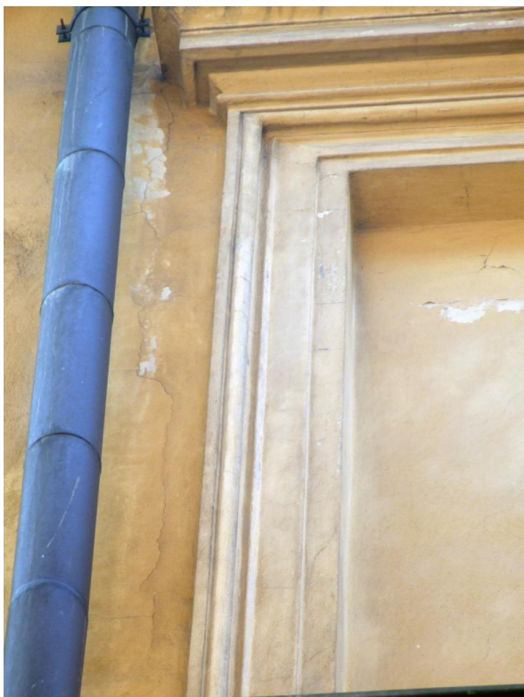
54. Kraków, ul.Kanonicza 1, elewacja północna od strony ul.Senackiej. Zacieki, spękania i złuszczenia farb elewacyjnych wzdłuż rury spustowej.
