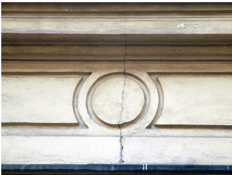
9. Kraków, ul.Kanonicza 1, fasada. Spękania płyciny podokiennej.
