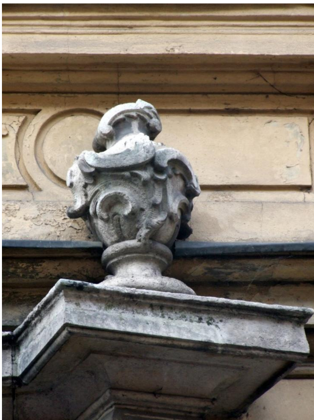
15. Kraków, ul.Kanonicza 1, fasada. Złuszczenia farb elewacyjnych w części ściany za wazonem północnym w zwieńczeniu portalu związane zapewne z wadliwym wyprofilowaniem obróbki blacharskiej gzymsu.
