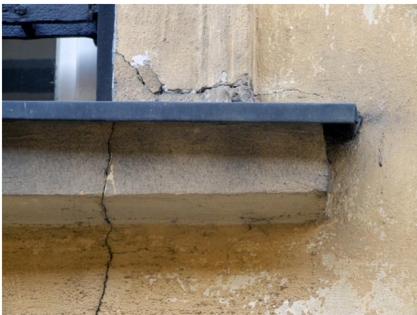
66. Kraków, ul.Kanonicza 1, elewacja północna od strony ul.Senackiej. Spękania obramienia okiennego i podokiennika.
