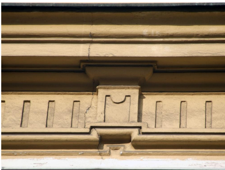
10. Kraków, ul.Kanonicza 1, fasada. Spękania w nadprożu okna I piętra.
