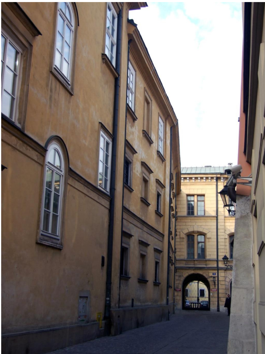
56. Kraków, ul.Kanonicza 1, elewacja północna od strony ul.Senackiej. Widoczny pas zniszczeń tynków ponad okładziną cokołu.
