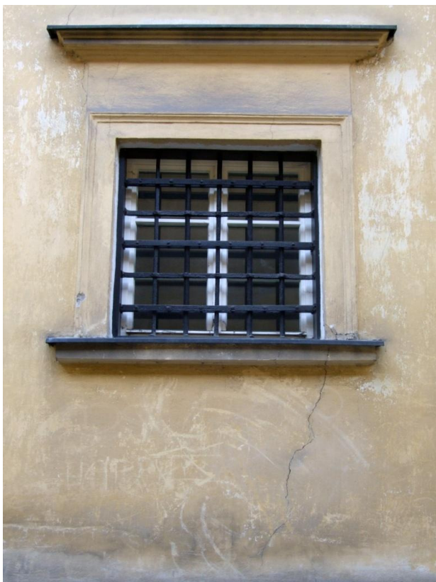
65. Kraków, ul.Kanonicza 1, elewacja północna od strony ul.Senackiej. Spękanie o przebiegu ukośnym biegnące od zachodniej części obramienia okna, przez podokiennik, w stronę cokołu.
