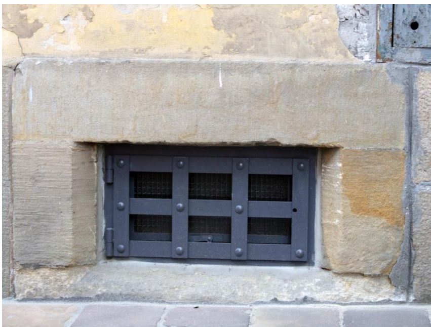
35. Kraków, ul.Kanonicza 1, fasada. Obramienie okienka piwnicznego - zniszczenia ciosu zlokalizowanego bezpośrednio wzdłuż podłoża.
