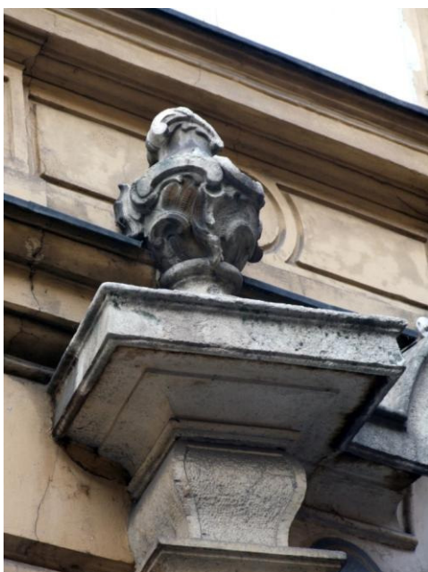
16. Kraków, ul.Kanonicza 1, fasada. Spękania ściany w rejonie zwieńczenia południowego węgara portalu.
