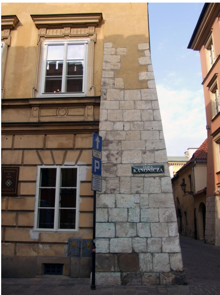
44. Kraków, ul.Kanonicza 1, fasada. Szkarpa - widoczne zabrudzenia i ubytki szczególnie wzdłuż podłoża.
