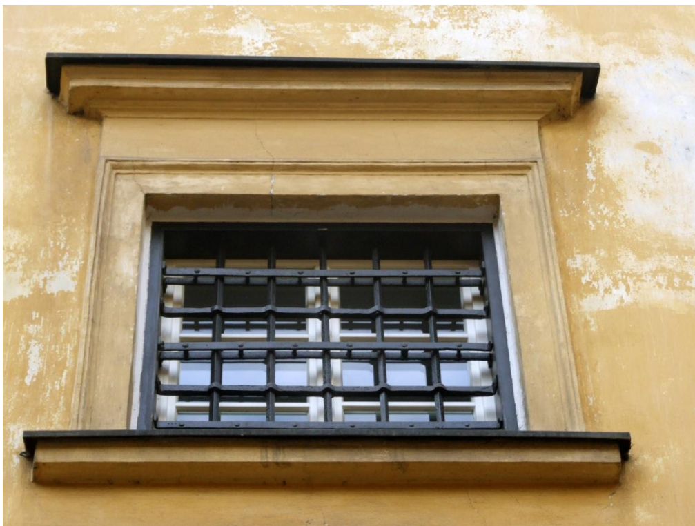
63. Kraków, ul.Kanonicza 1, elewacja północna od strony ul.Senackiej. Spękania w nadprożu okna. Wymycia farb elewacyjnych.
