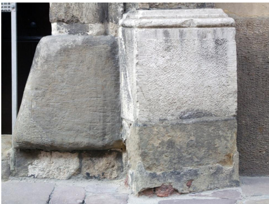
25. Kraków, ul.Kanonicza 1, fasada. Portal, węgar północny - ubytki i zabrudzenia dolnych partii węgara.
