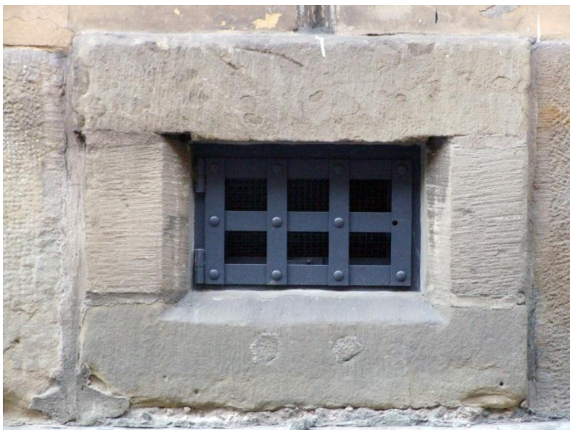
30. Kraków, ul.Kanonicza 1, fasada. Ubytki na krawędziach kamiennego obramowania okienka piwnicznego.
