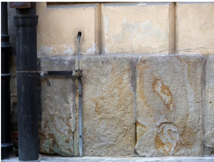
28. Kraków, ul.Kanonicza 1, fasada. Złuszczenia i rozwarstwienia ciosów cokołu po stronie południowej.
