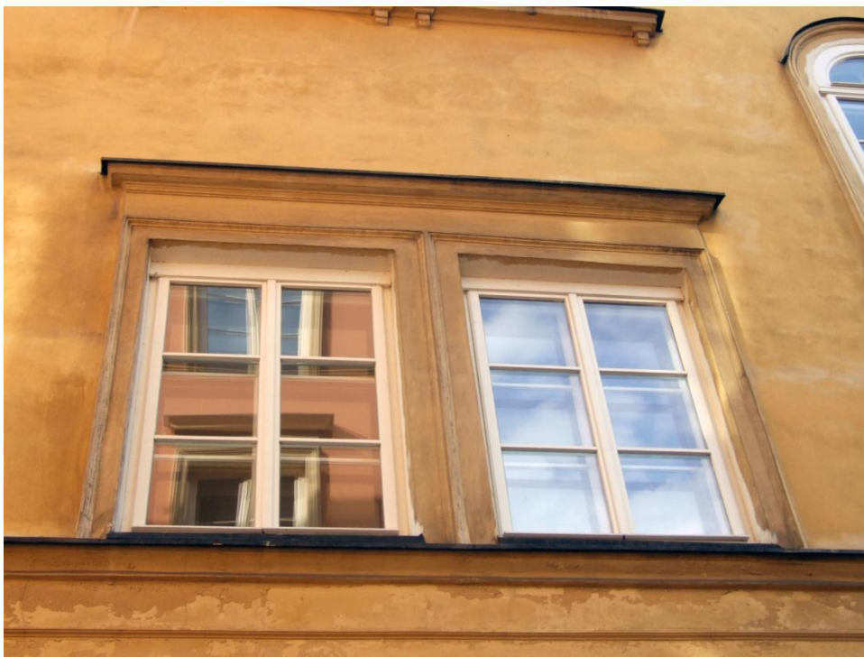
61. Kraków, ul.Kanonicza 1, elewacja północna od strony ul.Senackiej. Przebarwienia i zaplamienia farb elewacyjnych.
