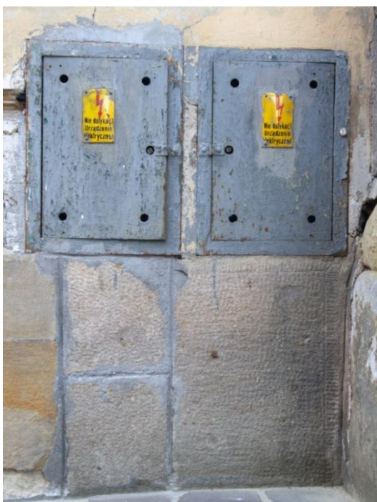
37. Kraków, ul.Kanonicza 1, fasada. Niestaranne uzupełnienia wokół skrzynek instalacyjnych, wymienione ciosy w cokole.
