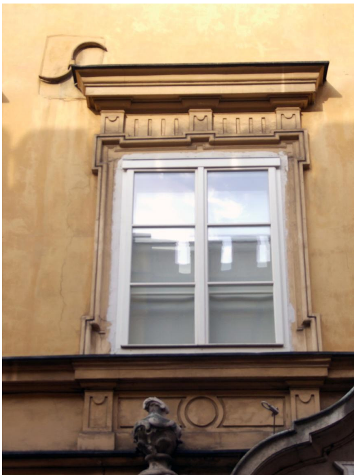
11. Kraków, ul.Kanonicza 1, fasada. Niestaranne uzupełnienia zaprawą w kolorze białym między stolarką okienną a obramieniem okiennym.
