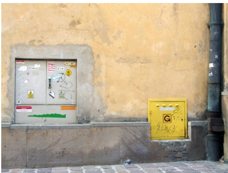
58. Kraków, ul.Kanonicza 1, elewacja północna od strony ul.Senackiej. Uszkodzenia tynku wokół szafek instalacyjnych, poniżej szafki z instalacją gazową kamienny cokół uzupełniono cegłą.
