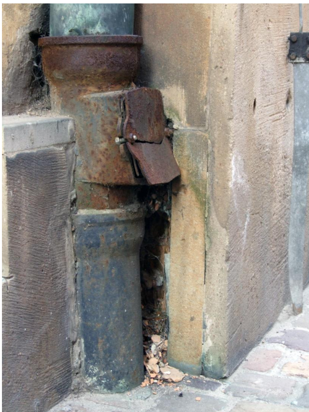
70. Kraków, ul.Kanonicza 1, elewacja północna od strony ul.Senackiej. Ubytki okładziny kamiennej i ogniska korozji biologicznej w rejonie sztendra rury spustowej.
