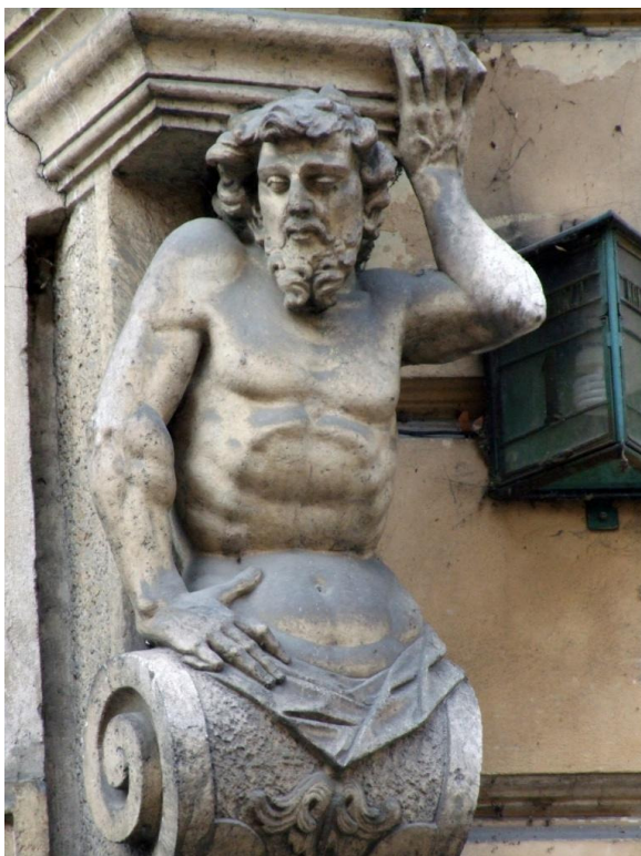
20. Kraków, ul.Kanonicza 1, fasada. Zanieczyszczenia pyliste pochodzenia wielkomiejskiego na rzeźbie w węgarze południowym portalu.
