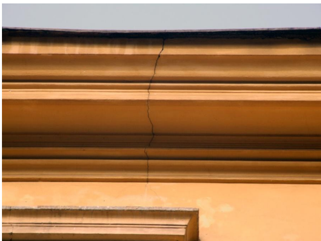
6. Kraków, ul.Kanonicza 1, fasada. Spękanie gzymsu wieńczącego.
