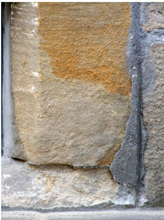
36. Kraków, ul.Kanonicza 1, fasada. Oramienie okienka piwnicznego - przebarwienia piaskowca, głębokie złuszczenia przy podłożu, odstające i wykruszone spoiny.
