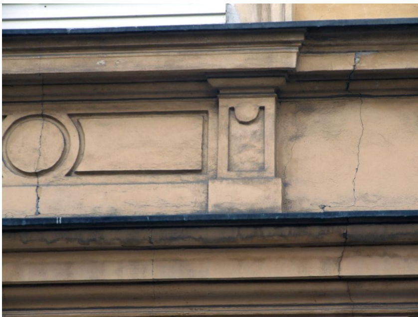
40. Kraków, ul.Kanonicza 1, fasada. Spękania elewacji o przebiegu pionowym.
