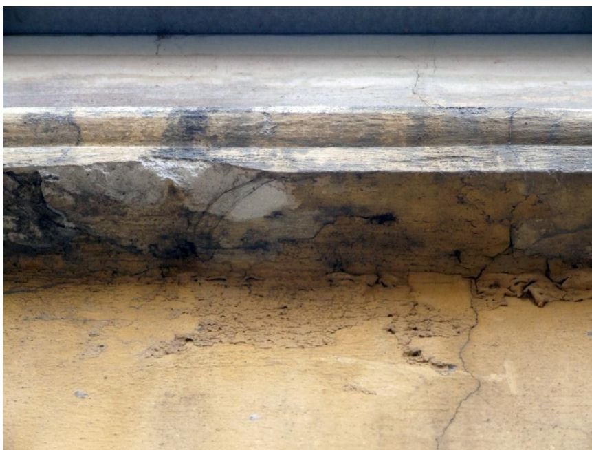
71. Kraków, ul.Kanonicza 1, elewacja północna od strony ul.Senackiej. Ubytki tynku w gsymsie kordonowym.
