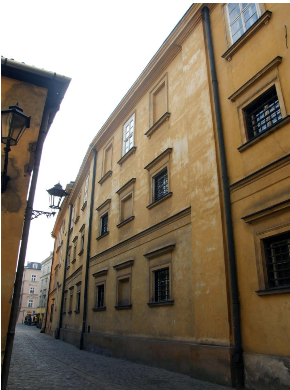
69. Kraków, ul.Kanonicza 1, elewacja północna od strony ul.Senackiej - widok w stronę wschodnią. Widoczne wypłukania i zaplamienia farb elewacyjnych oraz złuszczenia w pasie nad cokołem.
