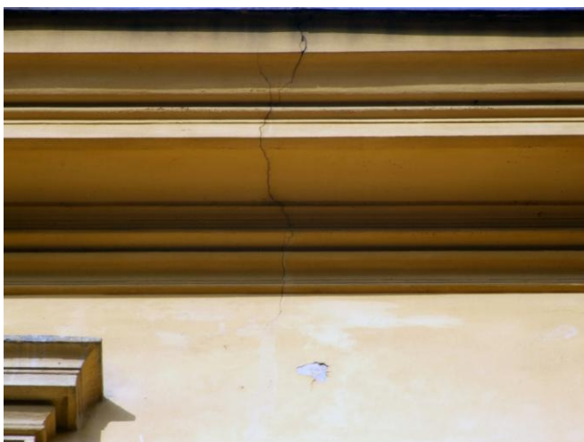
8. Kraków, ul.Kanonicza 1, fasada. Spękania gzymsu wieńczącego.
