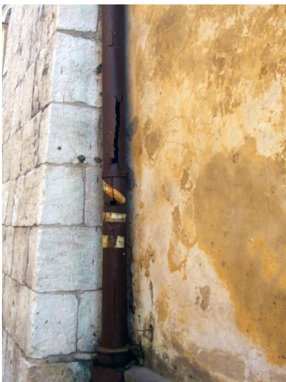
53. Kraków, ul.Kanonicza 1, elewacja od strony ul.Senackiej. Zniszczenia farb elewacyjnych i tynków w rejonie skorodowanej rury spustowej.
