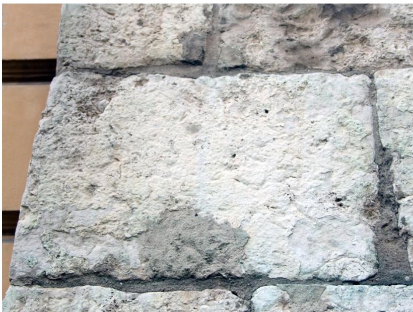
46. Kraków, ul.Kanonicza 1, fasada. Zmienione kolorystycznie uzupełnienia kamienia.
