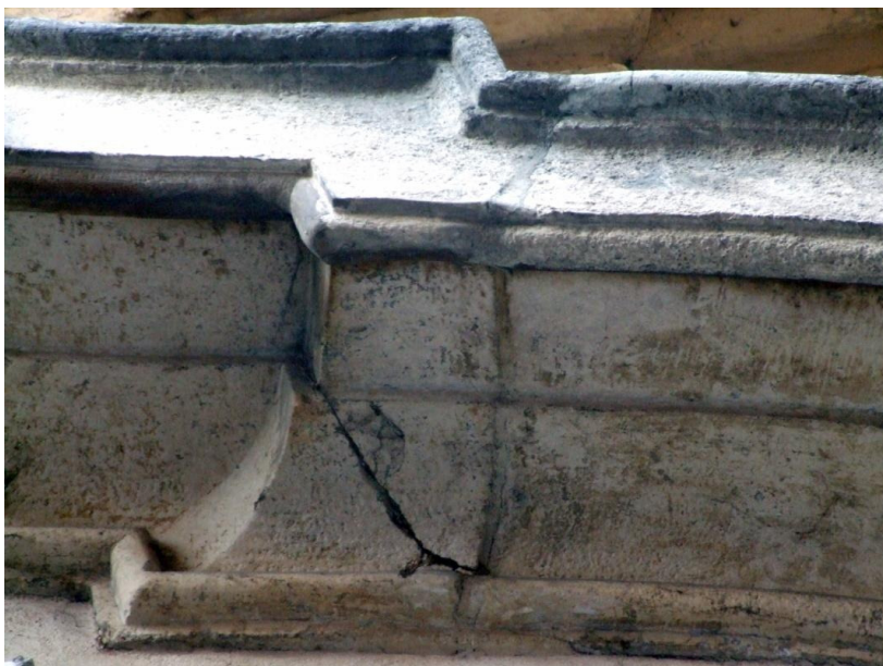
32. Kraków, ul.Kanonicza 1, fasada. Spękania kamieniarki portalu od strony wewnętrznej.
