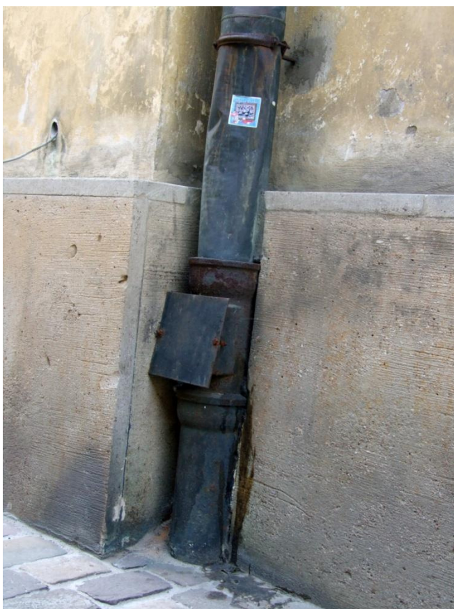
60. Kraków, ul.Kanonicza 1, elewacja północna od strony ul.Senackiej. Zabrudzenia i ubytki okładziny kamiennej w rejonie sztyndra rury spustowej.
