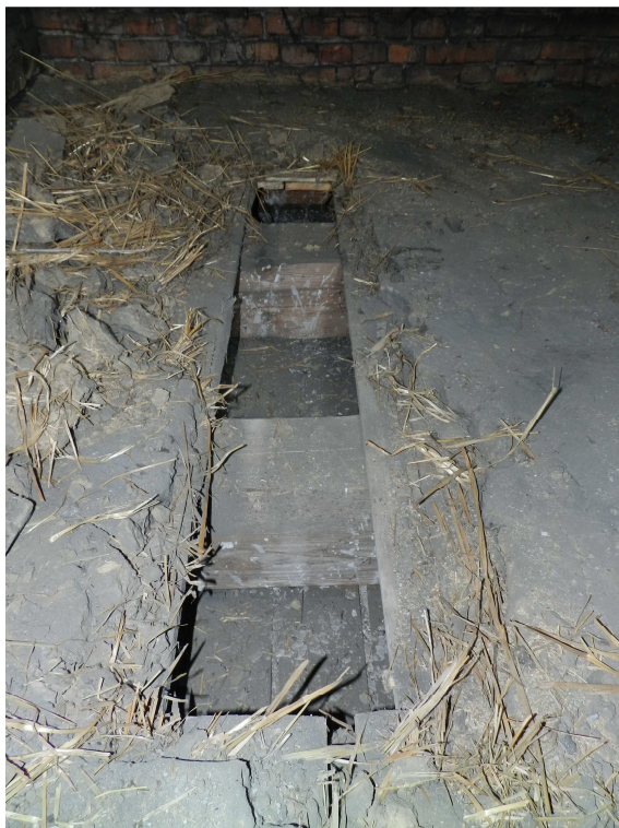
fot.5. Odkrywka w stropie drewnianym strychowym po stronie północno - wschodniej (odkrywka nr 2)
