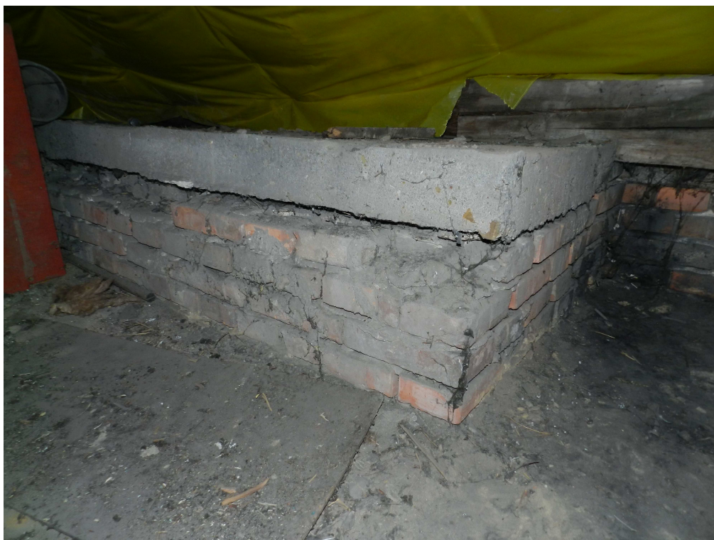
fot.16. Odspojenie żelbetowej płyty gzymsu od murowanych ścianek kolankowych.
