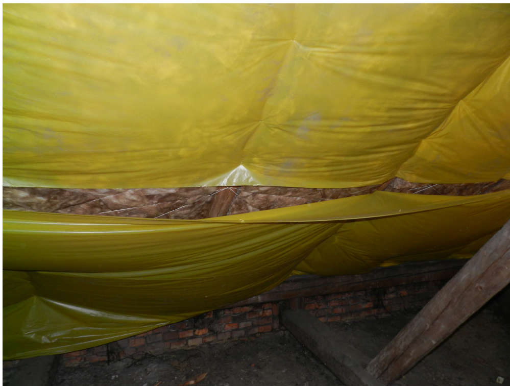
fot.13. Miejsce nieszczelnego montażu folii paroszczelnej.
