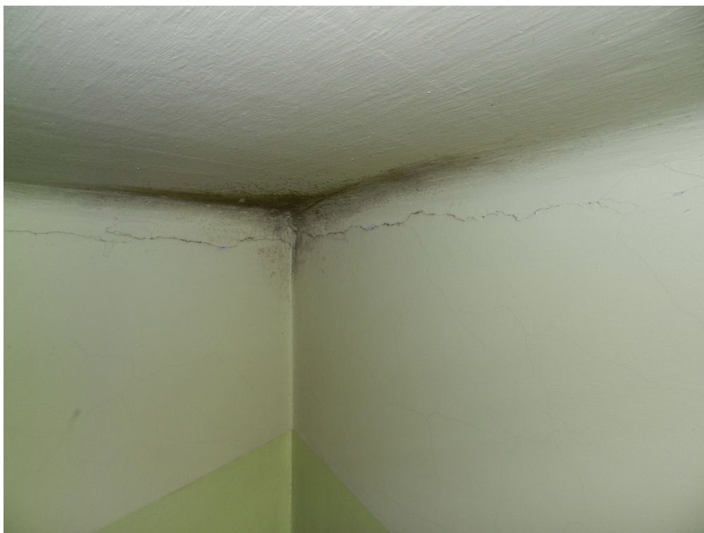
fot.20. Odspojenie betonowej płyty stropowej od ściany murowanej nad klatką schodową (widok od wewnątrz klatki schodowej).
