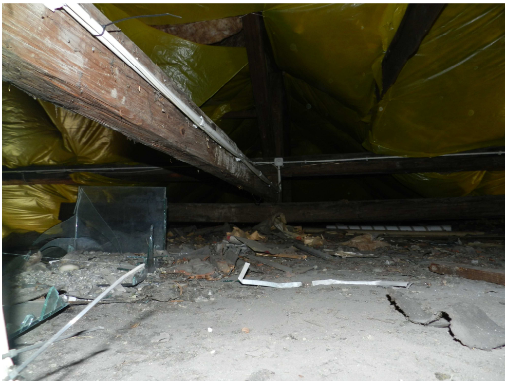
fot.21. Ugięta belka drewniana pod słupem lukarny nad klatką schodową.
