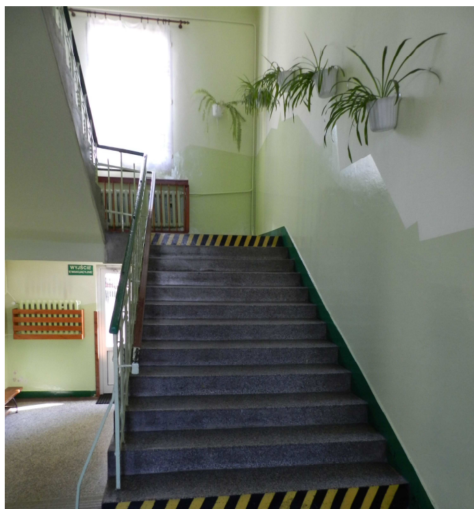
fot.22. Klatka schodowa w konstrukcji żelbetowej płytowo - belkowej.
