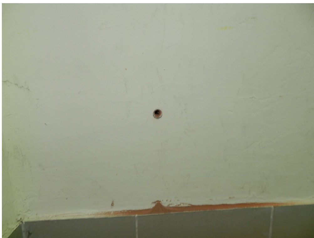
fot.2. Odwiert w ścianie nośnej poprzecznej w kondygnacji piwnic.
