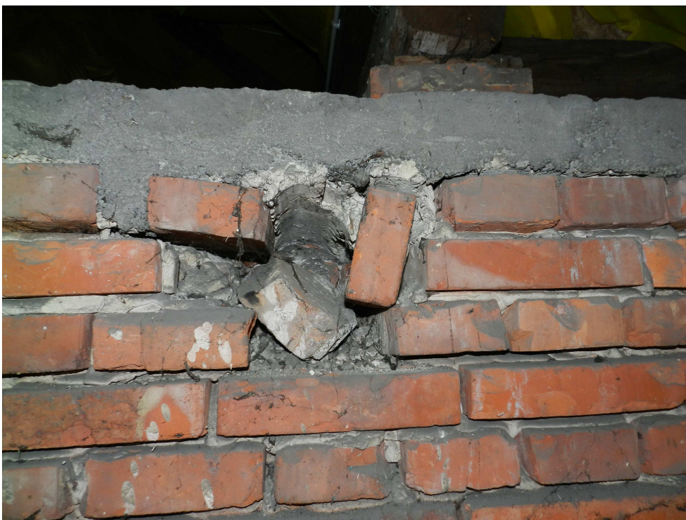
fot.18. Gniazdo po usuniętej belce stalowej stropu nad klatką schodową.
