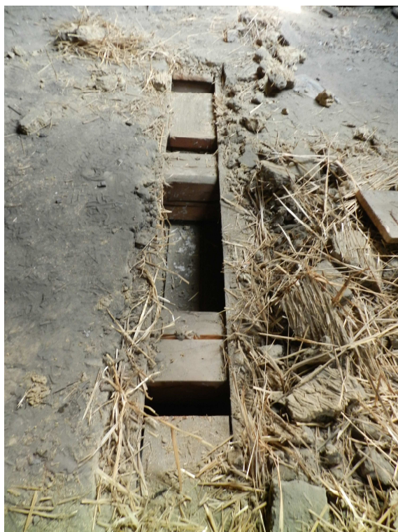
fot.4. Odkrywka w stropie drewnianym strychowym po stronie wschodniej (odkrywka nr 1)
