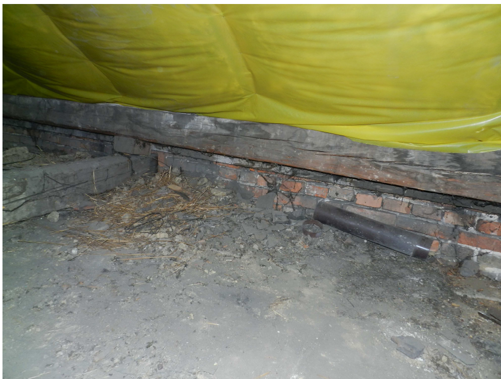
fot.14. Ścianka kolankowa murowana z cegły pełnej.
