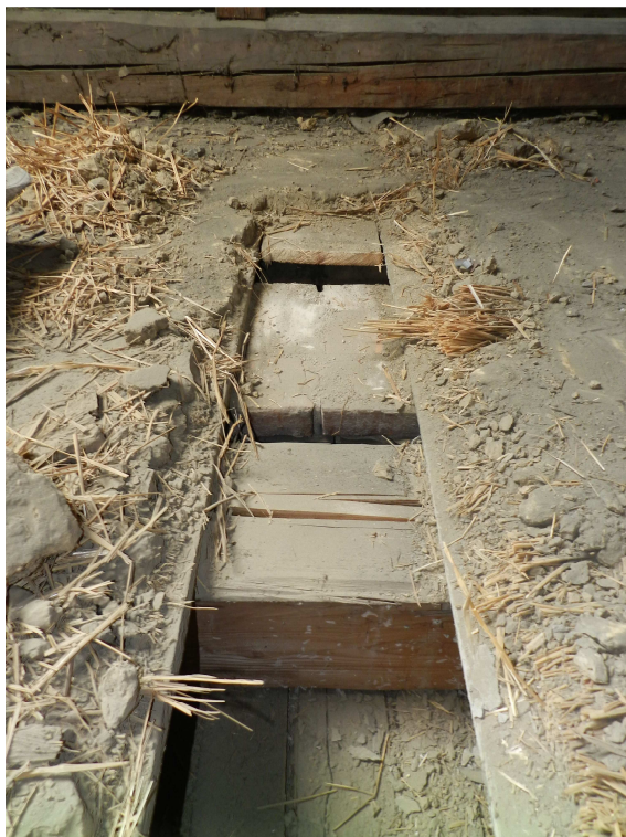
fot.7. Podmurowana ściana poprzeczna do poziomemu deskowaniu górnemu.
