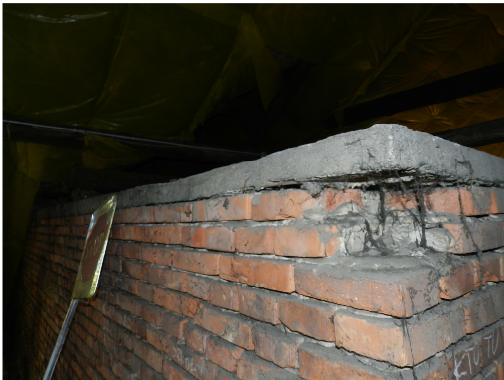
fot.19. Odspojenie betonowej płyty stropowej od ściany murowanej nad klatką schodową.
