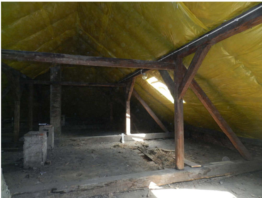
fot.9. Charakter drewnianej konstrukcji więźby dachowej.
