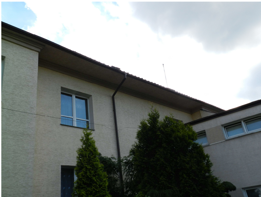
fot.15. Żelbetowy okap nad cofniętą ścianą północną.
