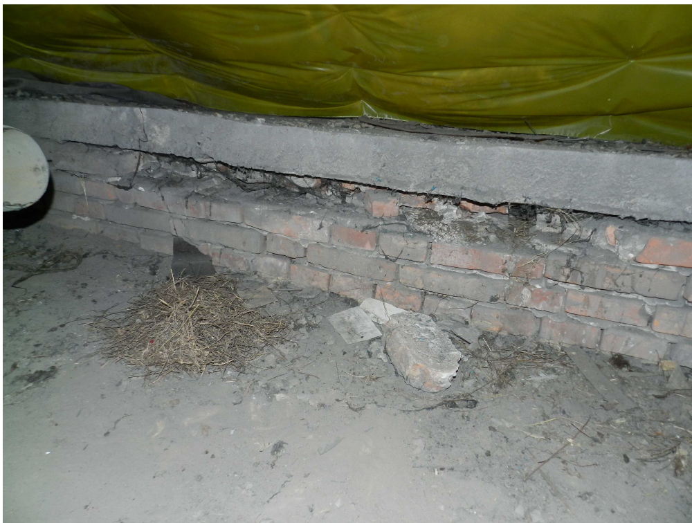
fot.17. Odspojenie żelbetowej płyty gzymsu od murowanych ścianek kolankowych.
