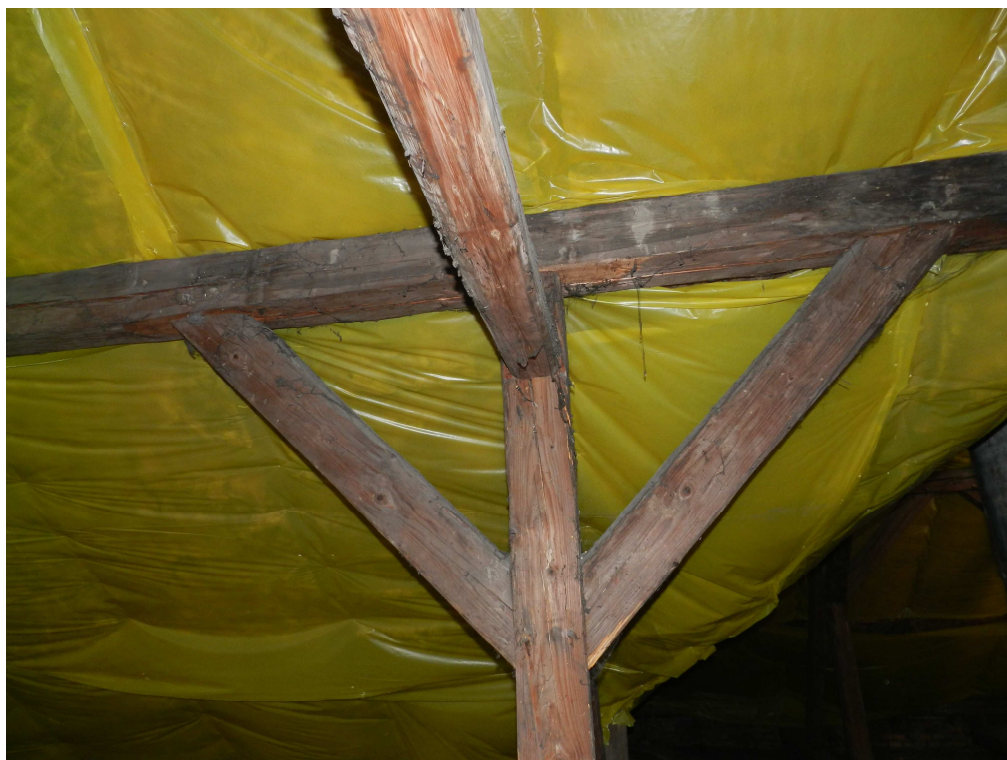
fot.12. Połączenia na czopy elementów więźby dachowej.
