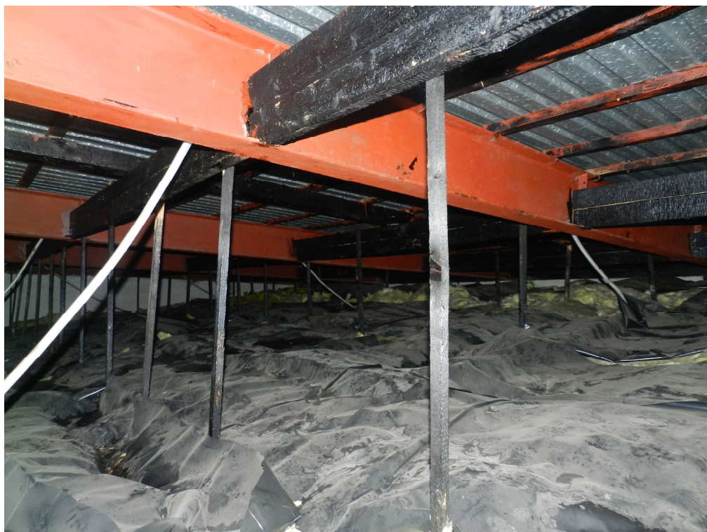
fot.6. Luźno ułożona na sufitach podwieszanych wełna mineralna oraz folia.
