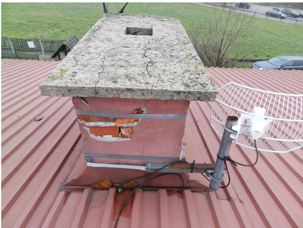
fot.16. Uszkodzenia komina ponad połacią dachową.
