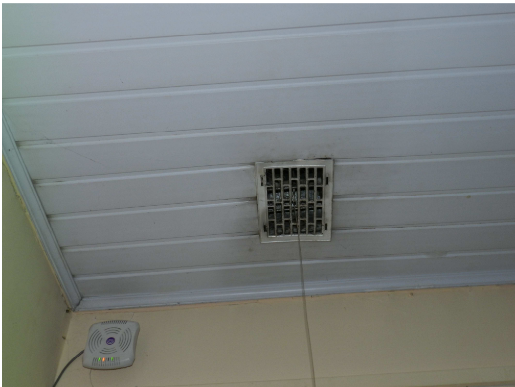
fot.15. Zabrudzenia sufitów przy kratkach wentylacyjnych.
