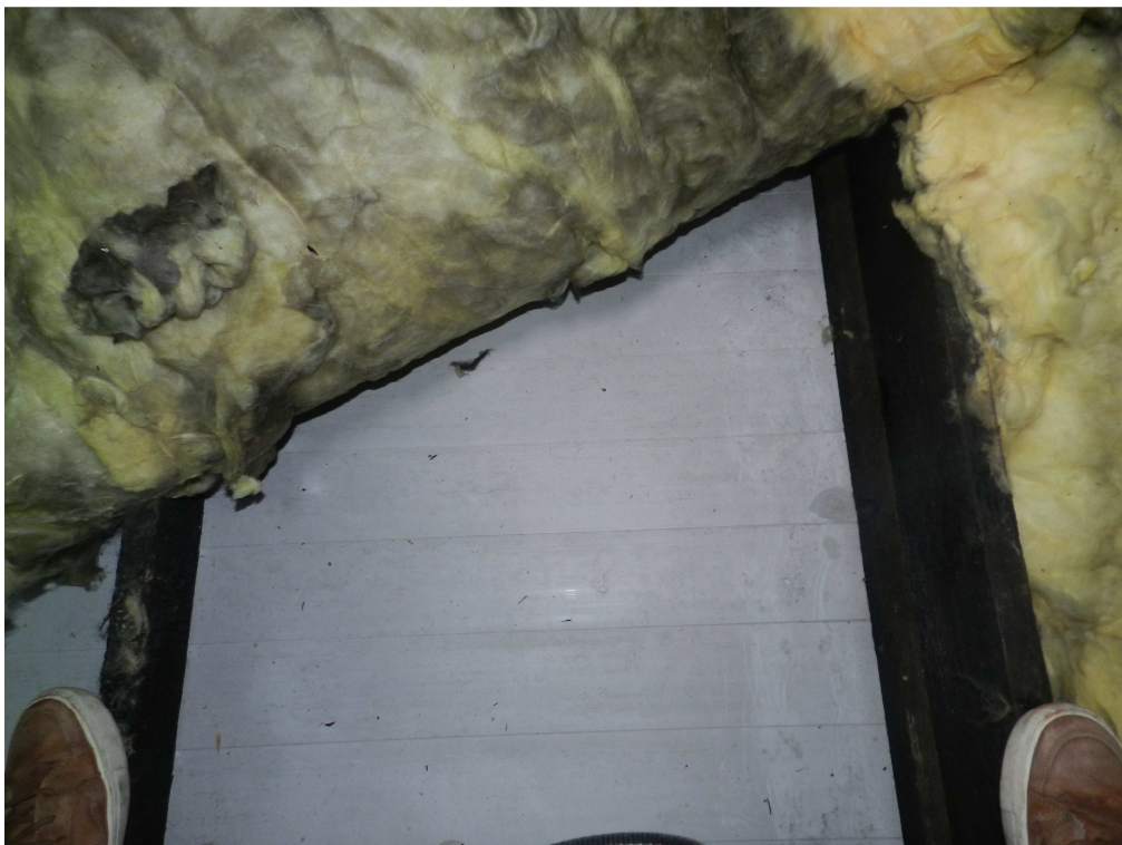
fot.5. Drewniana konstrukcja sufitów. Sufity podwieszono do konstrukcji dachu za pomocą drewnianych wieszaków.
