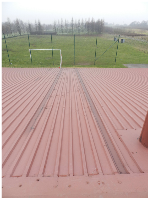
fot.11. Widoczne pasy nieszczelności blachy.
