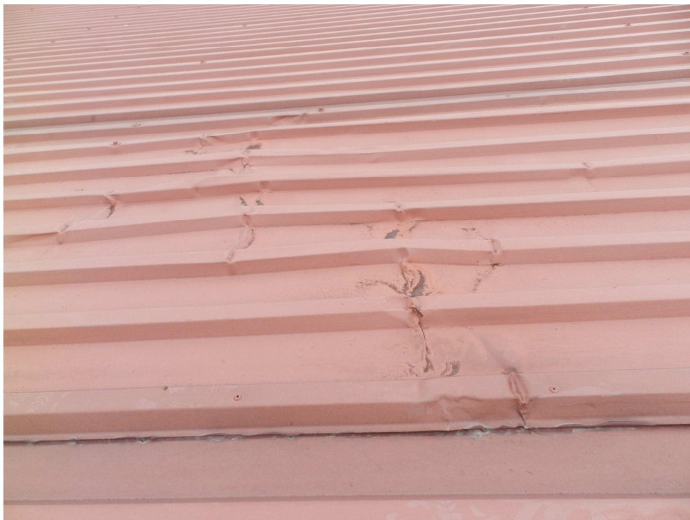
fot.9. Uszkodzenia blachy trapezowej - widoczne załamania powierzchni blachy.
