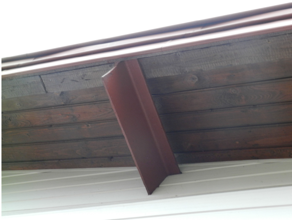
fot.4. Teowe płatwie stalowe nad frontowym fragmentem połaci południowo - zachodniej.
