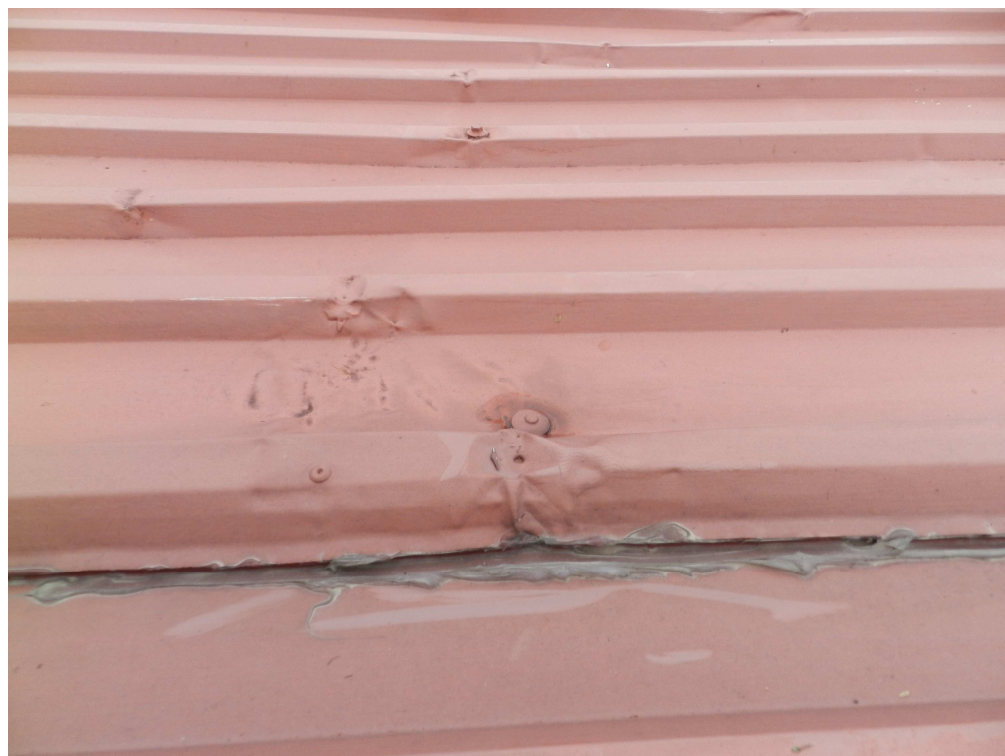
fot.10. Próba uszczelnienia połączeń blach za pomocą silikonu.
