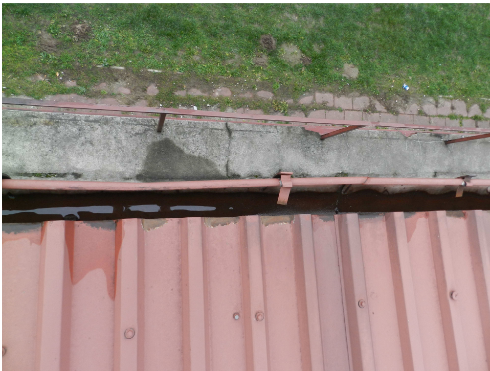
fot.13. Obecność wody w rynnie dachowej.
