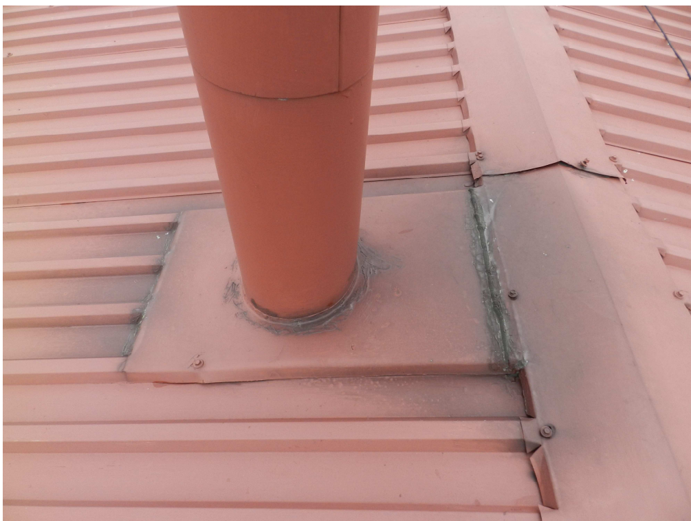
fot.14. Uszczelnienia odpowietrzników wentylacyjnych.
