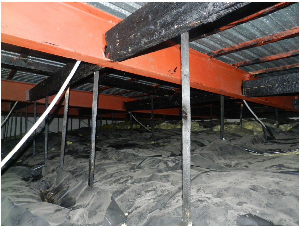
fot.2. Widok konstrukcji stalowo - drewnianej więźby dachowej na połaci południowo - zachodnią.
