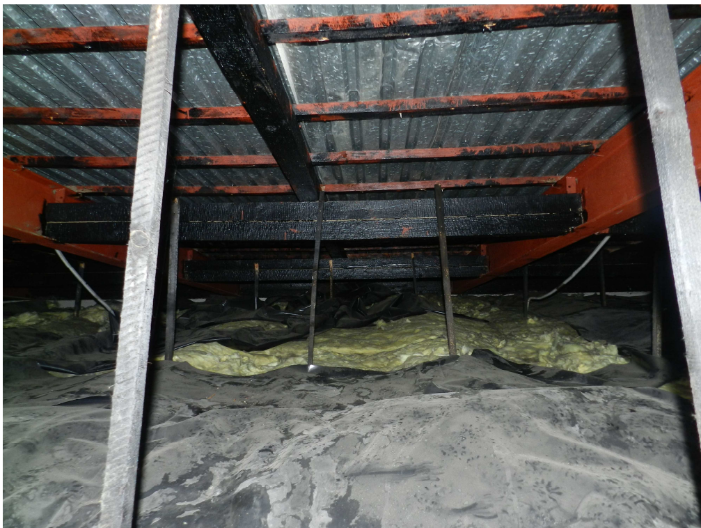
fot.3. Poprzeczny wymian drewniany i krokiew nad połacią południowo - zachodnią.
