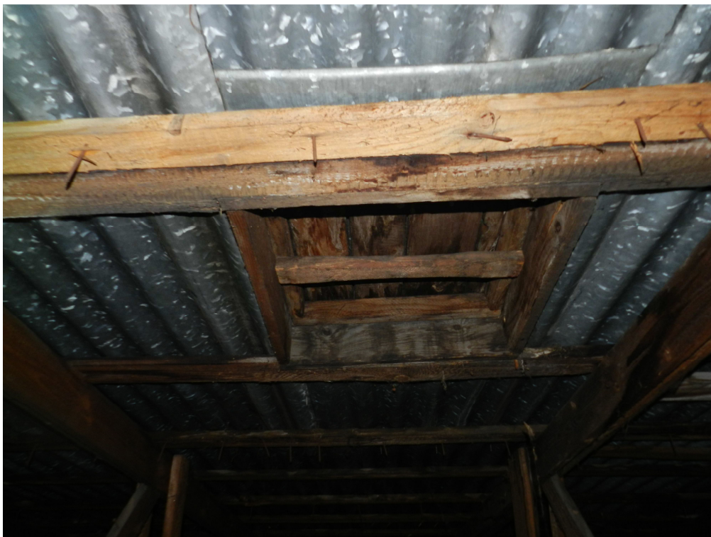
fot.10. Nieszczelny wyłaz dachowy.
