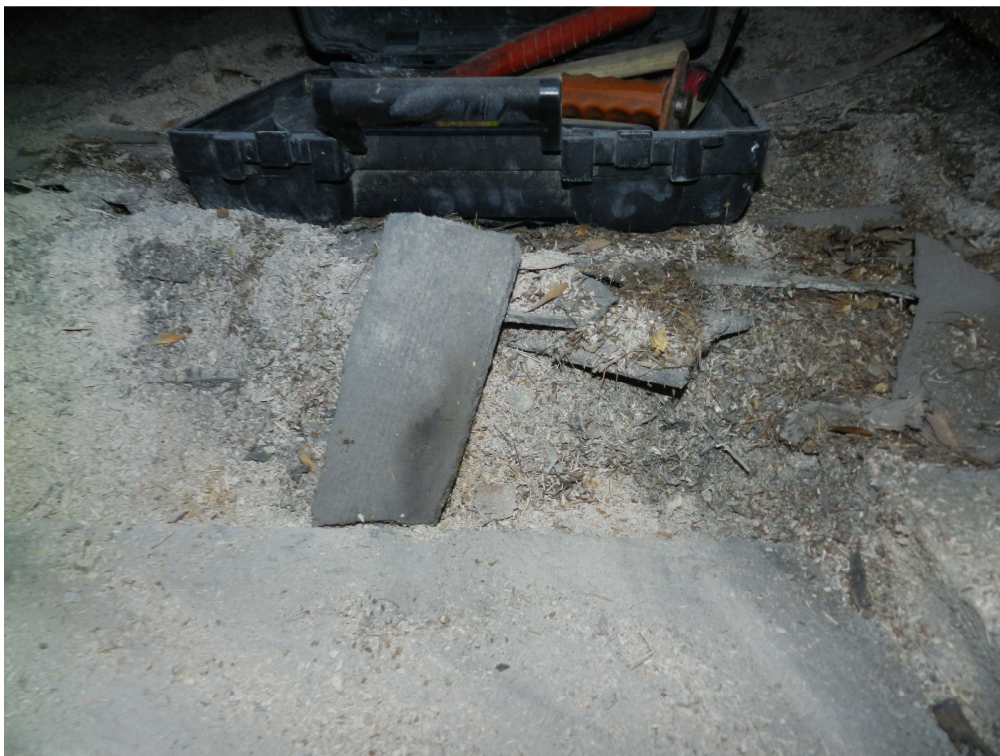
fot.16. Zasyпка gruzowa na stropie strychowym. Widoczne fragmenty poprzedniego pokrycia z eternitu oraz zasyпка z trocin.
