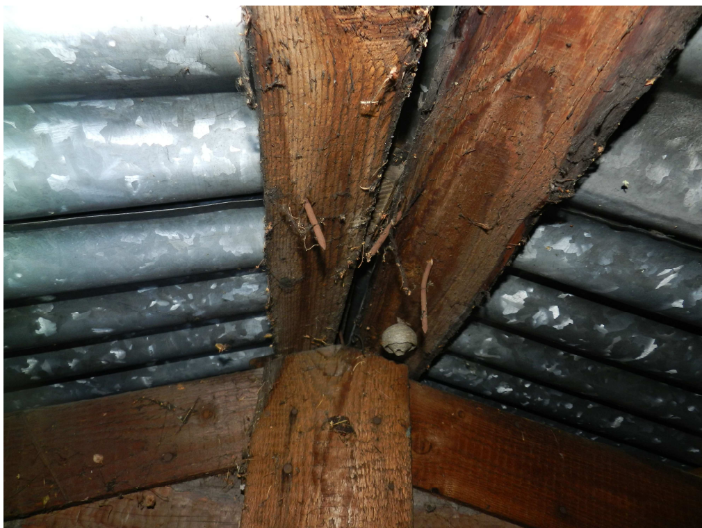
fot.15. Montaż blachy falistej na gwoździe - wystające gwoździe na znaczną długość od łat.
