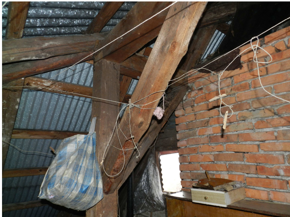
fot.21. Połączenia ciesielskie elementów drewnianych dachu w części niższej.
