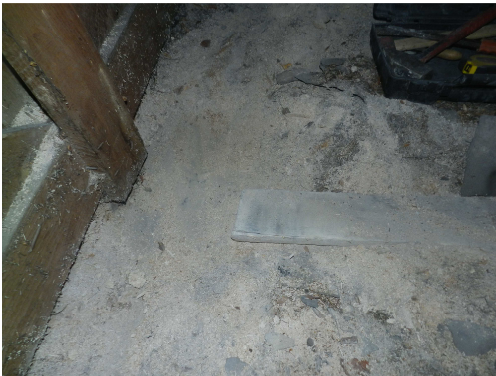
fot.4a. Oparcie kratownicy drewnianej na stropie strychowym.
