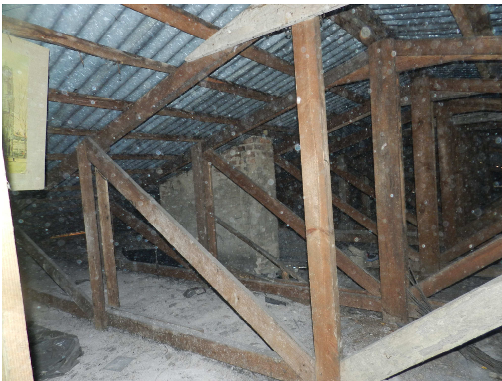
fot.4. Charakter konstrukcji więzowej, kratownicowej dachu nad częścią środkową, dwuspadową.
