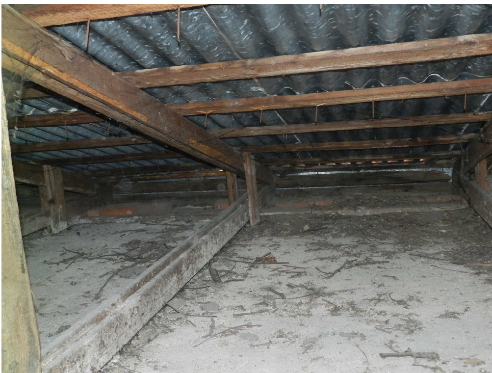
fot.13. Montaż blachy falistej na gwoździe - wystające gwoździe na znaczną długość od lat.
