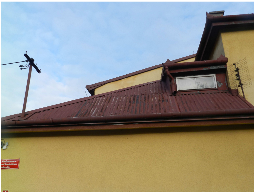
fot.22. Korozja pokrycia z blachy falistej.
