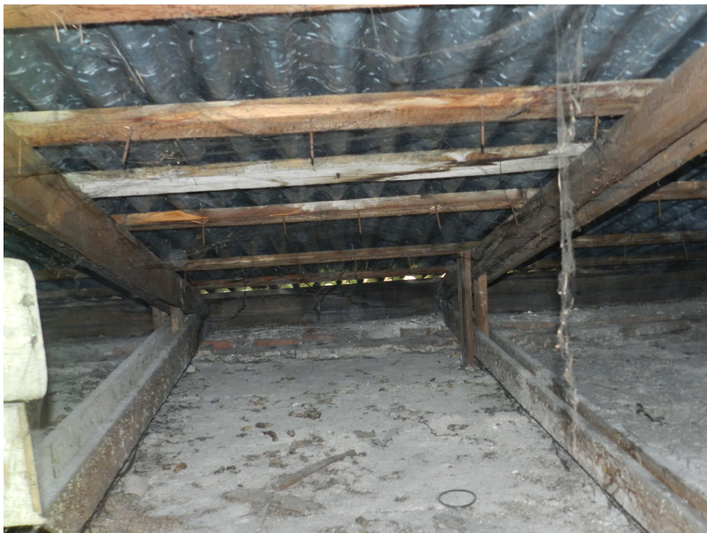
fot.14. Montaż blachy falistej na gwoździe - wystające gwoździe na znaczną długość od łat.
