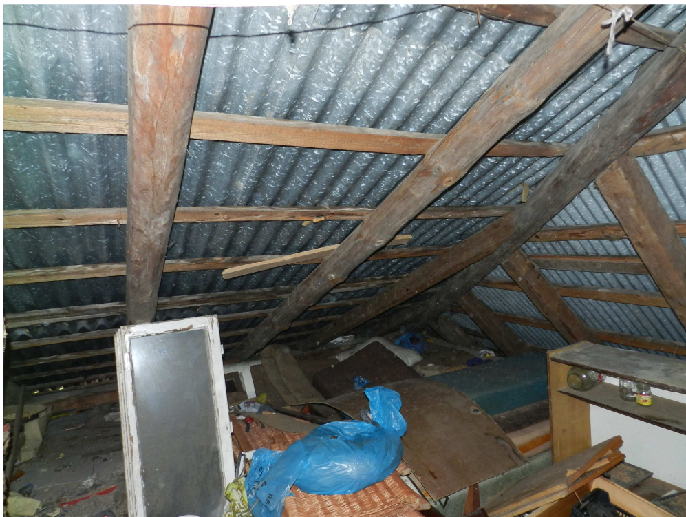
fot.20. Płatwiowo - kleszczowy charakter konstrukcji drewnianej dachów w częściach niższych.
