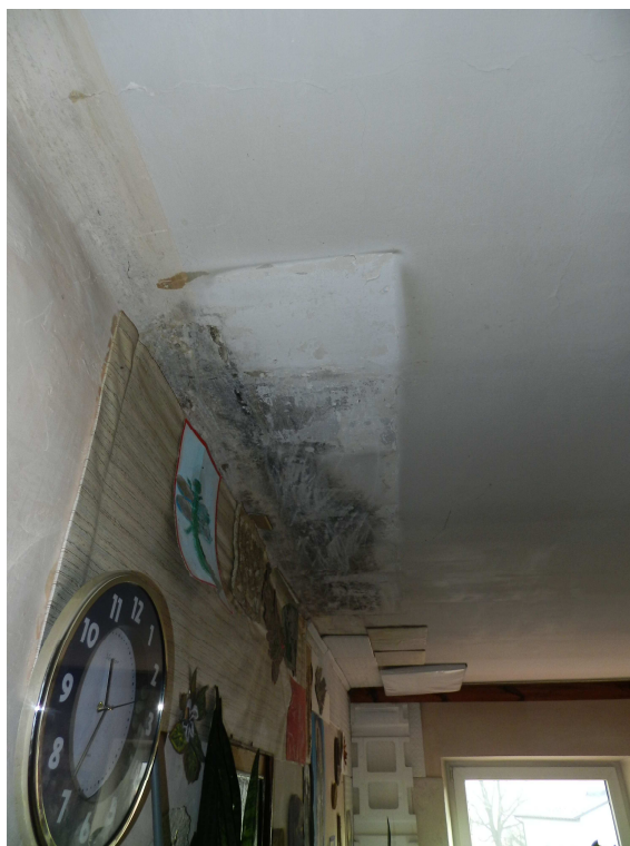
fot.17. Zawilgocenie oraz zagrzybienie ścian lokalu mieszkalnego.
