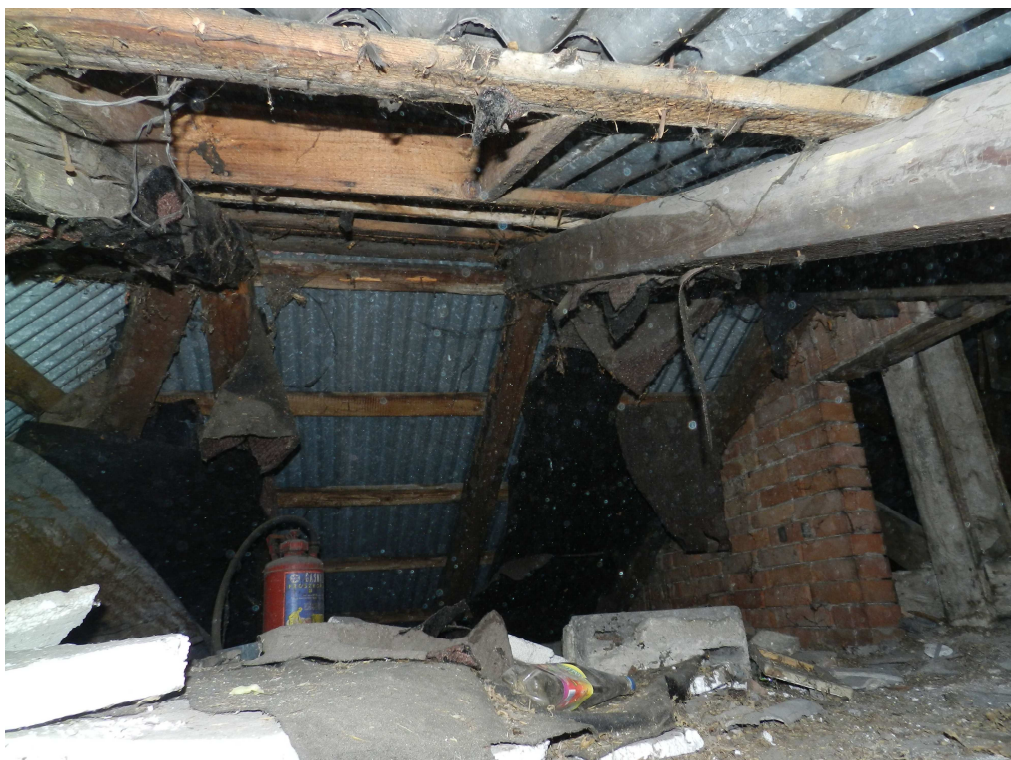
fot.9. Próba tymczasowego doszczelnienia połaci dachowej warstwą papy.
