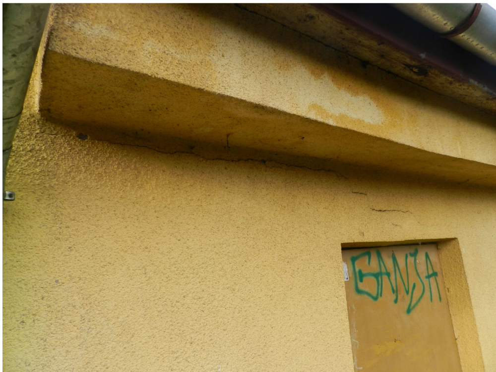
fot.24. Zarysowanie ściany zewnętrznej w skrzydle północnym.
