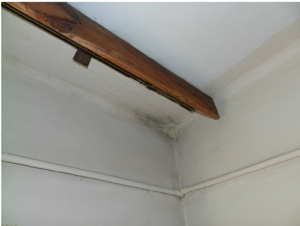
fot.18. Zawilgocenie oraz zagrzybienie sufitu oraz ścian lokalu mieszkalnego.
