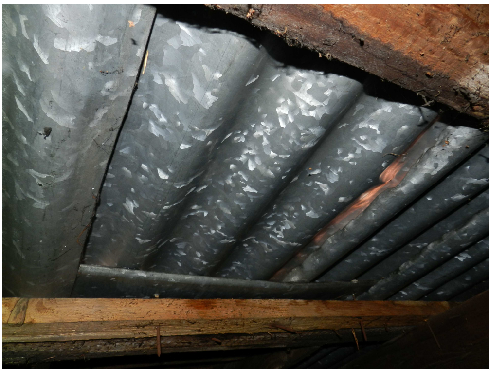
fot.7. Miejsce nieszczelności pokrycia dachowego z płyt falistych.
