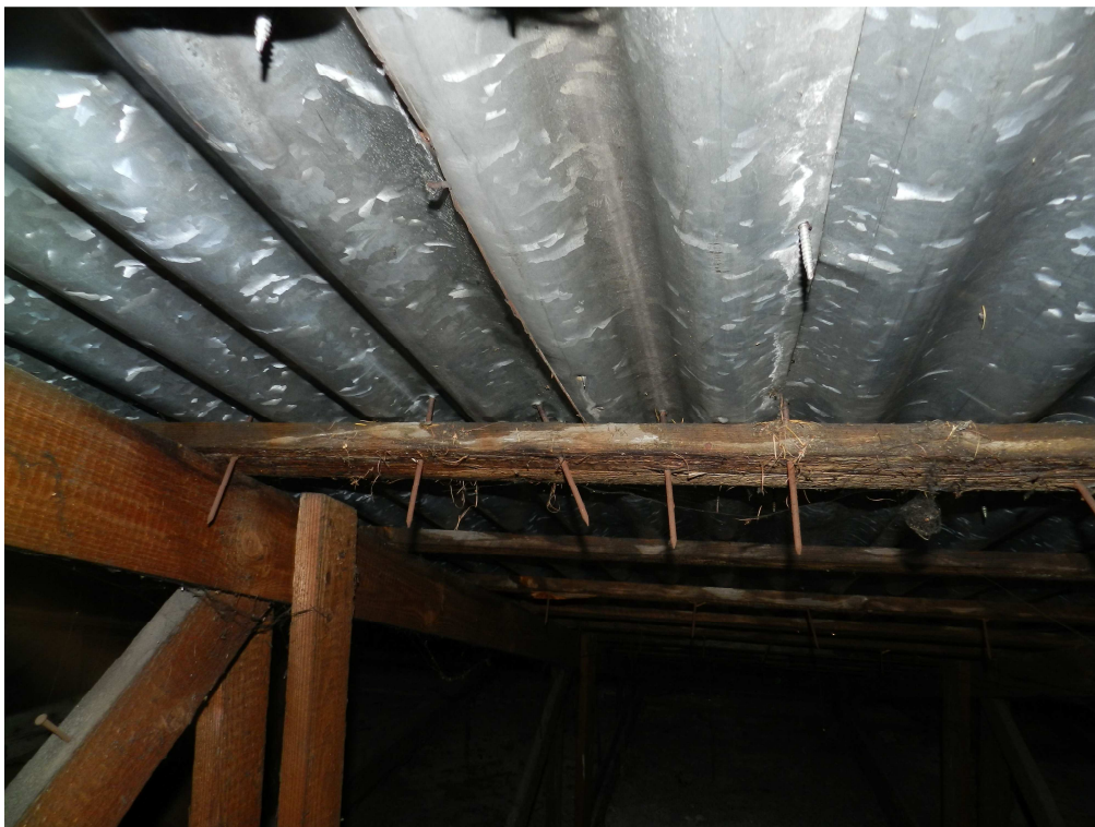
fot.8. Miejsca nieszczelności pokrycia dachowego na połączeniu płyt falistych i w miejscach przewiertów łączników.
