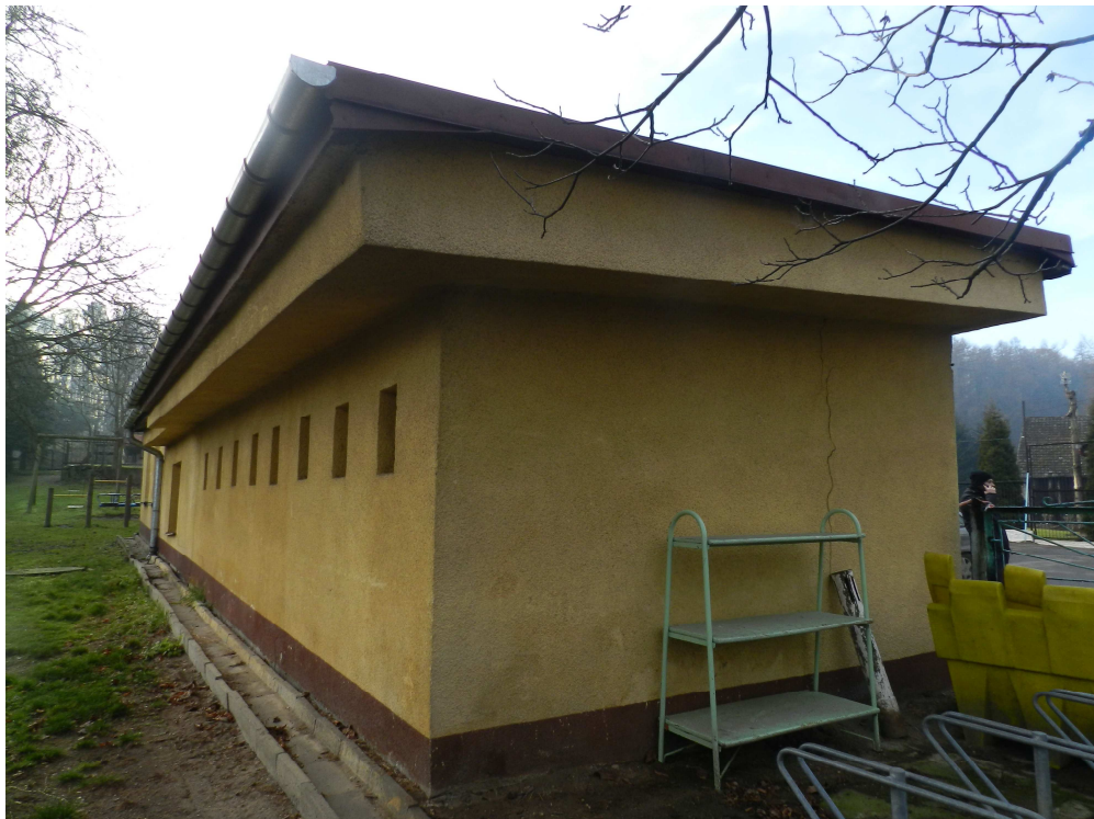
fot.23. Zarysowanie pionowe ściany zewnętrznej w skrzydle północnym.
