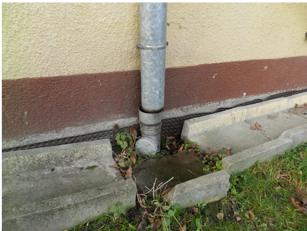
fot.11. Nieszczelna rura spustowa.
