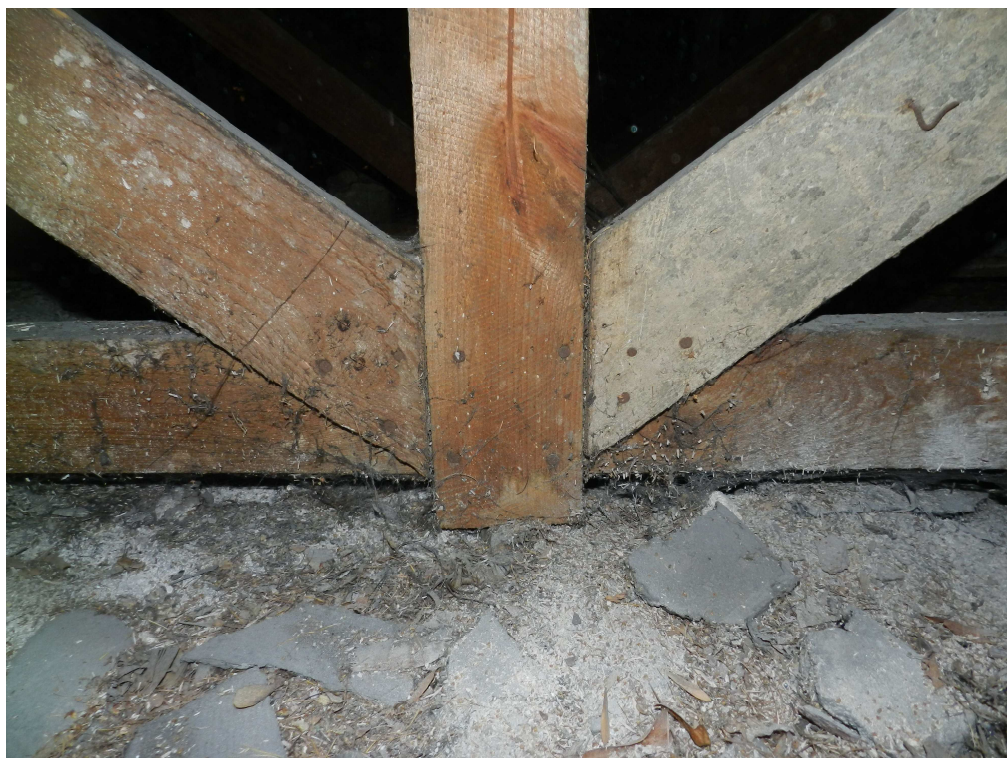
fot.5. Połączenia gwoździowane węzłów kratownic.
