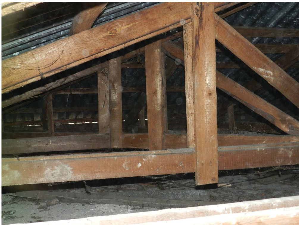
fot.6. Konstrukcja więzardowa, kratownicowa dachu nad lukarną w części południowej.
