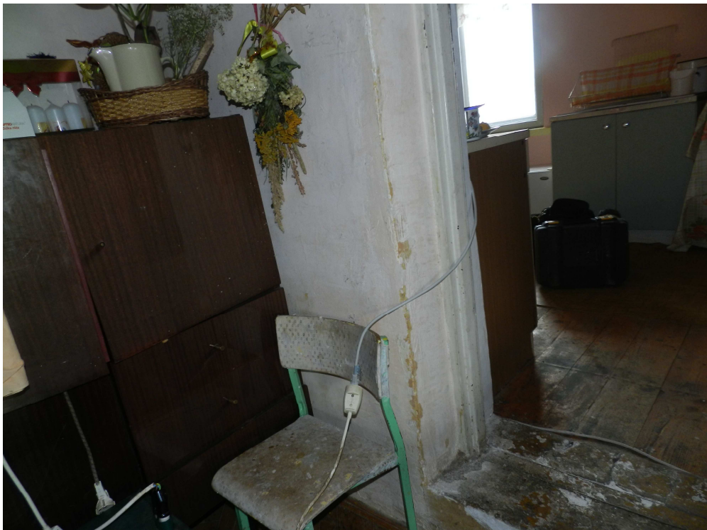
fot.19. Zawilgocenie oraz zagrzybienie ścian lokalu mieszkalnego.
