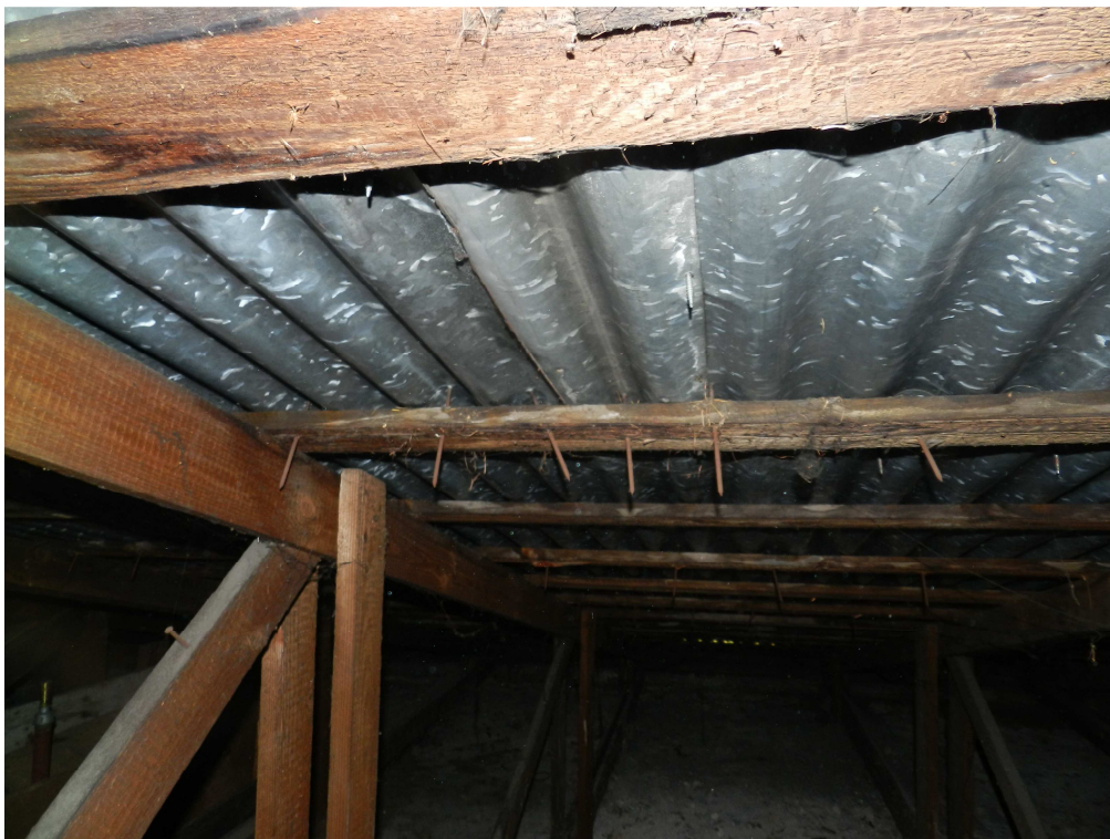
fot.12. Montaż blachy falistej na gwoździe.
