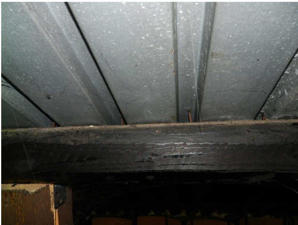
fot.15. Montaż blachy trapezowej do górnej płaszczyzny trapezów. Widoczna korozja łączników.
