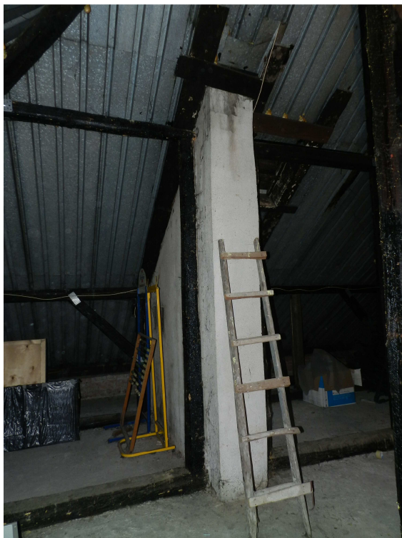
fot.7. Komin murowany w kondygnacji poddasza.
