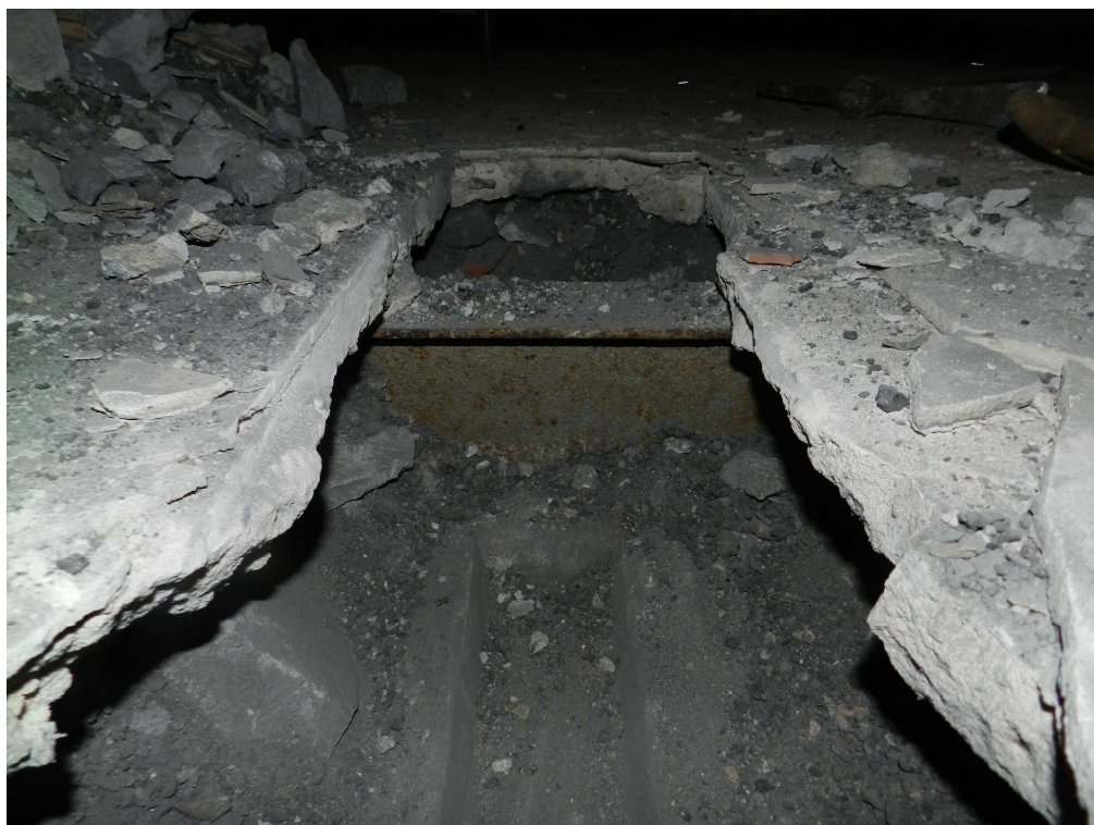
fot.4. Dwuteowa belka stalowa oraz prefabrykowane płyty betonowe stropu WPS.
