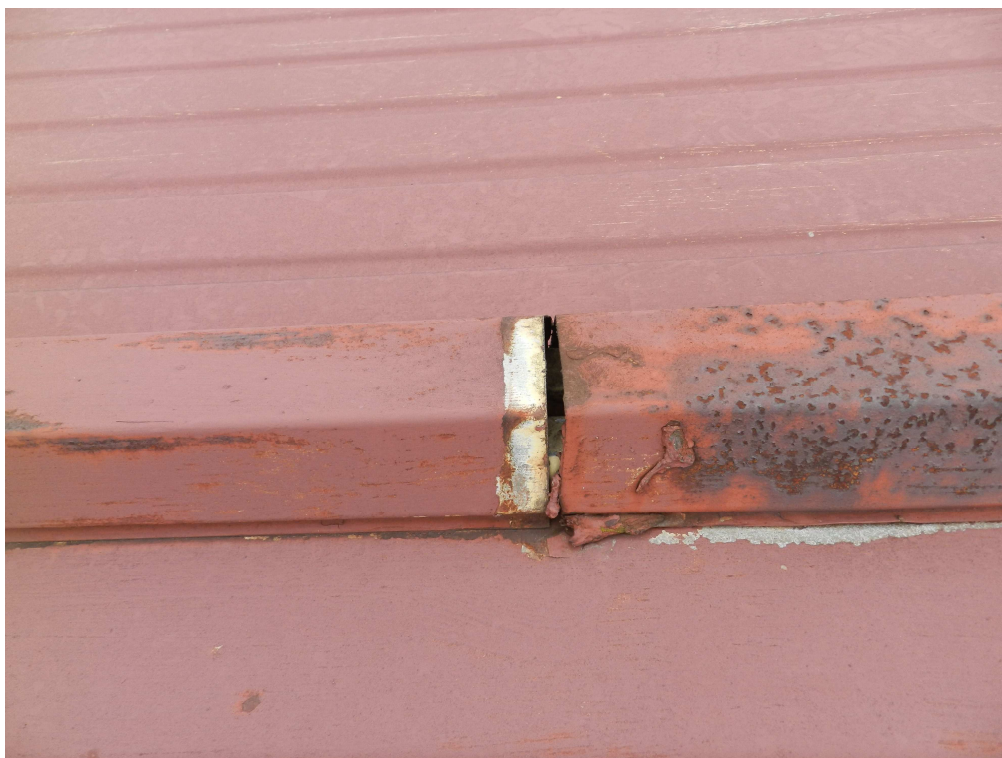
fot.29. Nieszczelność na połączeniu blach kołnierza.
