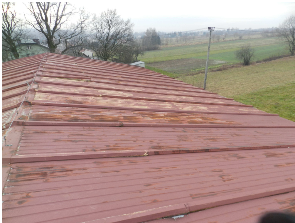
fot.27. Korozja pokrycia połaci z płyty warstwowej - dach nad salą gimnastyczną.
