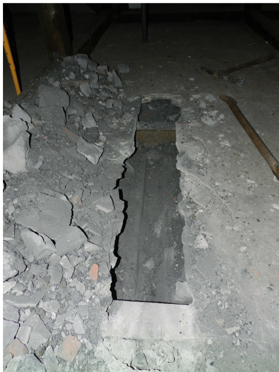
fot.3. Widok okrywki w stropie poddasza. Widoczny strop typu WPS.
