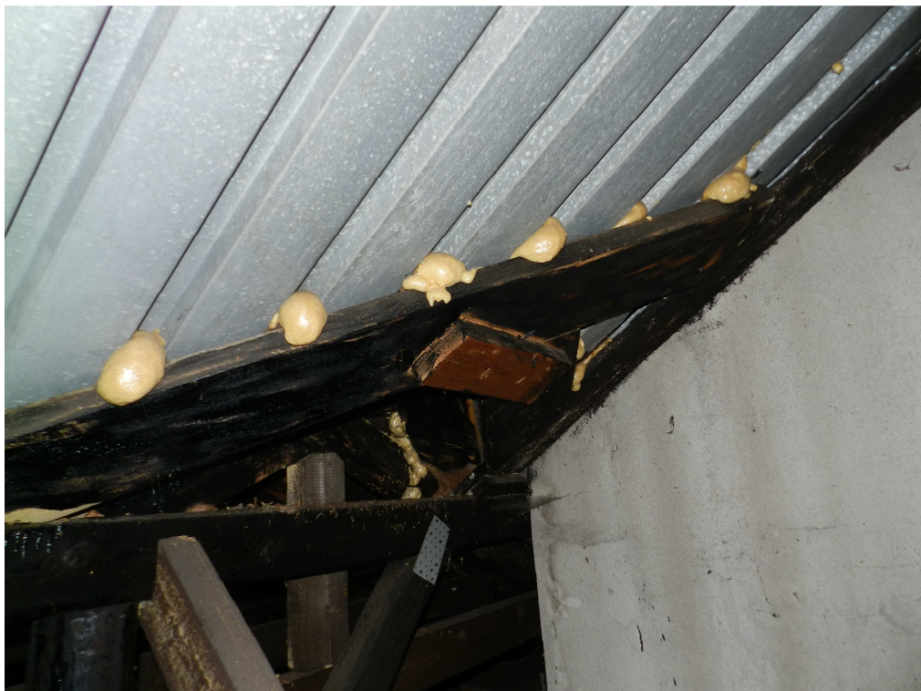
fot.13. Wadliwe uszczelnienie kosza za pomocą pianki montażowej, poliuretanowej.
