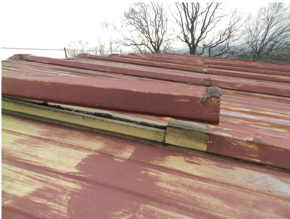
fot.32. Odstający z połączenia cały kołnierz.
