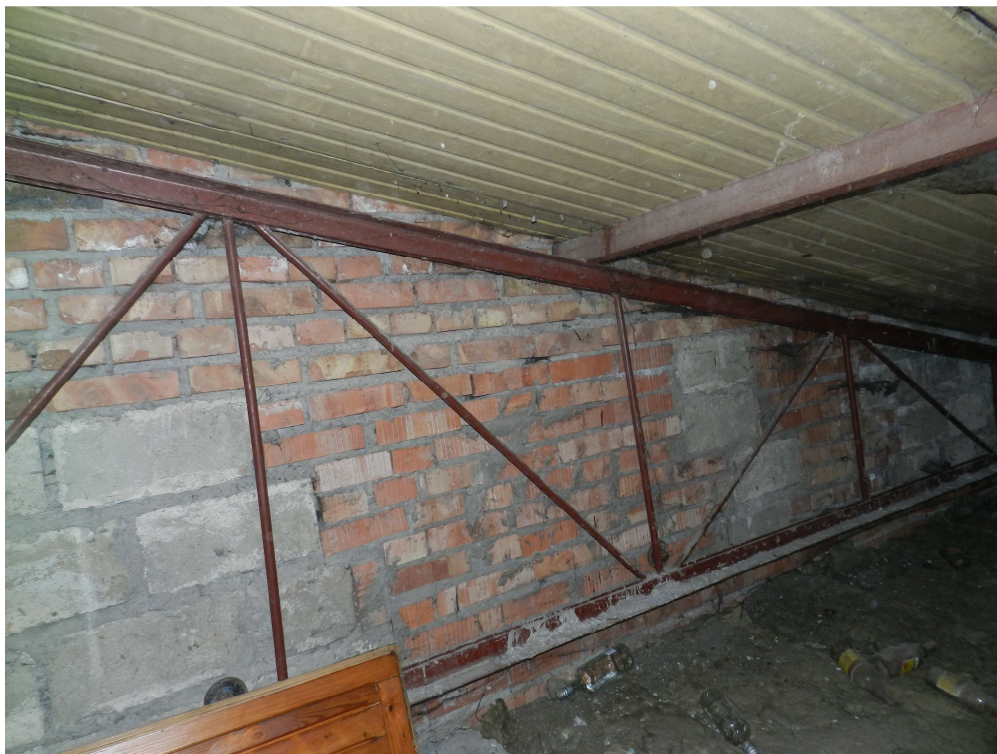
fot.36. Ściana szczytowa murowana z cegły pełnej i bloczków betonowych.
