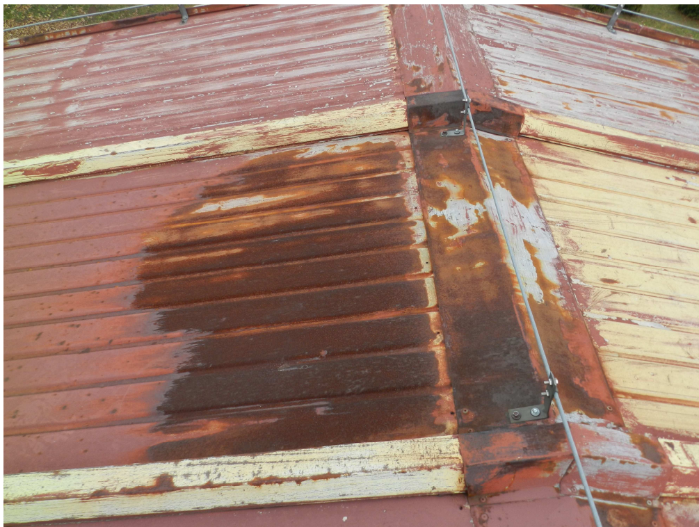
fot.30. Korozja elektrochemiczna płyty warstwowej.
