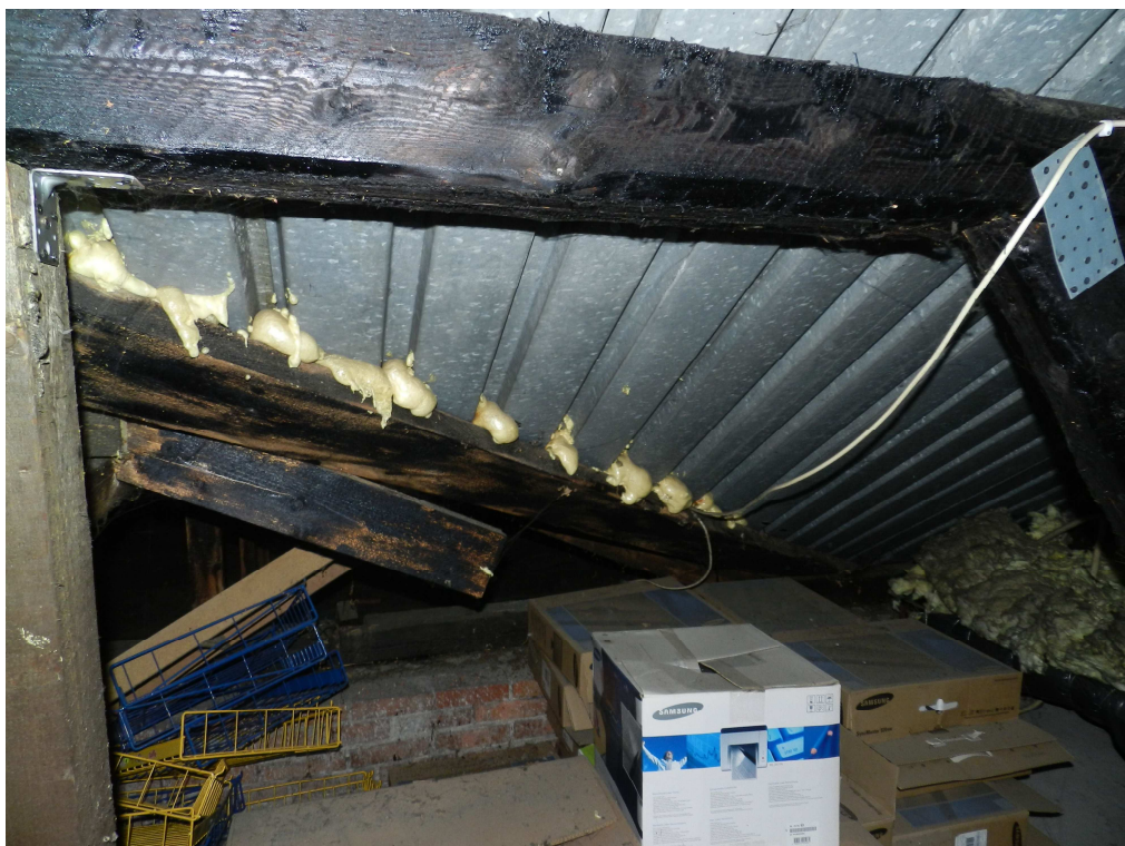
fot.12. Wadliwe uszczelnienie kosza za pomocą pianki montażowej, poliuretanowej.
