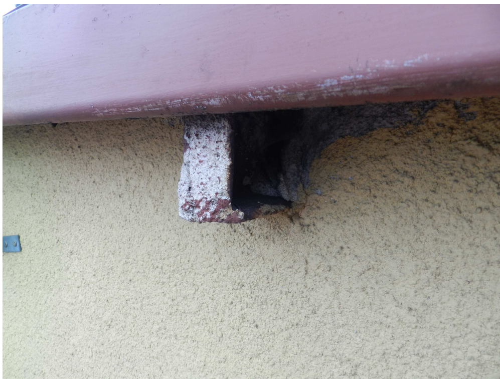
fot.25. Płatew stalowa (ceownik 80) nad dachem sali gimnastycznej.
