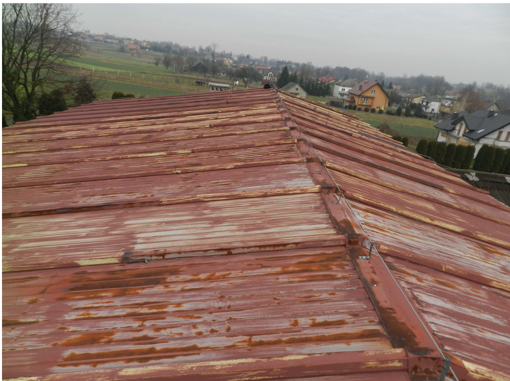
fot.28. Korozja pokrycia połaci z płyty warstwowej.
