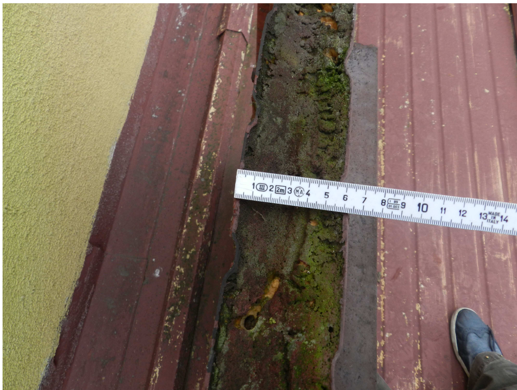
fot.26. Pokrycie połaci z płyty warstwowej poliuretanowej gr. 6cm.
