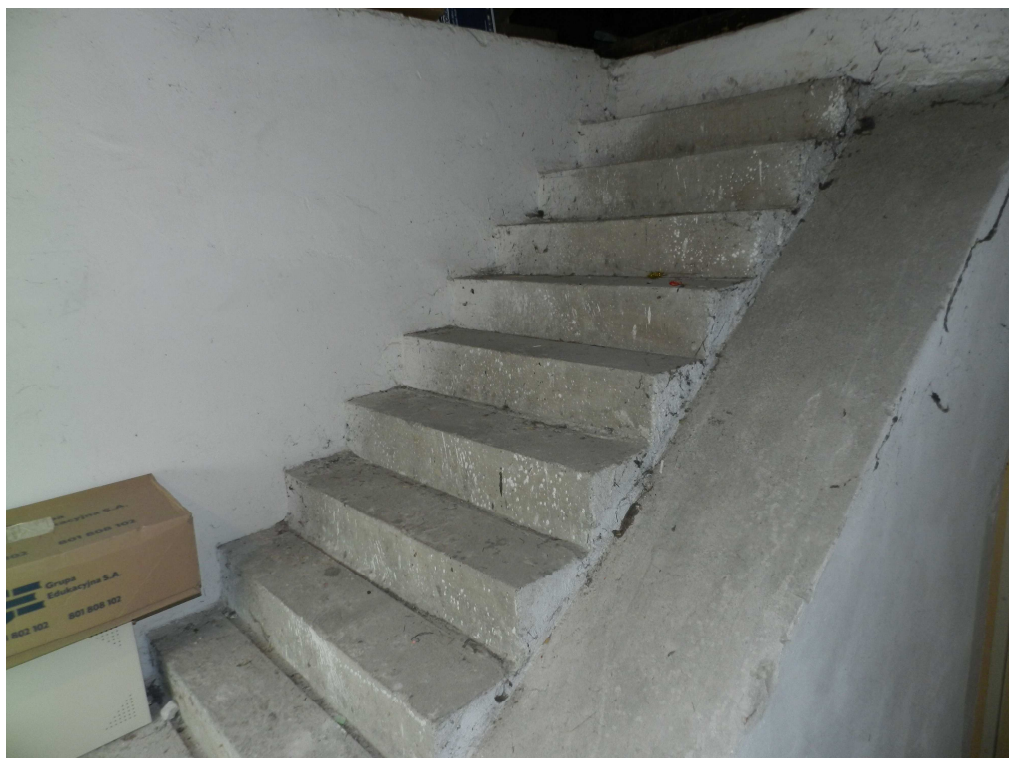
fot.8. Bieg schodów żelbetowych na poddasze.
