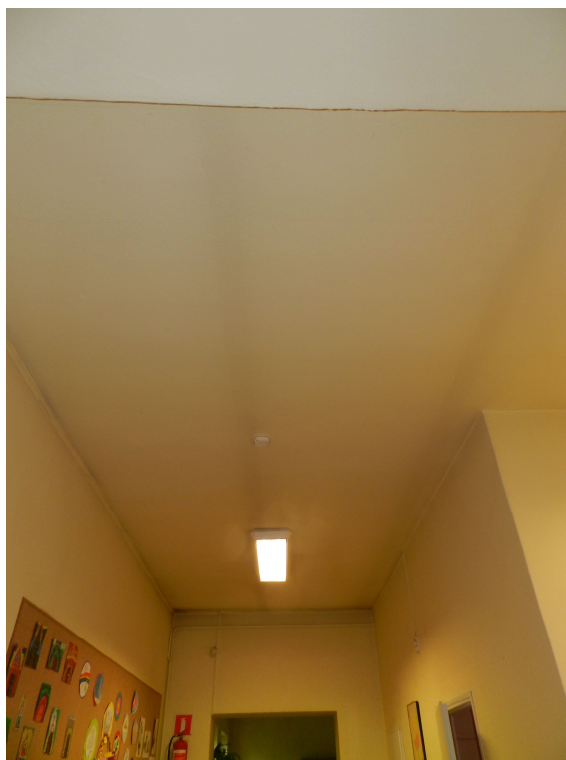
fot.6. Widoczne mostki termiczne na tynku stropu poddasza w miejscu występowania dwuteowych belek stalowych stropu WPS.
