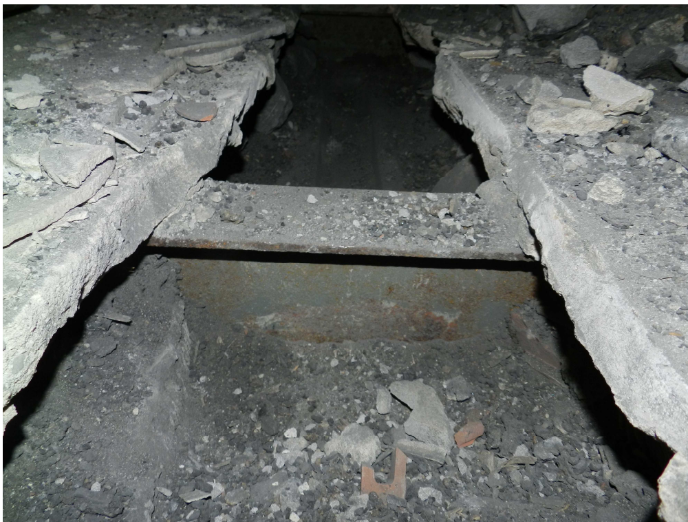
fot.5. Dwuteowa belka stalowa stropu WPS.
