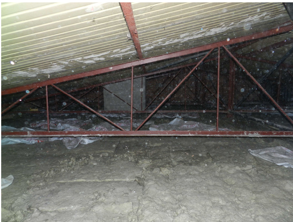
fot.24. Konstrukcja dachu nad skrzydłem północnym - stalowe więzary kratowe oparte na stropie żelbetowym.
