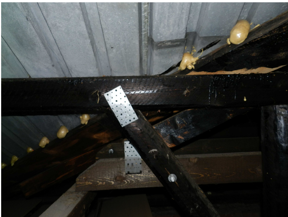
fot.10. Połączenie na płytki gwoździowane.
