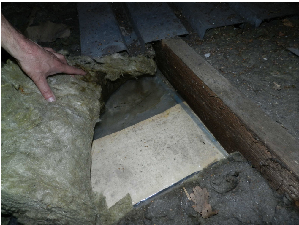
fot.21. Wody opadowe z nieszczelnego pokrycia zbierają się na folii w warstwie izolacji z wełny mineralnej.
