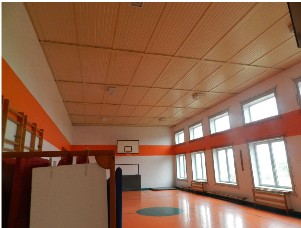
fot.23. Systemowe sufity podwieszane nad salą gimnastyczną.
