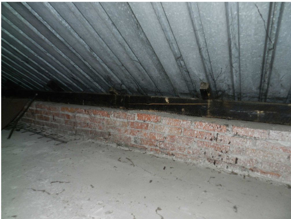
fot.11. Murowana ściana kolankowa z murlatą.
