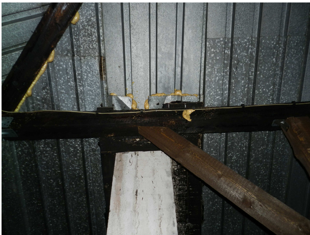
fot.14. Wadliwe uszczelnienie przy kominie.
