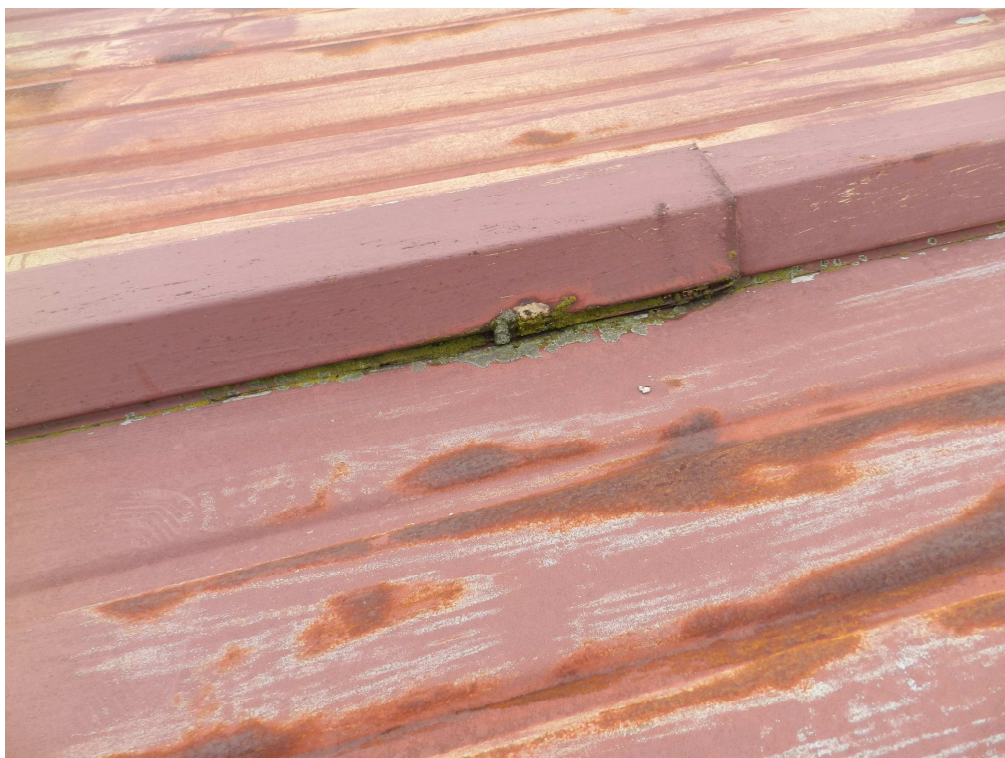
fot.31. Nieszczelność na połączeniu kołnierza i płyty warstwowej.
