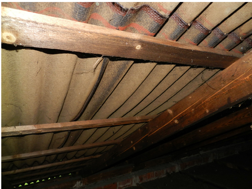
fot.18. Zniszczone i nieszczelne pokrycie z płyt falistych, bitumicznych.
