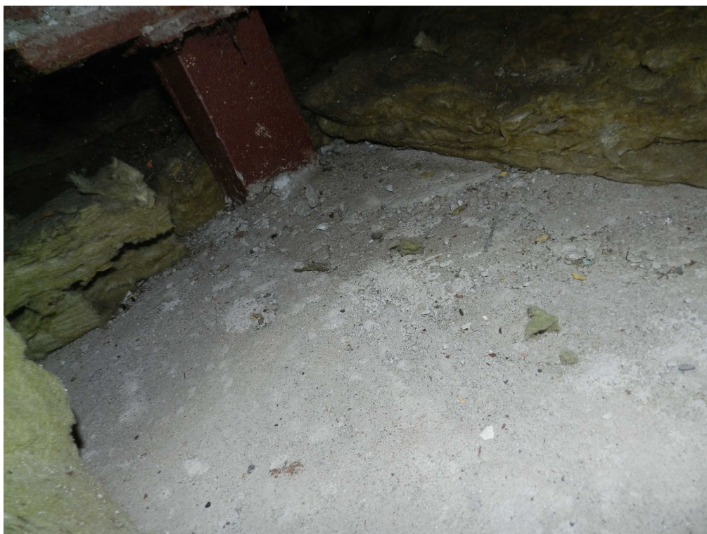
fot.35. Warstwa wełny mineralnej na stropie żelbetowych w skrzydle północnym.
