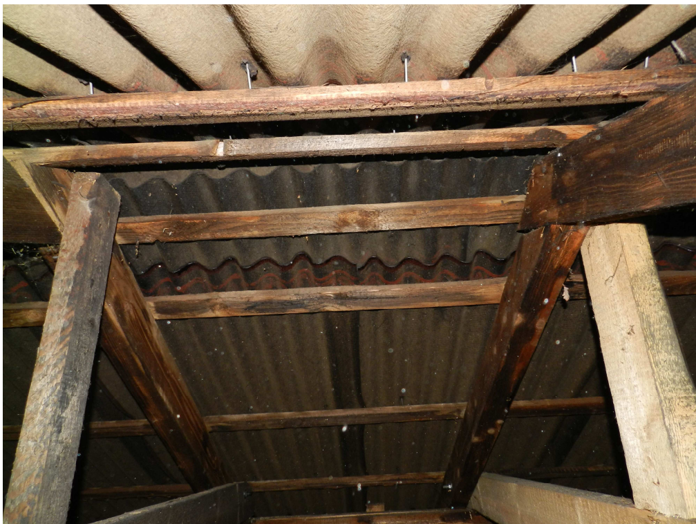
fot.17. Montaż płyt bitumicznych do łat w górnej fali - widoczne miejsca przecieków.
