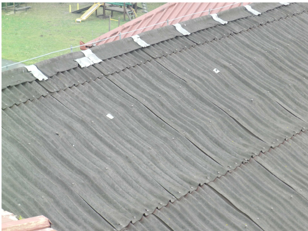
fot.19a. Widok na połać dachową przewiązki (widoczne uszkodzenia pokrycia z płyt bitumicznych).
