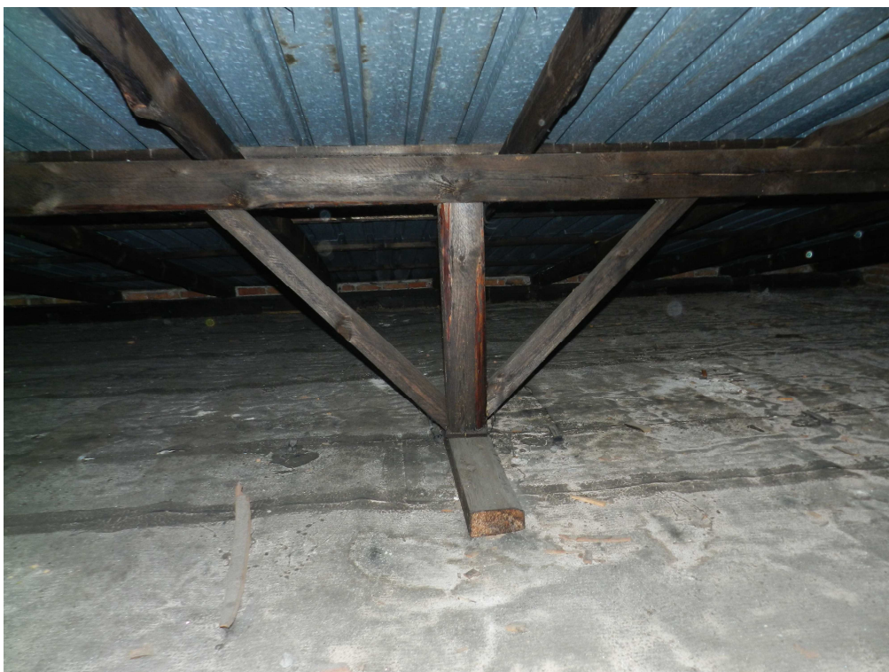
fot.4. Oparcie słupów z wieży na stropodachu za pomocą podwalin drewnianych.
