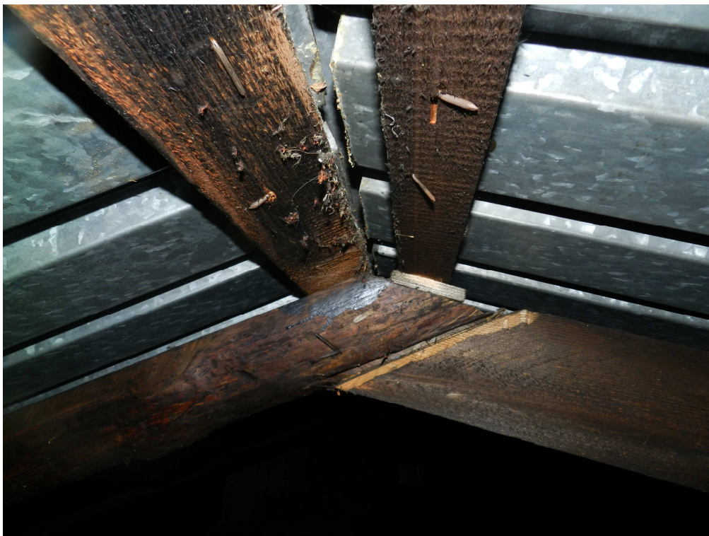
fot.7. Montaż blachy trapezowej do łąt za pomocą gwoździ.
