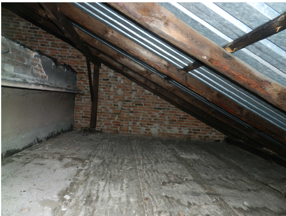
fot.8. Ściany szczytowe murowane z cegły pełnej.
