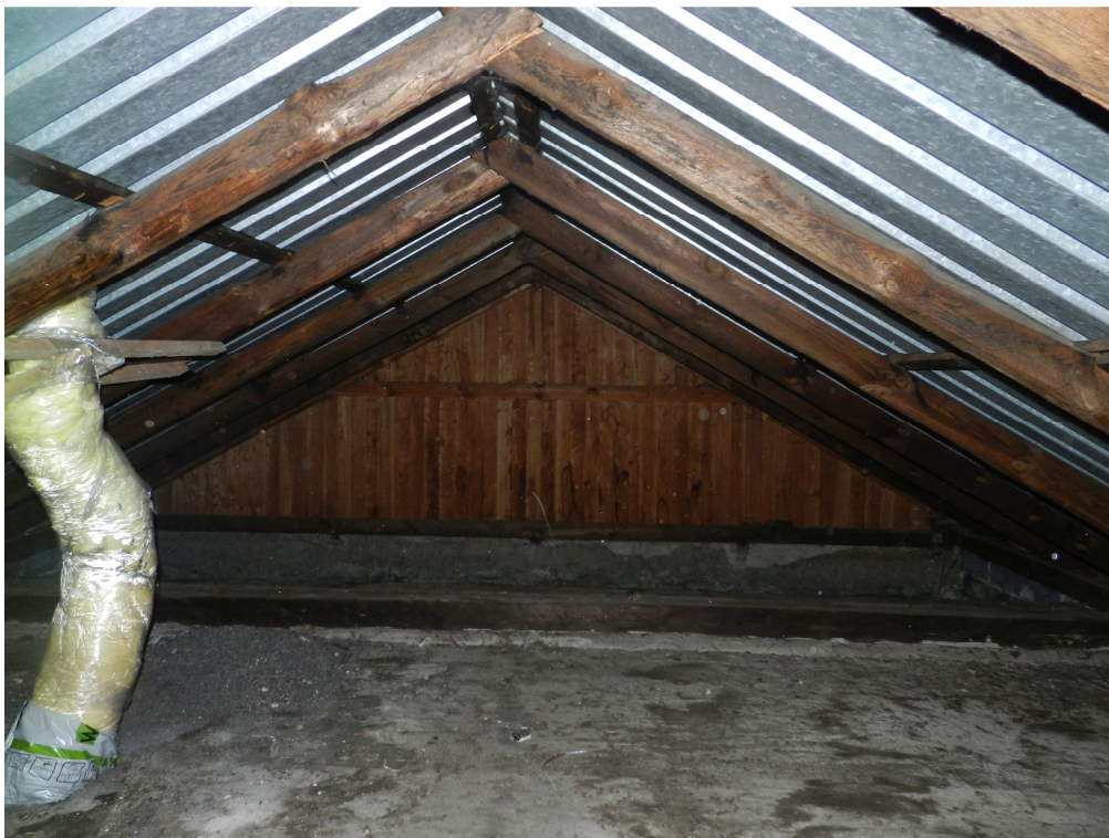
fot.9. Brak kleszczy w konstrukcji drewnianej dachu.
