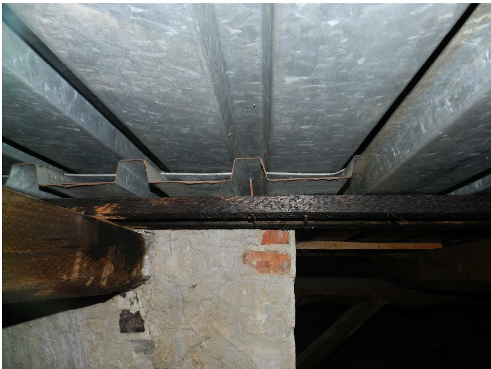
fot.5. Pokrycie połaci dachowych z blachy trapezowej.
