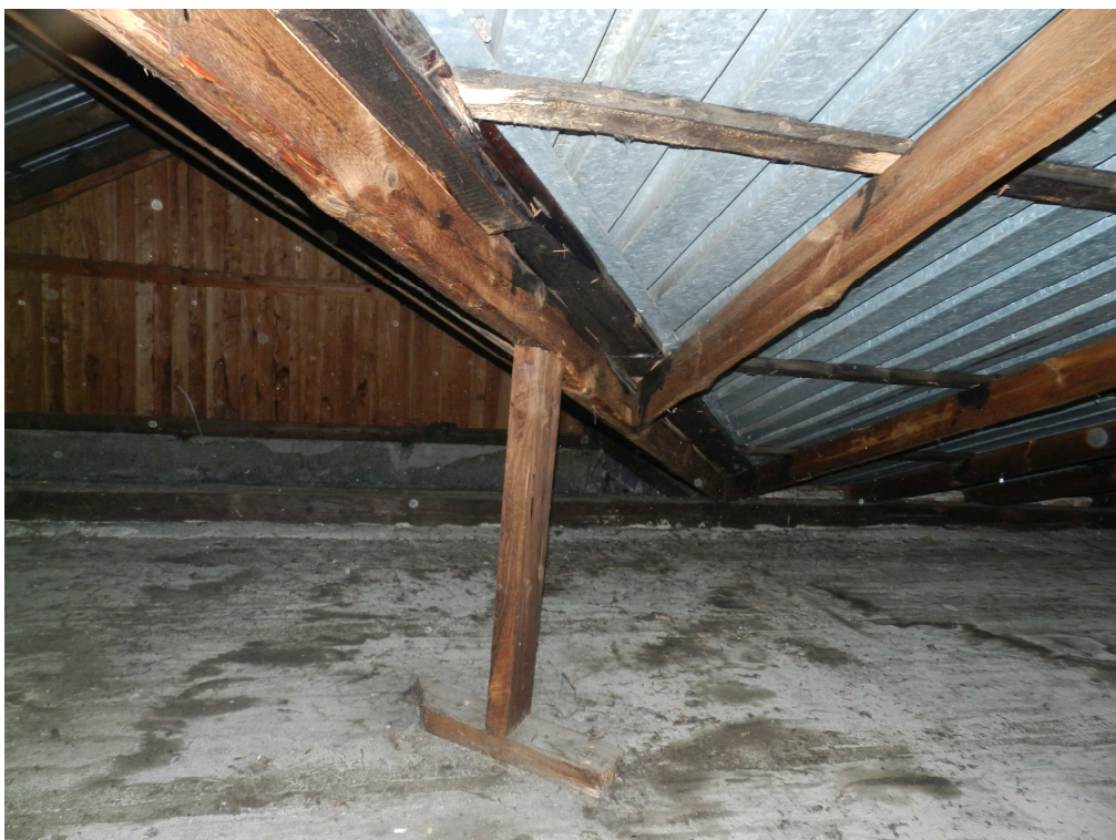
fot.6. Podparcie krokwi koszowej za pomocą słupka drewnianego o niewielkim przekroju poprzecznym.
