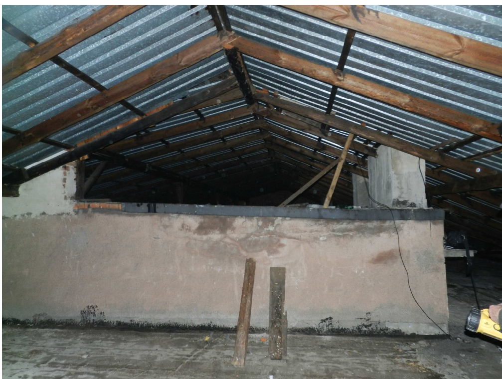
fot.2. Charakter drewnianej konstrukcji dachu. Widoczna pierwotna konstrukcja stropodachu.
