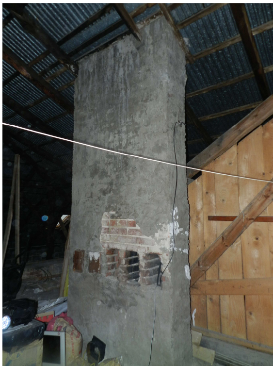
fot.14. Komin murowany z cegły pełnej.
