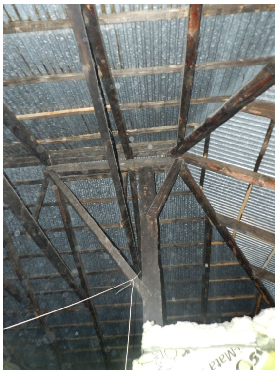
fot.13. Podparcie kalenicy i narożnika dachu na słupie z układem niesymetrycznych mieczy i fragmenty płatwi kalenicowej.
