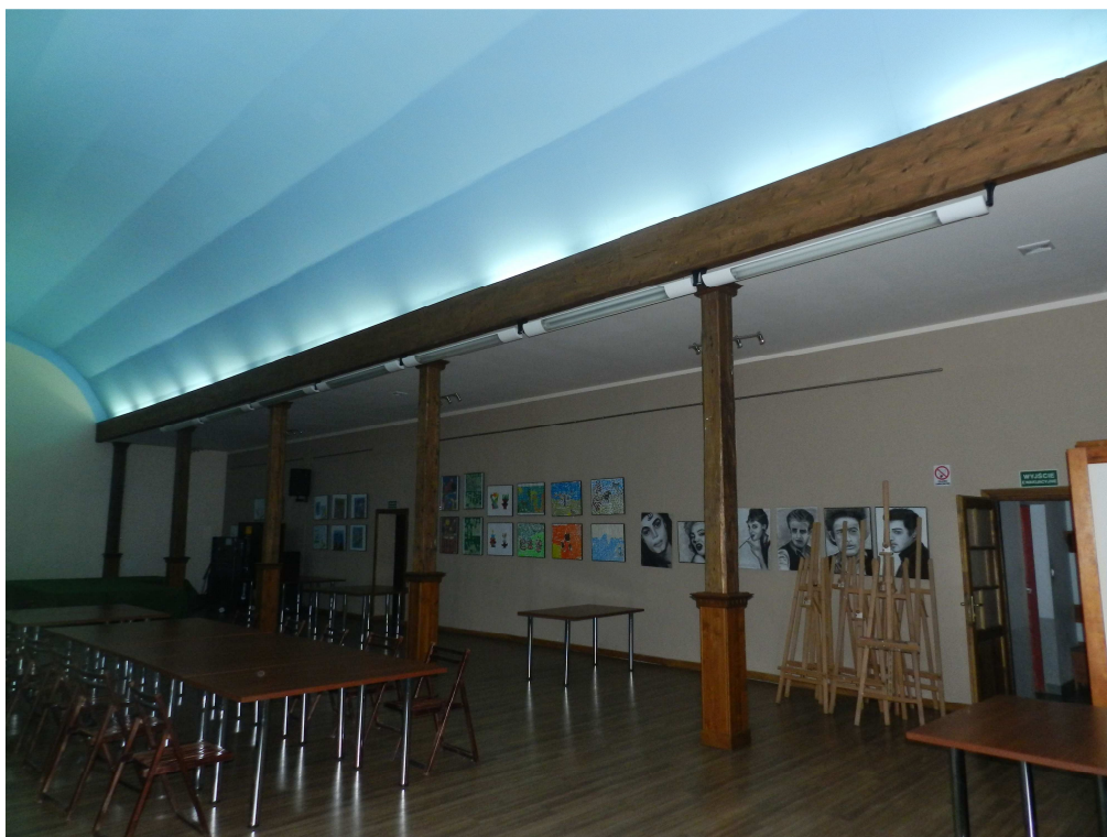
fot.10. Oparcie stropów drewnianych na słupach drewnianych w sali widowiskowej.
