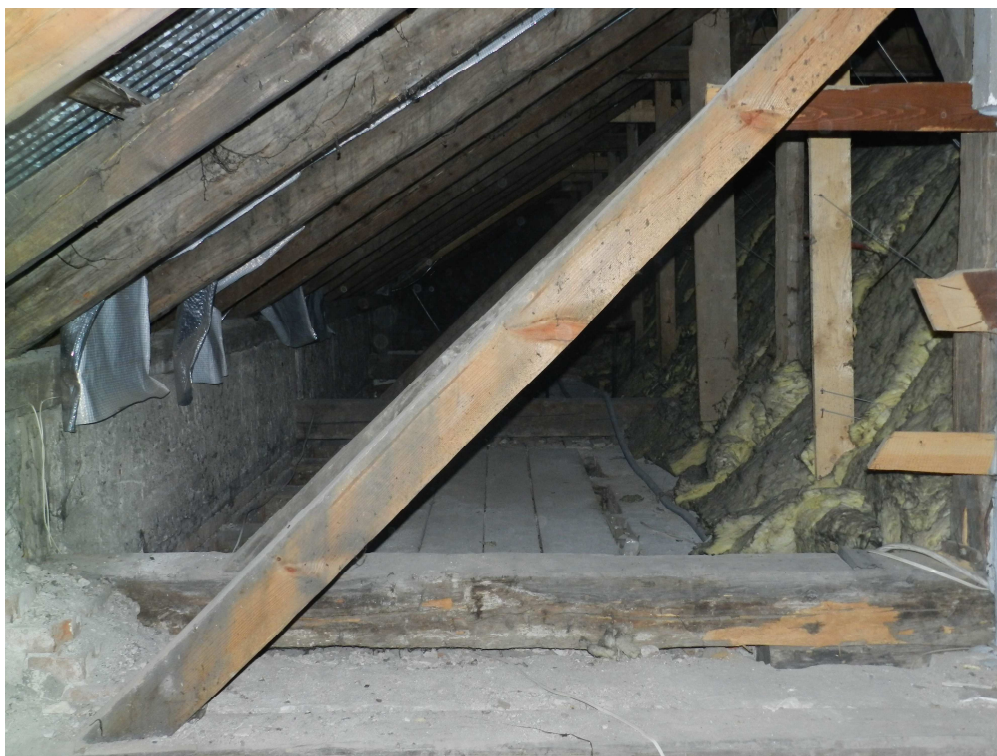
fot.9. Belki stropu drewnianego w części zachodniej - nad podcieniem i salą reprezentacyjną.
