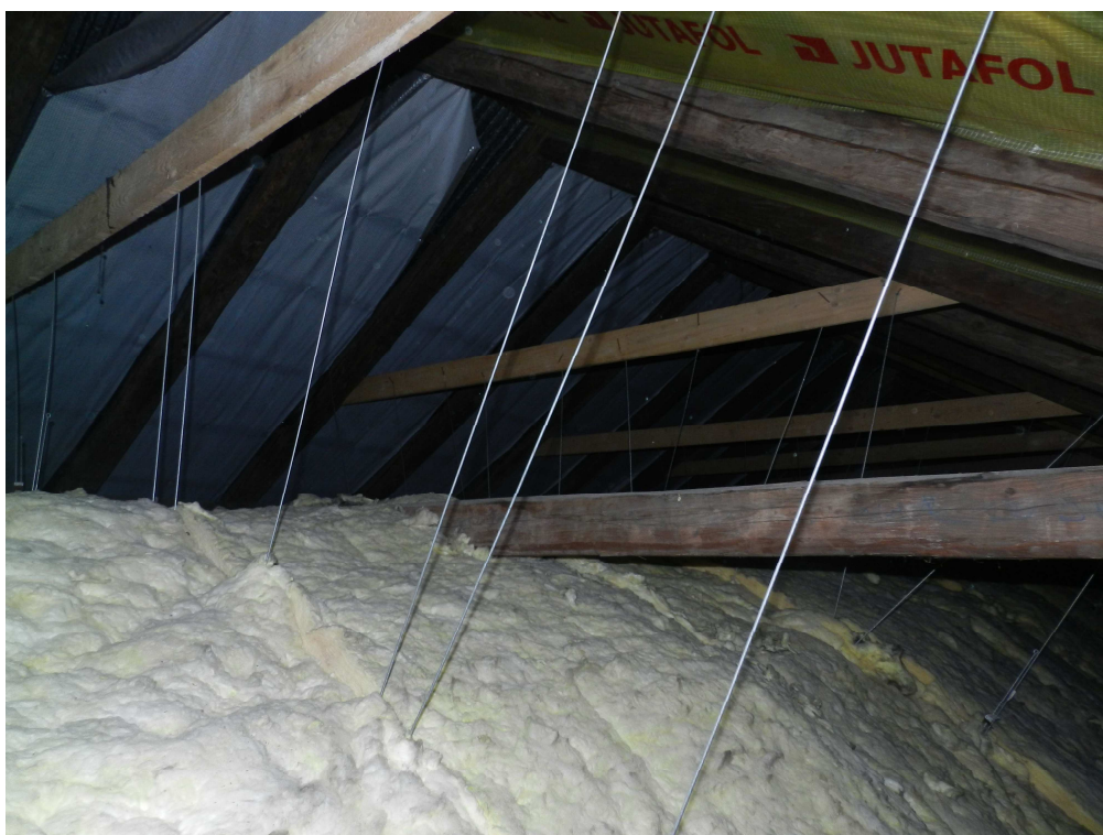
fot.3b. Podwieszone sklepienie łukowe do konstrukcji więźby dachowej.
