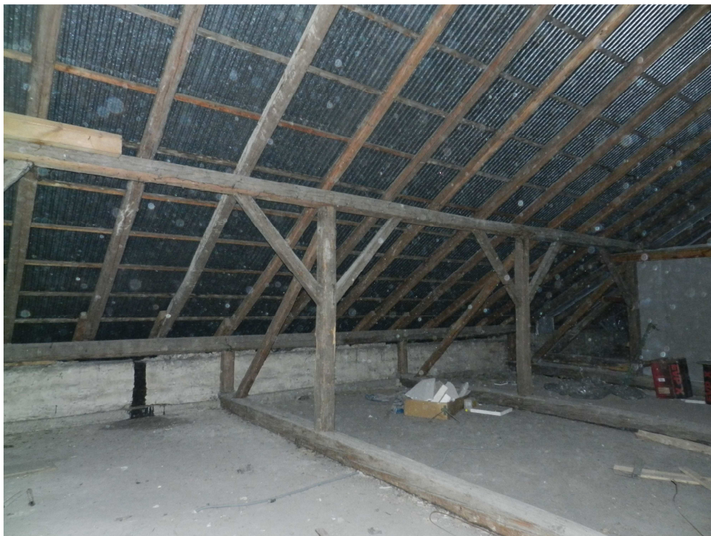
fot.5. Oparcie słupów więźby na tramach drewnianych.
