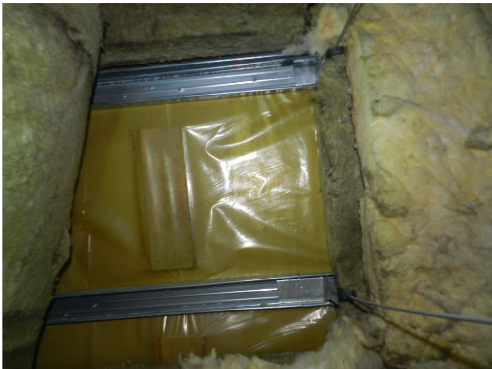
fot.3c. Konstrukcja sufitu podwieszonego na salę widowiskową.
