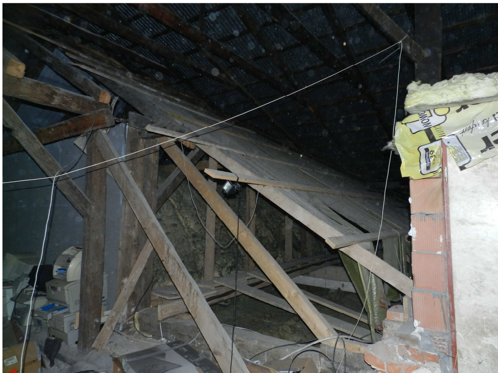
fot.8. Drewniana konstrukcja łukowego sufitu, wykonana w przestrzeni strychowej.
