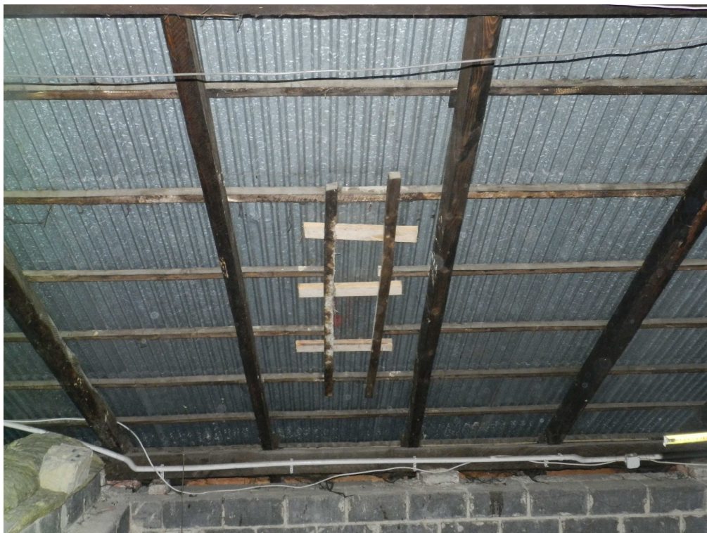
fot.12. Prowizoryczny wymian na przerwanych łatach drewnianych.
