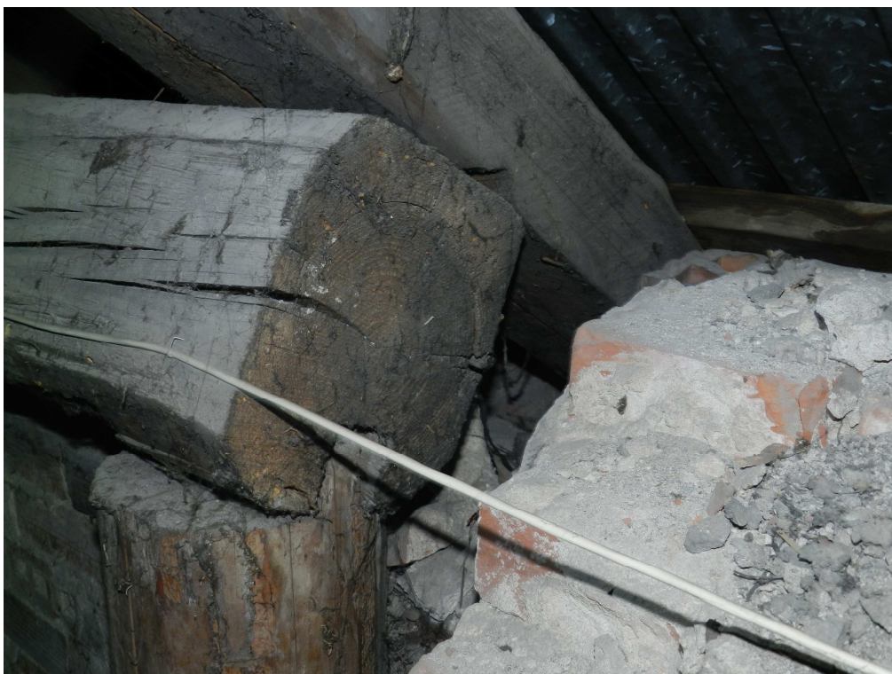
fot.7. Obrót płatwi dolnej (okapowej) na skutek działania znacznych sił poziomych (rozporowych).
