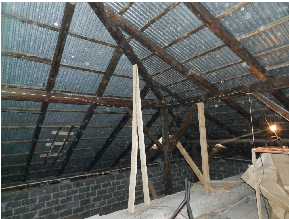
fot.11. Prowizoryczne podparcie krokwi narożnej oraz płatwi.
