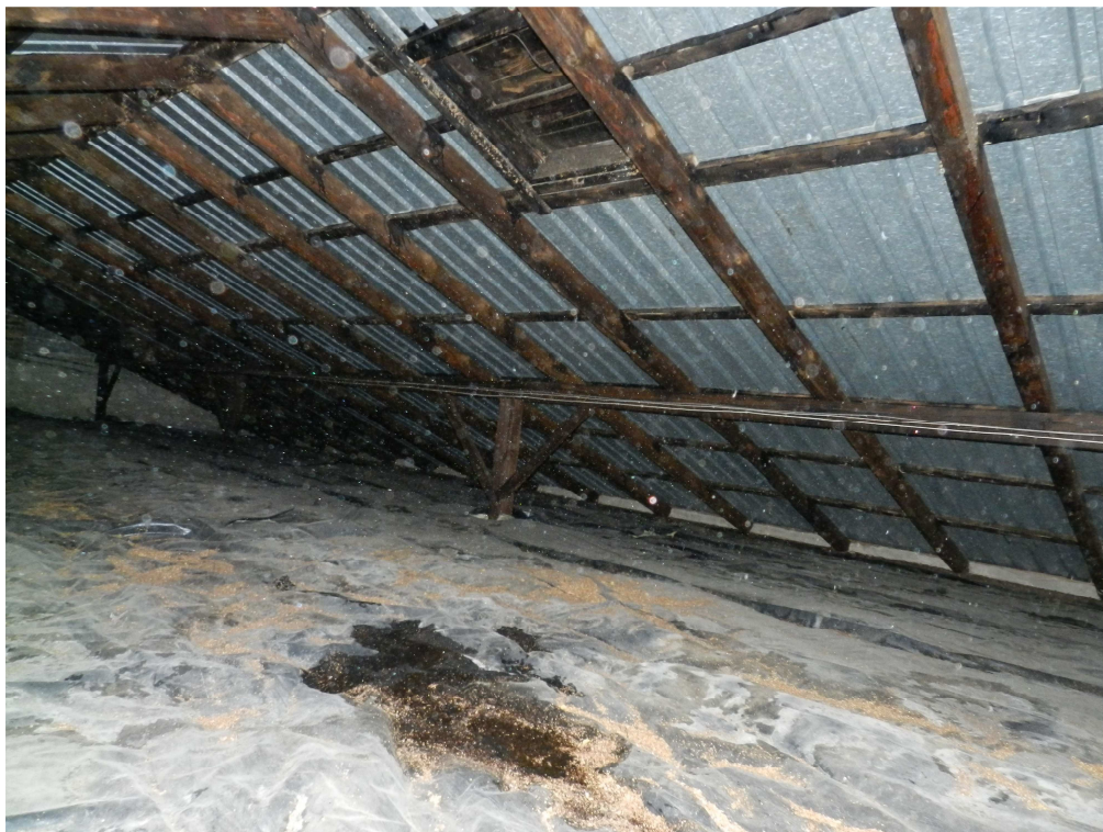
fot.5. Przecieki wylazu dachowego - widoczna kałuża pod wylazem.
