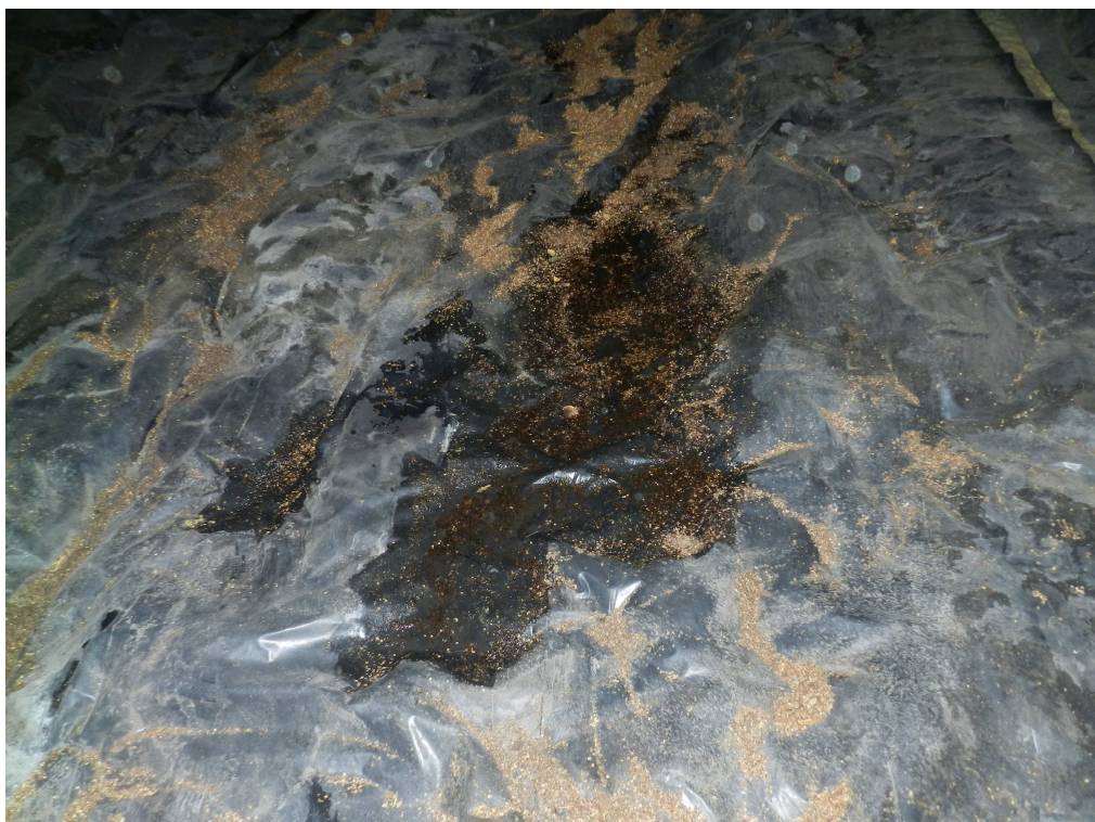
fot.5a. Przecieki wylazu dachowego - widoczna kałuża pod wylazem.
