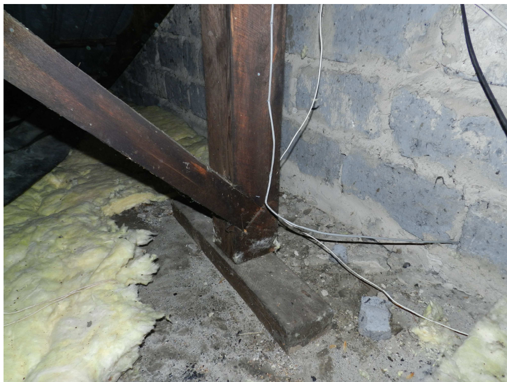
fot.4. Oparcie słupów drewnianych więźby na stropodachu za pomocą podwalin drewnianych.
