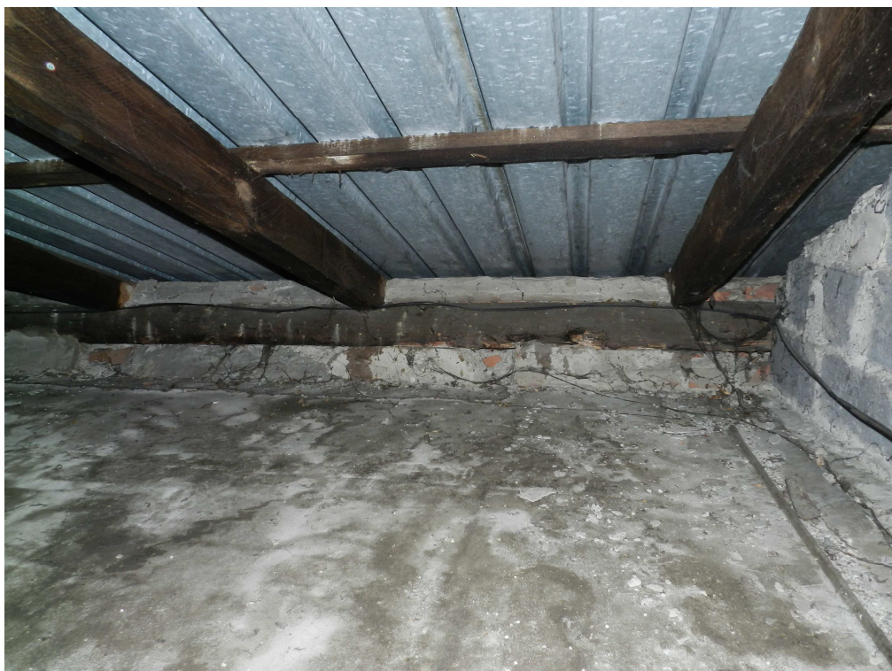
fot.13. Montaż murlaty bezpośrednio do ściany kolankowej.
