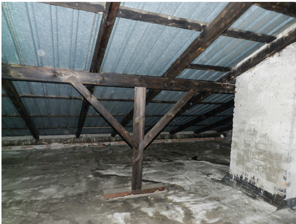
fot.10. Oparcie słupa na istniejącym stropodachu za pośrednictwem podwaliny drewnianej.
