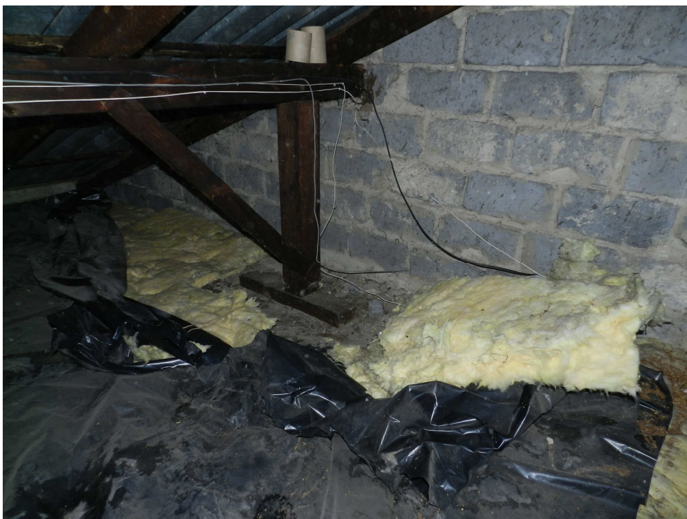
fot.7. Ocieplenie stropodachu nad domem kultury za pomocą warstwy luźno ułożonej wełny mineralnej o gr. ok. 10cm i folii.
