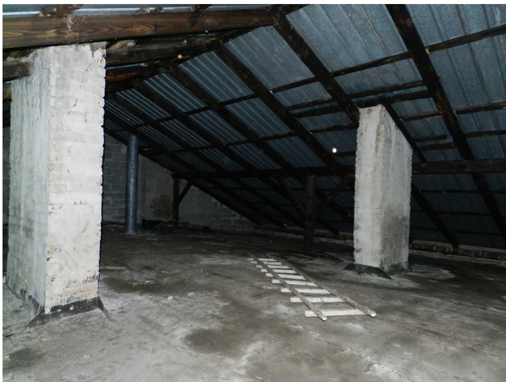
fot.9. Charakter konstrukcji płatwiowo - krokwiowej dachu nad biblioteką.
