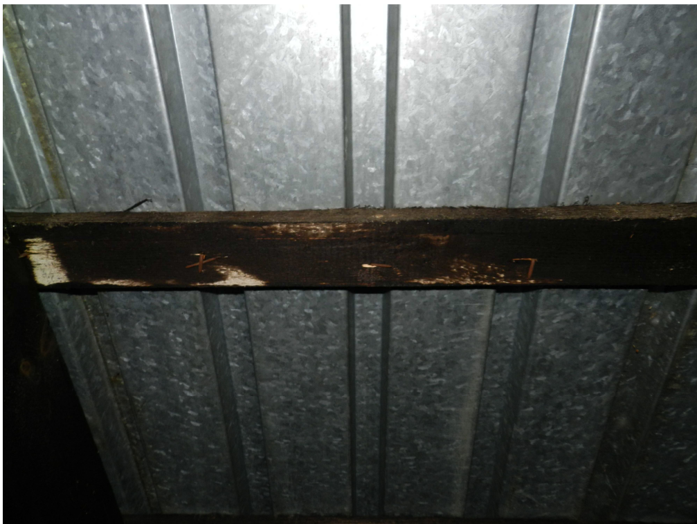
fot.12. Montaż blachy trapezowej do łat na gwoździe.
