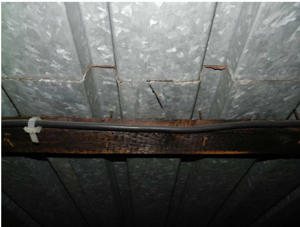
fot.6. Montaż blachy trapezowej do łąt na gwoździe.
