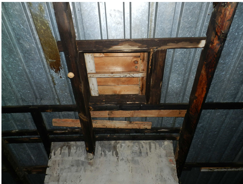
fot.11. Nieszczelny wylaz dachowy w przestrzeni dachu nad biblioteką.
