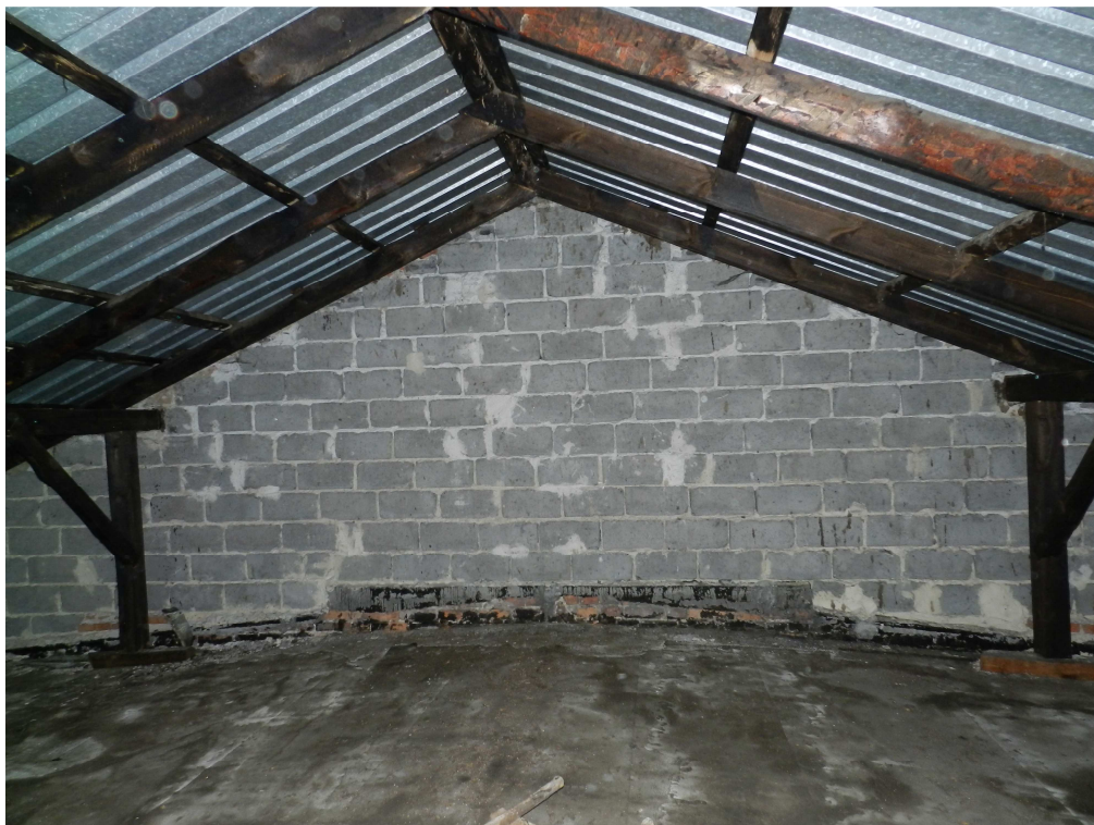
fot.14. Widoczne, pierwotne pokrycie stropodachu z papy na lepiku oraz ściana szczytowa z pustaków żużlobetonowych.
