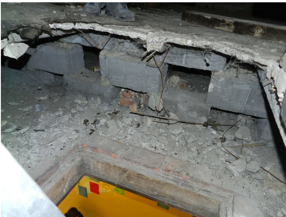
fot.6. Otwór wykonany w istniejącym stropodachu w celu umożliwienia dostępu do przestrzeni strychowej.
