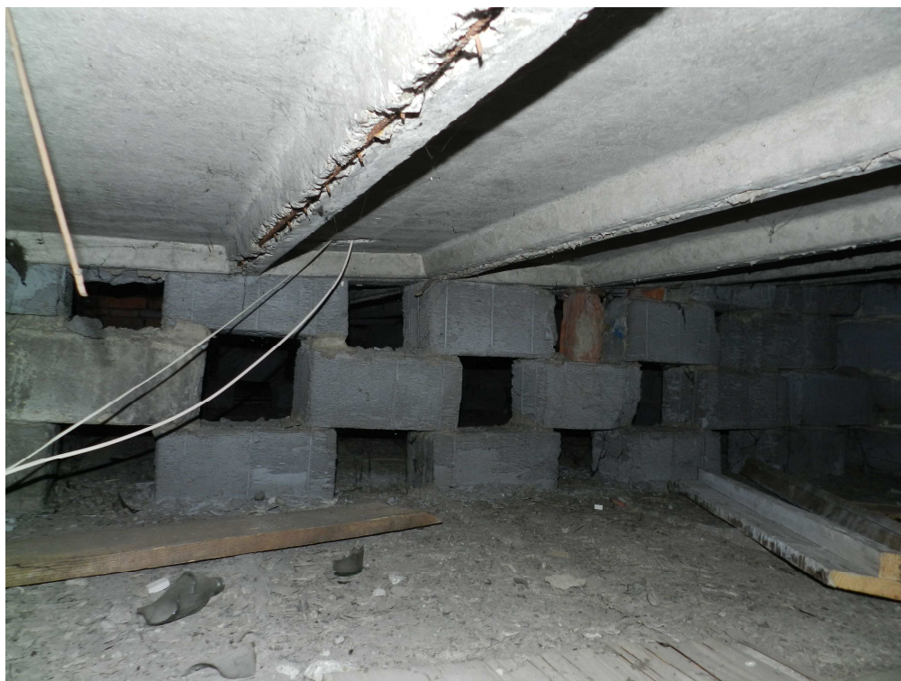
fot.8. Stropodach wentylowany z płyt korytkowych na ściankach ażurowych (pierwotne zadaszenie budynku).
