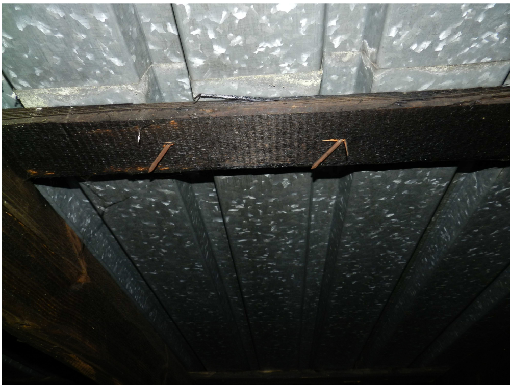
fot.11. Montaż blachy trapezowej na gwoździe.
