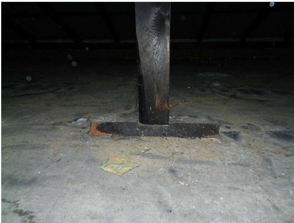
fot.7. Oparcie słupa drewnianego na istniejącym stropodachu za pośrednictwem podwaliny drewnianej.
