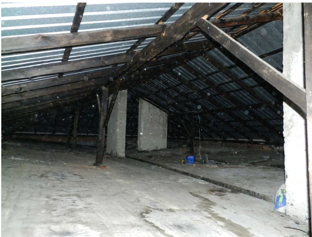
fot.5. Charakter drewnianej konstrukcji dachu nad częścią pierwotną (skrzydło zachodnie).
