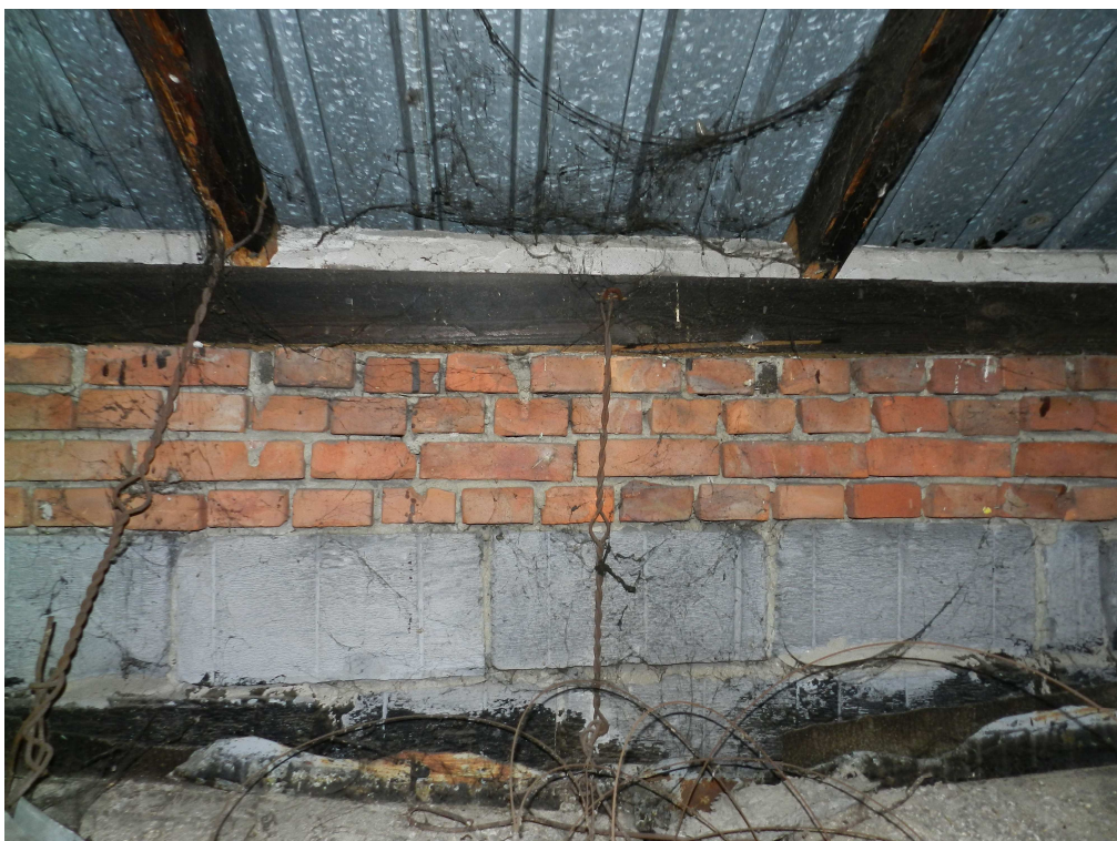
fot.10. Ściana kolankowa i montaż więźby (krokwi) do stropodachu żelbetowego.
