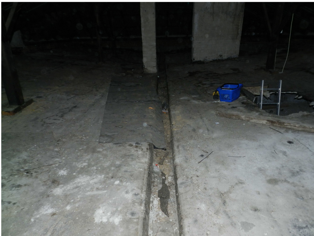
fot.9. Odwodnienie podłużne pierwotnego stropodachu.
