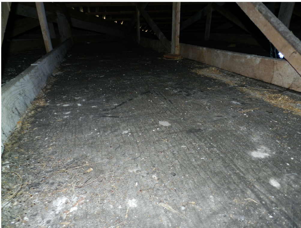
fot.3. Pokrycie pierwotnego stropodachu za pomocą papy na lepiku.
