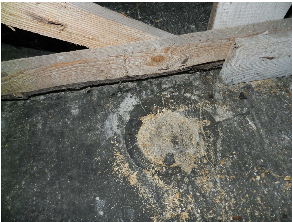
fot.12. Nieregularne przekroje i długości elementów więźarów drewnianych.
