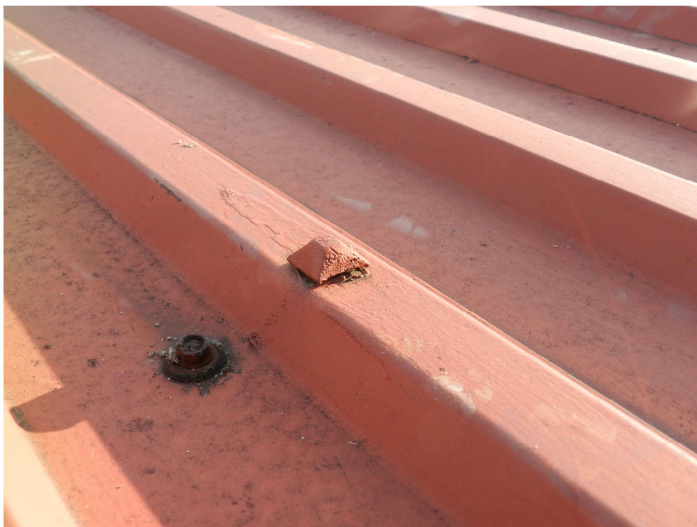
fot.9. Montaż blachy trapezowej za pomocą wkrętów.
