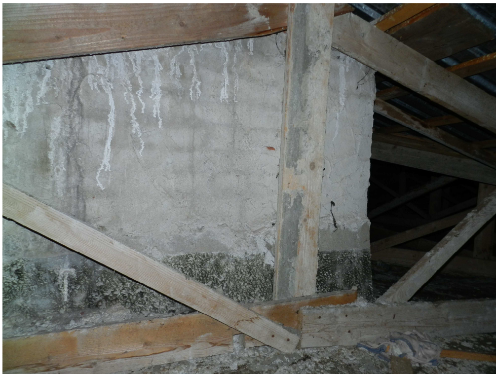
fot.10. Nieregularne przekroje i długości elementów więźarów drewnianych.
