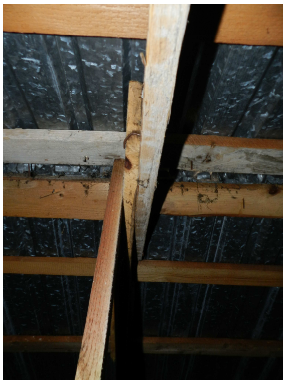
fot.13. Nieregularne przekroje i długości elementów więźarów drewnianych.
