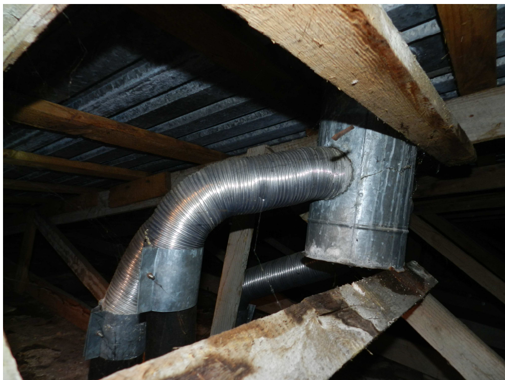
fot.7. Nieszczelne przejście wentylacji mechanicznej przez połacie dachowe.
