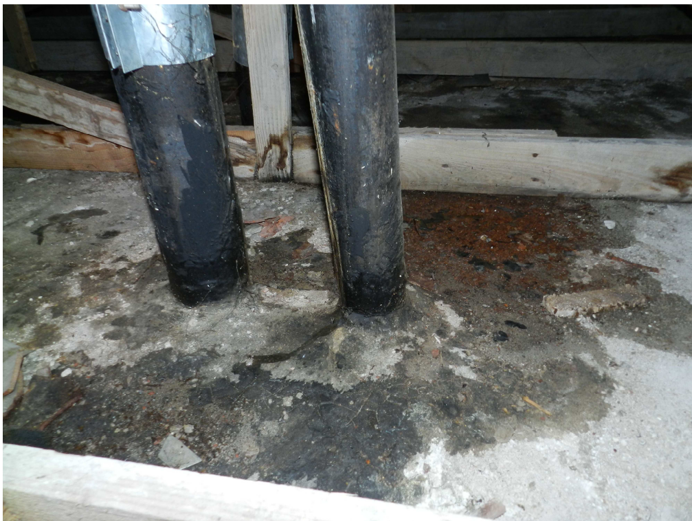
fot.8. Widoczne przecieki wody opadowej na stropodachu pod włazem dachowym.
