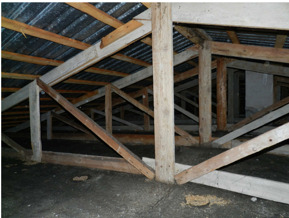
fot.4. Widok ogólny konstrukcji drewnianej dachu. Widoczne więzary kratowe, wsparte na stropodachu żelbetowym.
