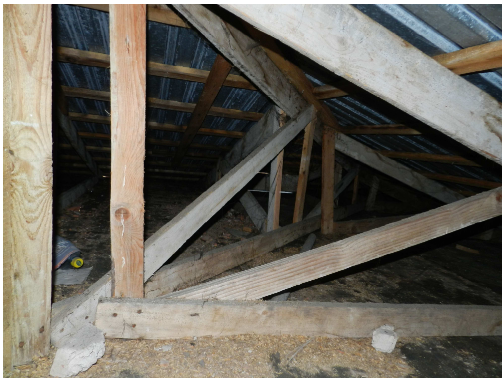
fot.11. Nieregularne przekroje i długości elementów więźarów drewnianych.
