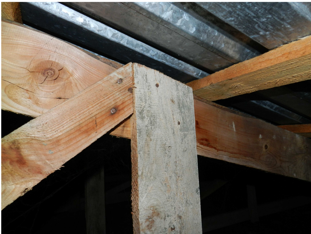
fot.5. Połączenie gwoździowane elementów drewnianych kratownicy.
