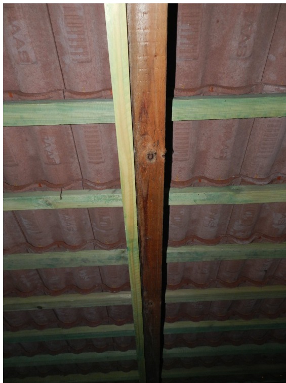
fot.6. Wzmocnienie istniejących krokwi poprzez wykonanie przykładek.
