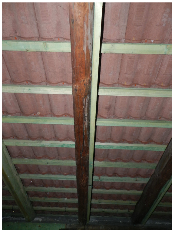
fot.9. Wzmocnienie istniejących krokwi poprzez wykonanie przykładek.
