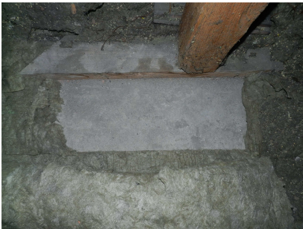
fot.7. Oparcie słupa drewnianego na stropie żelbetowym w części dwukondygnacyjnej budynku domu kultury.
