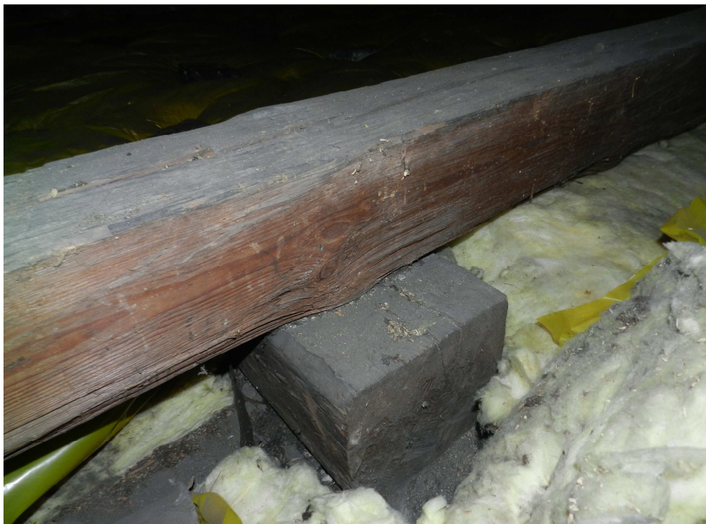
fot.10. Podparci tramu za pomocą podwaliny drewnianej.
