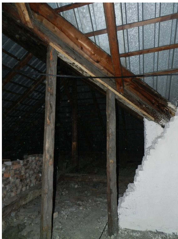
fot.9. Prowizoryczne podparcie krokwi koszowych lukarn.
