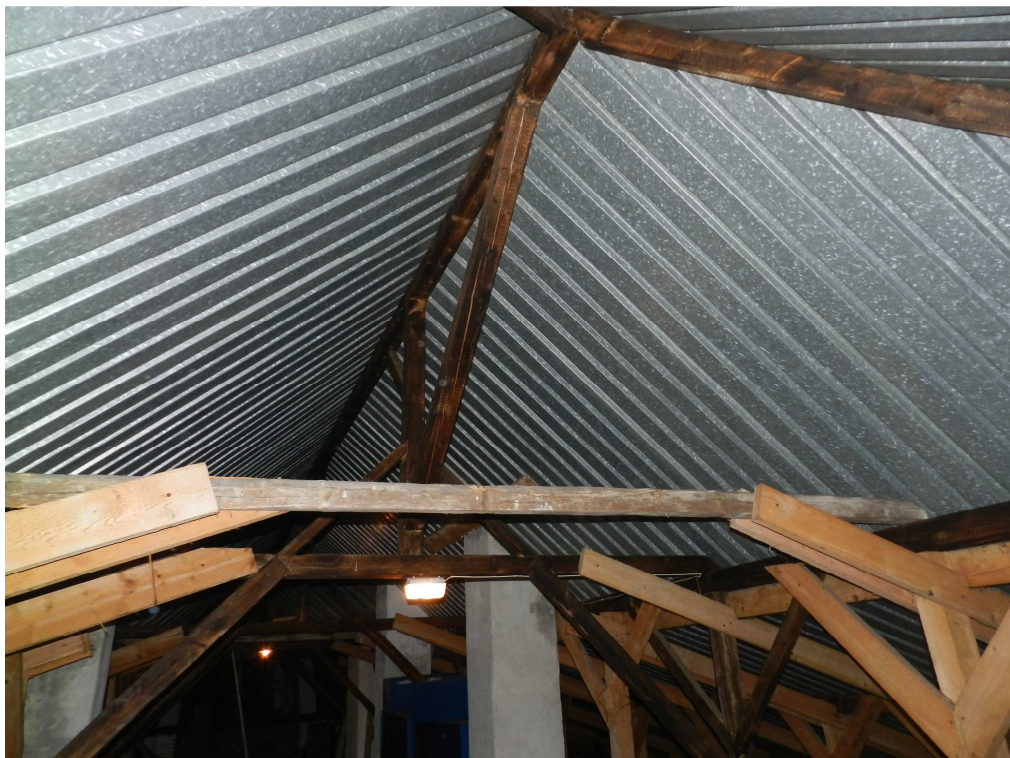
fot.15. Brak warstw dachowych, izolacyjnych i wykończeniowych.
