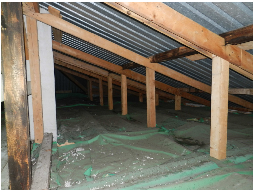
fot.13. Charakter więzarów drewnianych w połaciach bocznych.
