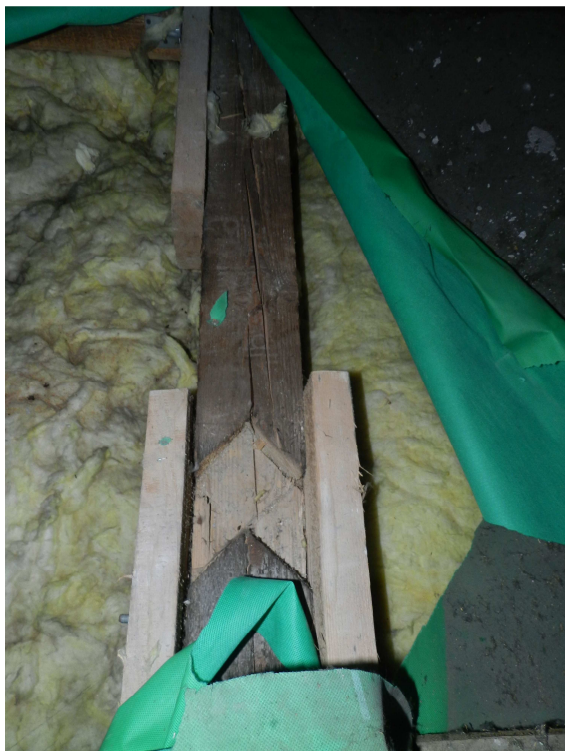
fot.17. Wypuszczone elementy pasów dolnych więźarów w celu wzmocnienia istniejącej jętki.
