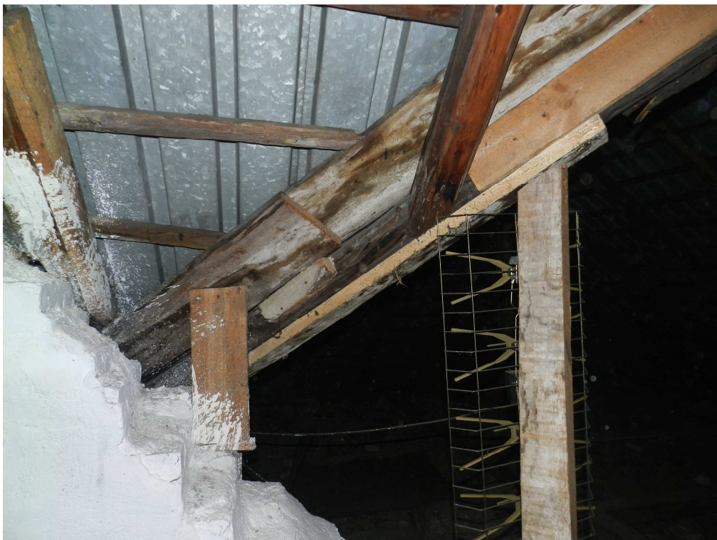
fot.8. Prowizoryczne wzmocnienie krokwi koszowych lukarn.
