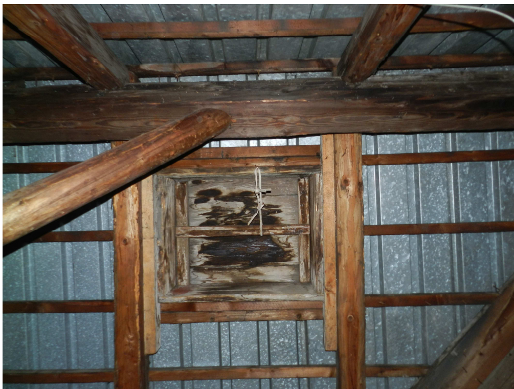
fot.7a. Widoczne ślady nieszczelności wylazu dachowego.
