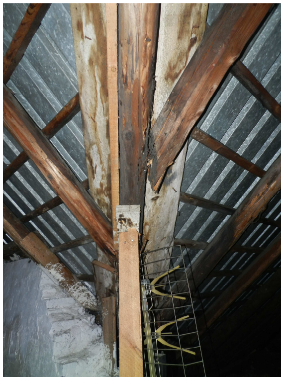
fot.7. Widoczne ślady nieszczelności w koszach lukarn.
