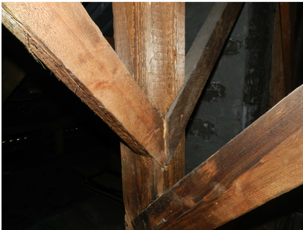
fot.14. Połączenie ciesielskie, gwoździowane.
