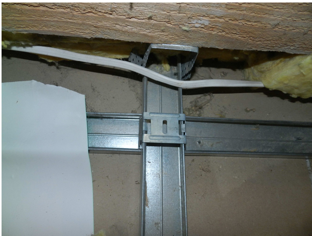
fot.16. Podkonstrukcja sufitu podwieszanego z profili aluminiowych.
