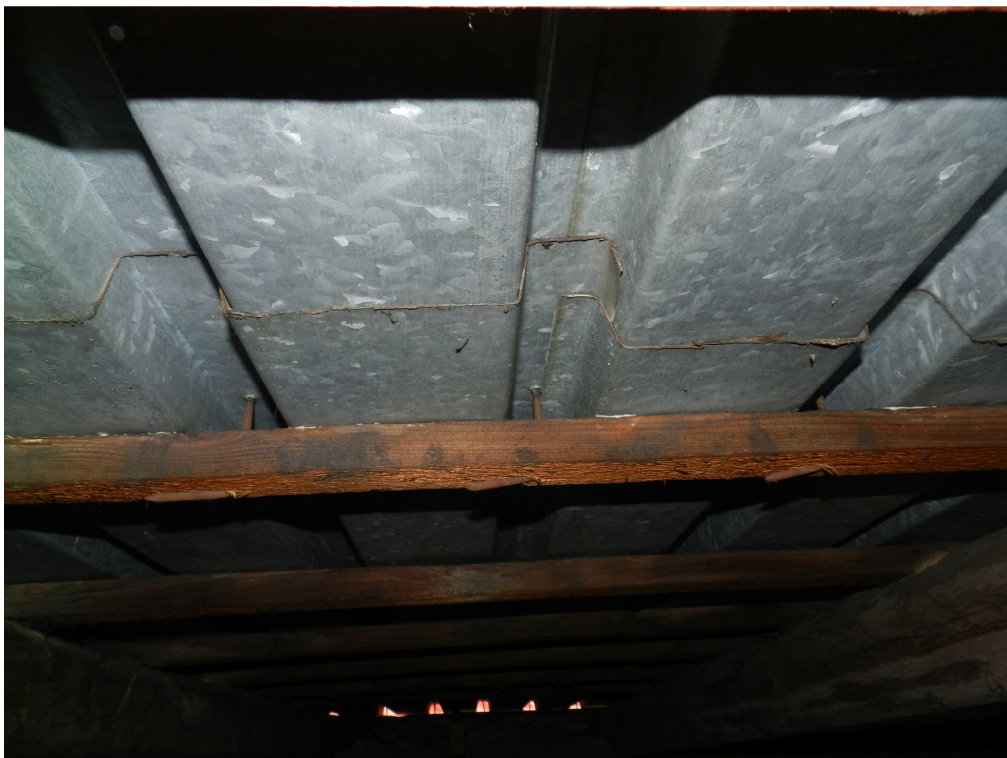
fot.10. Montaż blachy trapezowej do łąt na gwoździe w górnych płaszczyznach trapezów.
