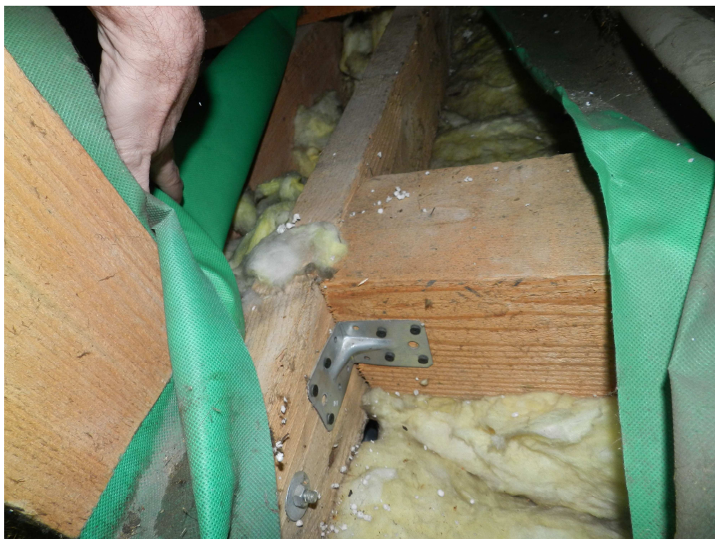
fot.14a. Połączenie elementów sufitu podwieszanego z pasami więźarów.
