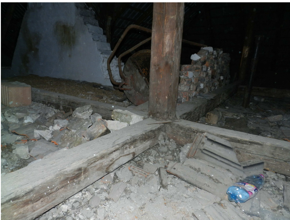
fot.6. Oparcie słupa na podwalinie drewnianej i stropie żelbetowym.
