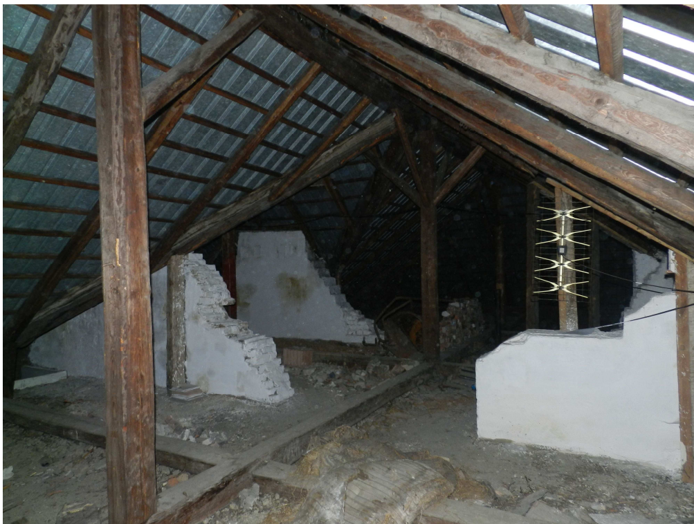
fot.5. Charakter konstrukcji drewnianej nad skrzydłem południowym.
