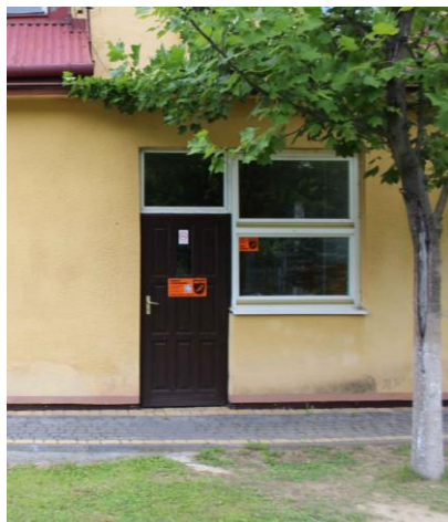
Widok na ścianę południową. Należy dwa okna zastąpić drzwiami z naswietłem.
