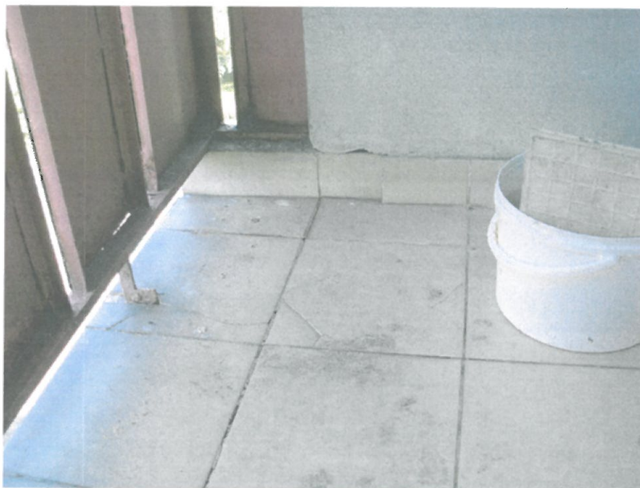
Zdj. nr1. Widoczne spękania okładziny z płytek ceramicznych, uszkodzony i nieszczelny cokół
