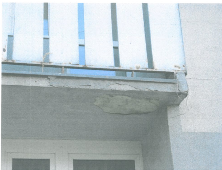
Zdj. nr8. Widoczne skutki penetracji wody pod warstwy tynku cienkowarstwowego i na obrzeża płyty balkonowej. Widoczna korozja na powierzchni balustrady.
