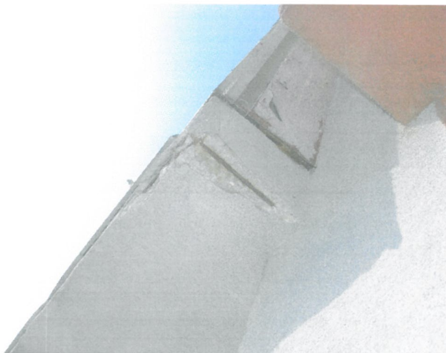
Zdj. nr6. Widoczne złuszczenie warstwy betonu stanowiącej otulinę prętów zbrojeniowych w wyniku penetrującej wody przez płytę balkonu. Postępująca korozja zbrojenia.
