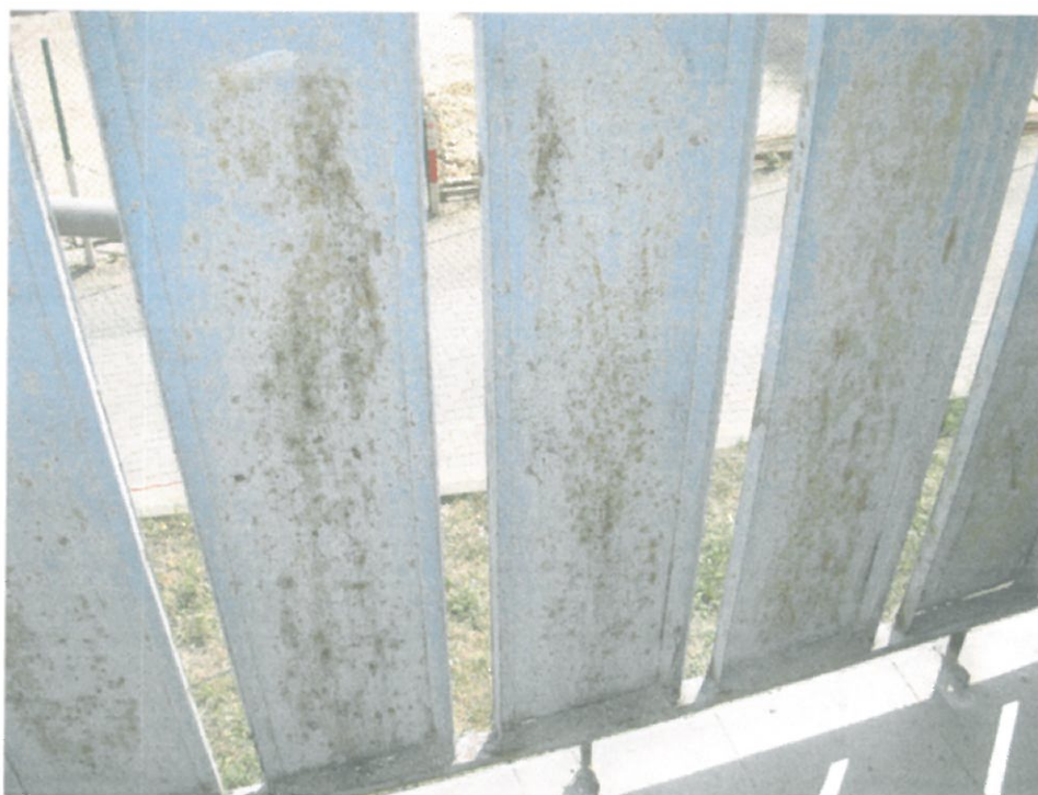
Zdj. nr12. Widoczna złuszcząca się powłoka malarska i ogniska korozji na powierzchni elementów stalowych balustrad.
