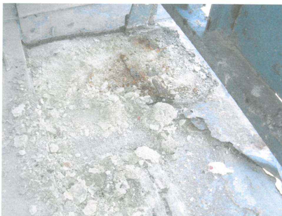
Zdj. nr4. Wykonana odkrywka. Po usunięciu częściowo odspojonej płytki widoczny zlasowany klej oraz skorodowana stalowa obróbka w 50% zgnita nie spełniająca swojej roli.
