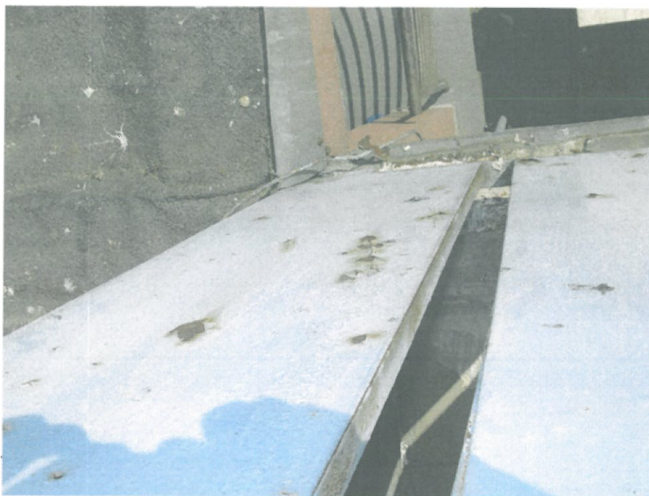
Zdj. nr11. Widoczna złuszcząca się powłoka malarska i ogniska korozji na powierzchni elementów stalowych balustrad.
