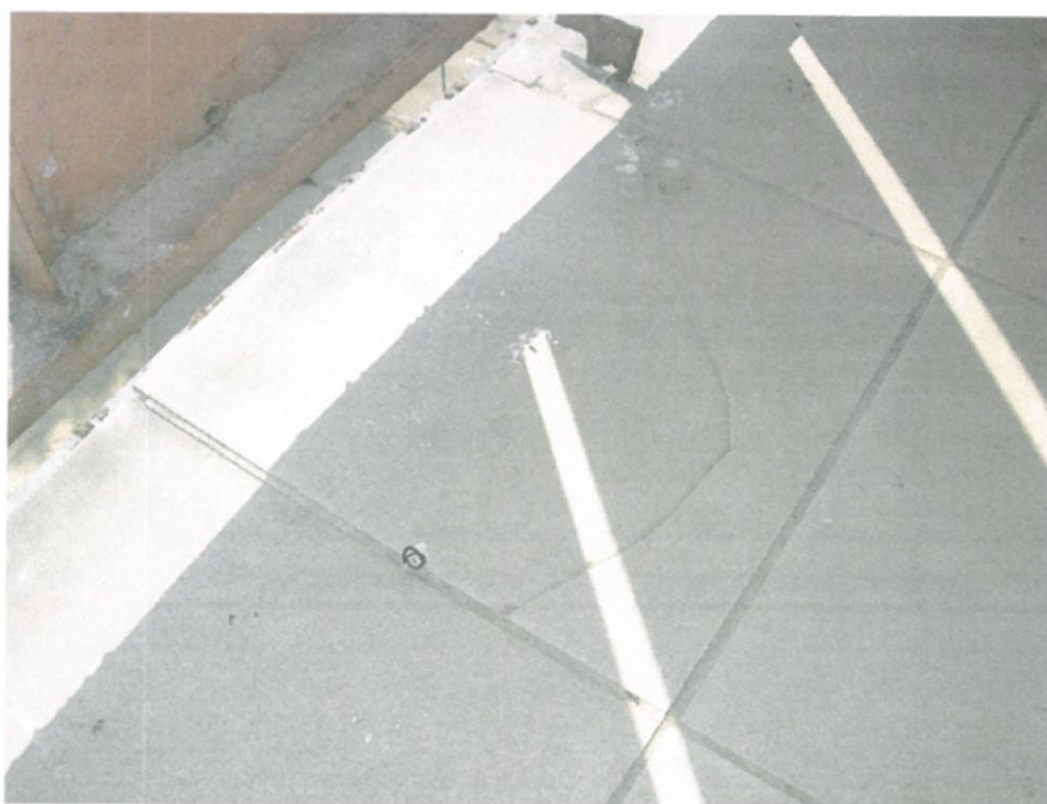
Zdj. nr2. Widoczne uszkodzenia płytek i nieszczelne spoinowania przy krawędzi balkonu
