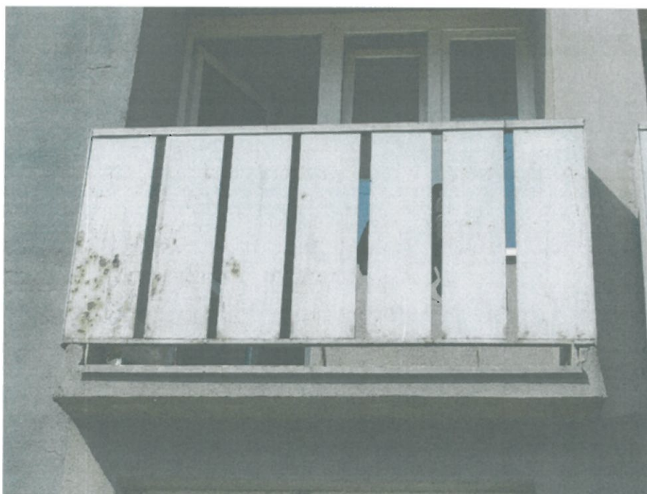
Zdj. nr10. Widoczna korozja stalowych elementów balustrady.
