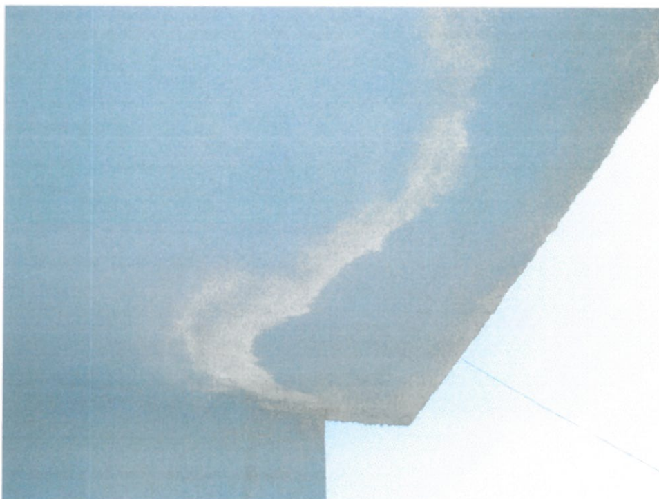
Zdj. nr7. Widoczne zacieki na dolnej powierzchni płyty balkonowej.
