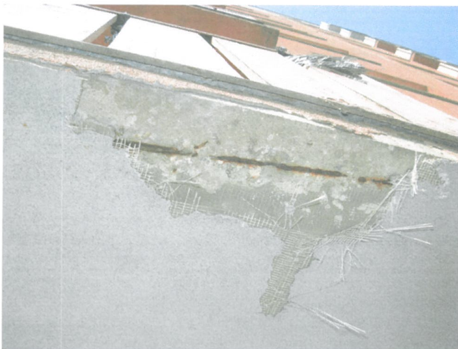
Zdj. nr9. Wykonana odkrywka poprzez usunięcie luźnych (odparzonych) fragmentów tynku cienkowarstwowego. Widoczne odspojenie warstwy betonu stanowiącej otulinę prętów zbrojeniowych. Widoczna postępująca korozja zbrojenia.
