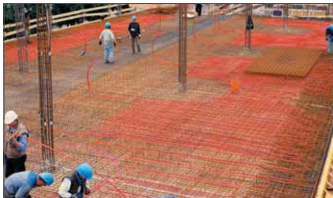
Rys. 8-4 System BKT REHAU układany na budowie
