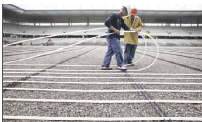
Rys. 9-34 Układanie rur grzewczych
