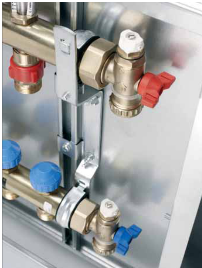
Rys. 6-10 Montaż uchwyty rozdzielacza w szafce o głębokości 75–90 mm
