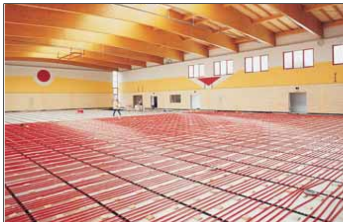
Rys. 9-17 System ogrzewania podłogi elastycznej z rozdzielaczem standardowym
