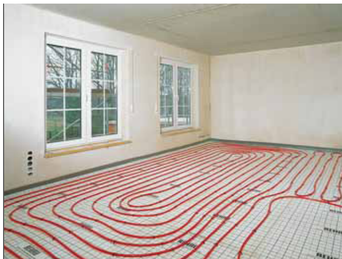
Rys. 3-22 Płyta systemowa Tacker
