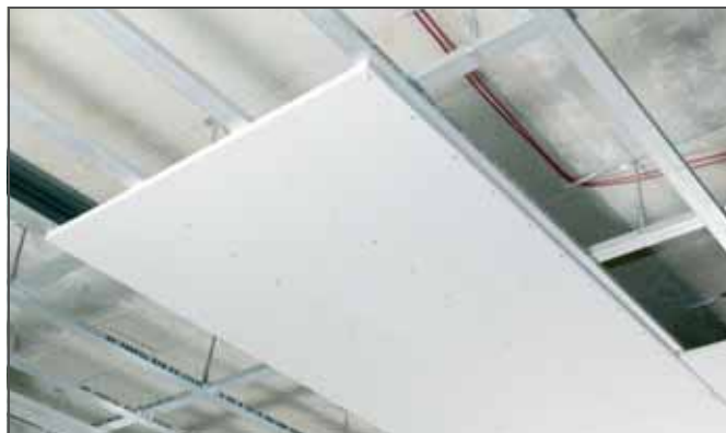
Rys. 4-5 Zamontowana płyta sufitowa
