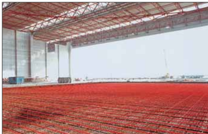
Rys. 9-1 Ogrzewanie płaszczyznowe hali przemysłowej
