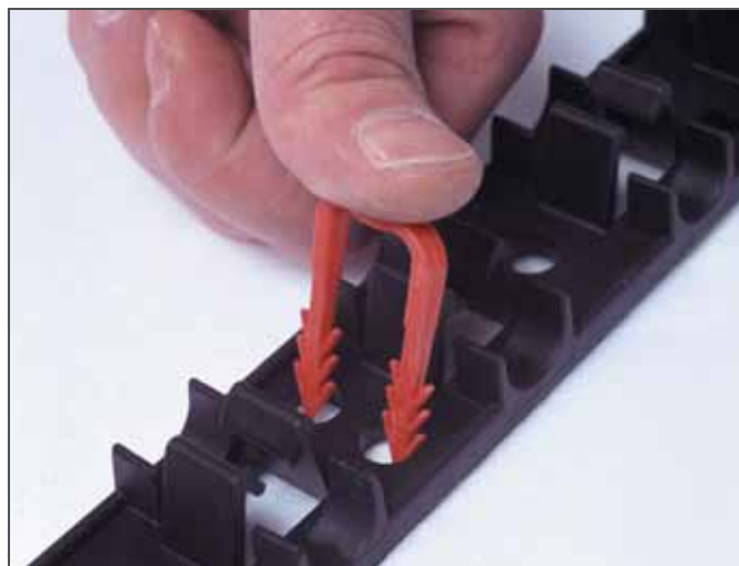
Rys. 3-35 Wciskanie szpilki mocującej w konstrukcję podłogi
