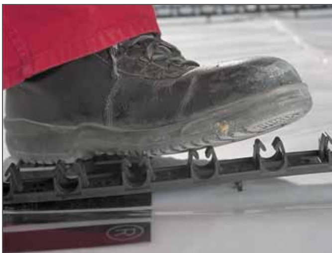
Rys. 3-34 Wciskanie listwy RAUFIX w konstrukcję podłogi
