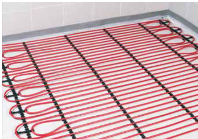
Rys. 3-69 Montaż w technologii mokrej na listwie zaciskowej
