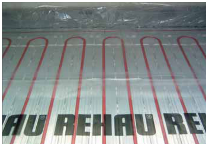
Rys. 3-60 System suchej zabudowy TS-14
