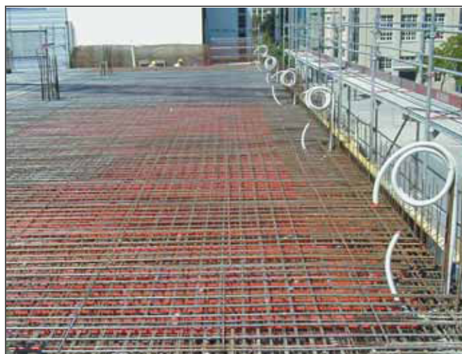
Rys. 8-2 System stropów aktywowanych termicznie - fragment przeznaczony do betonowania
