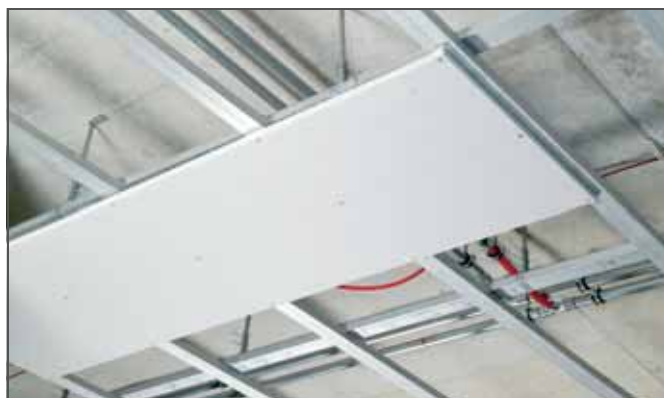
Rys. 4-34 Płyta ścienna zamontowana na suficie
