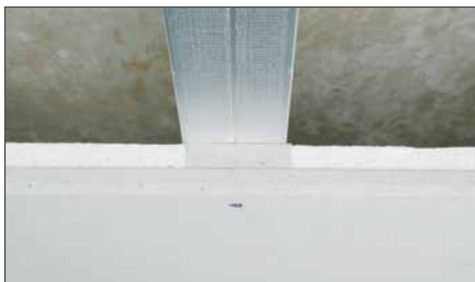
Rys. 4-6 Mocowanie płyty sufitowej
