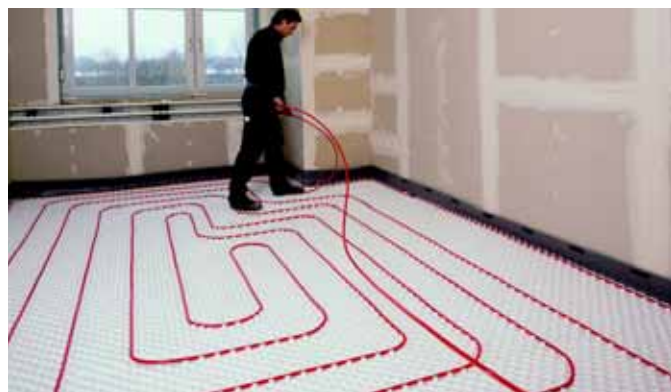
Rys. 3-57 Układanie rur na płycie systemowej A
