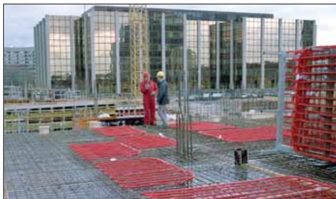
Rys. 8-3 Moduły BKT REHAU
