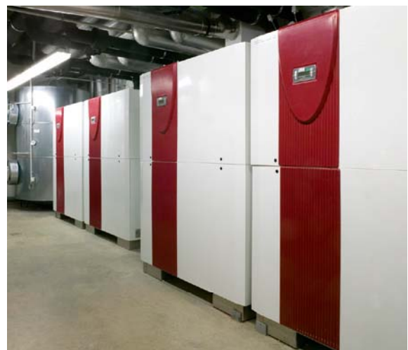
Instalacja c.o./c.w.u. w siedzibie firmy S. Olivier wykorzystuje 4 pompy ciepła solanka/woda SI 130TE.
