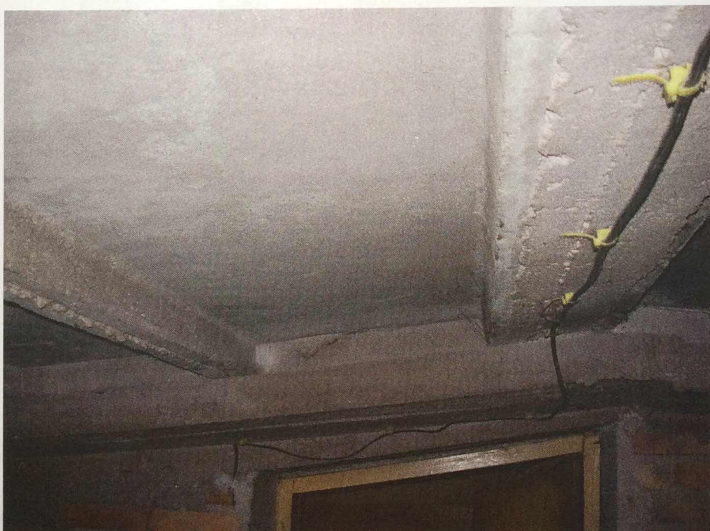
Zdj. nr6. Podparcie płyt korytkowych – brak widocznych ugięć, czy spękań na powierzchni płyty
