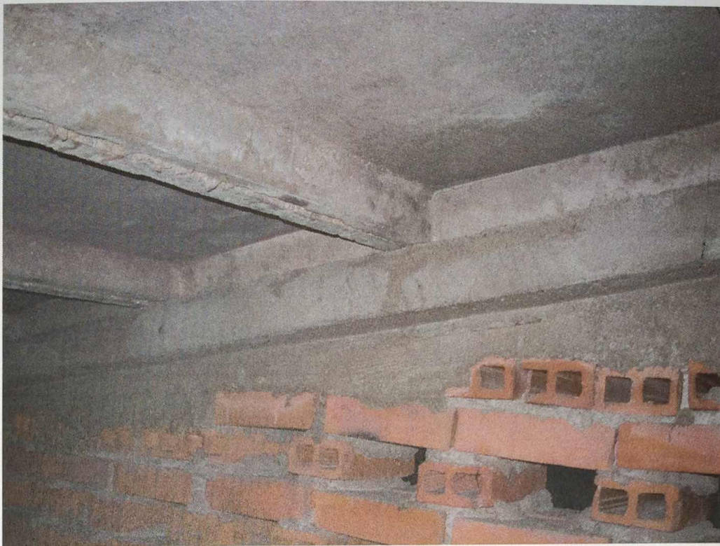
Zdj. nr5. Podparcie płyt korytkowych – brak widocznych ugięć, czy spękań na powierzchni płyty
