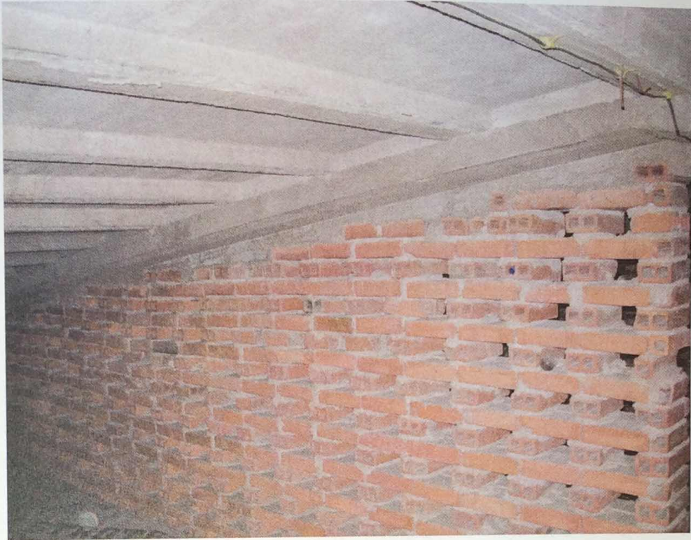
Zdj. nr3. Ściana ażurowa z cegły dziurawki na poddaszu zakończona wieńcem (strona wschodnia) – brak widocznych spękań i ubytków.
