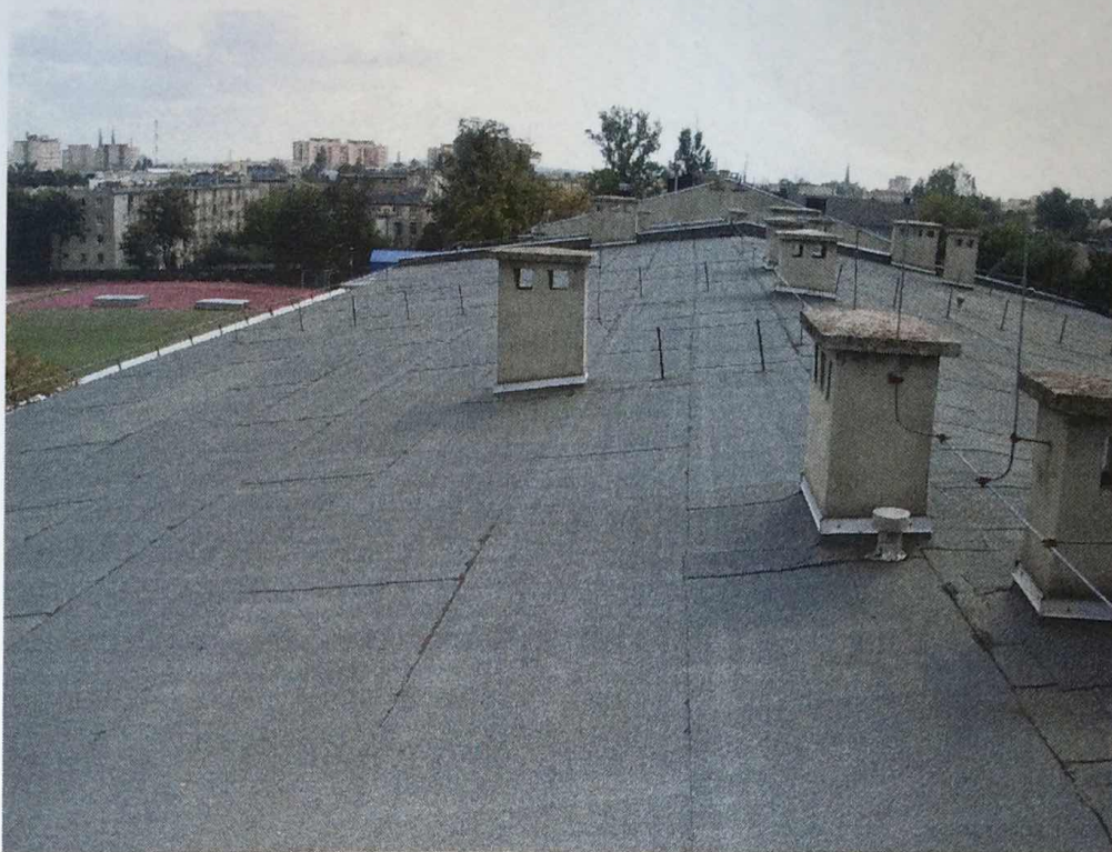
Zdj. nr1. Widoczna wschodnia połać dachu – lokalizacja projektowanych paneli fotowoltaicznych
