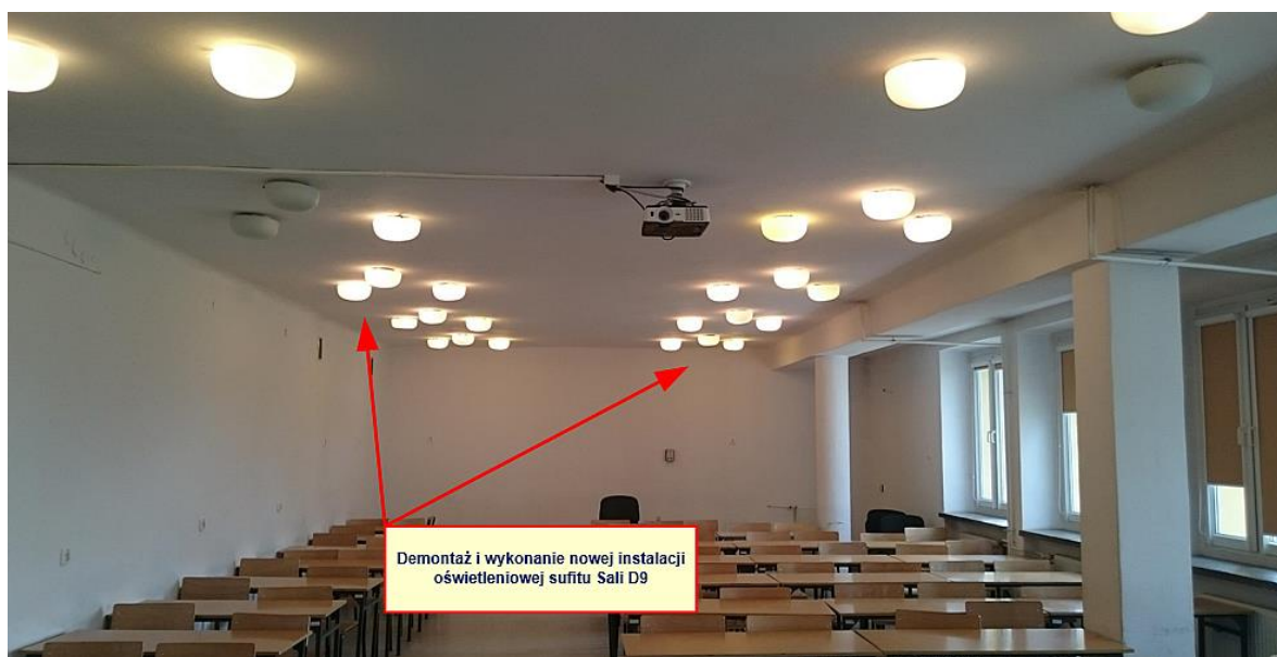
Fot. 1.10. Miejsce demontażu i wykonania nowej instalacji oświetleniowej w sali D-9
