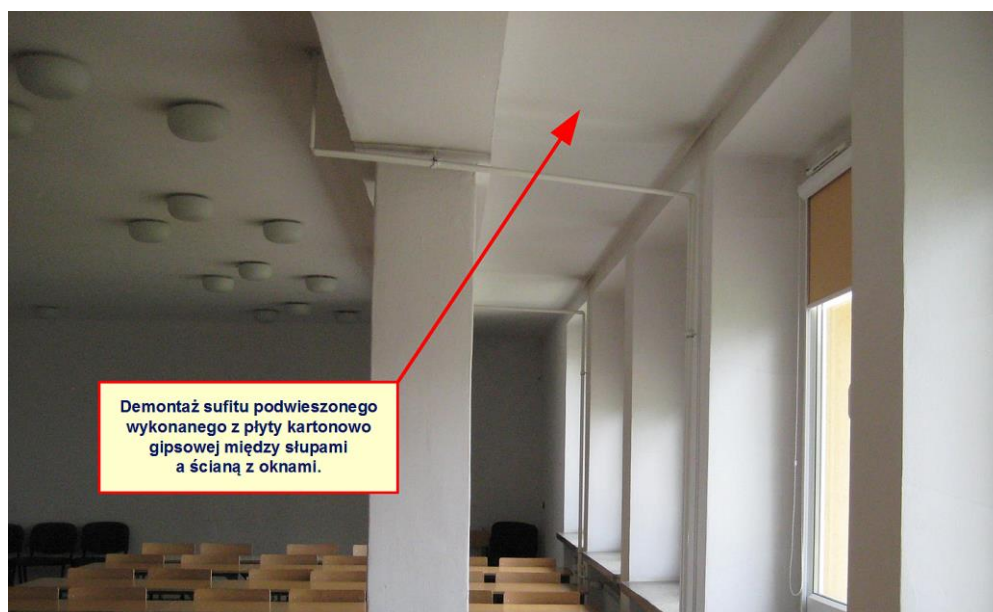
Fot.1.4. Sufit podwieszany z płyt kartonowo – gipsowych w sali D-9
