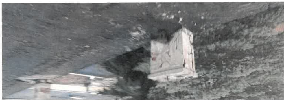
Zdjęcie nr 48. Widok komina wentylacyjnego – liczne ubytki cegły, odspojenia tynku – w trybie pilnym skuć komin należy rozebrać.
