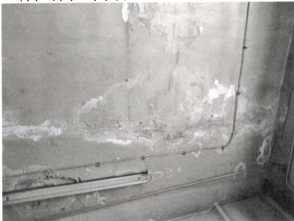
Zdjęcie nr 40. Widok ściany wewnątrz narożu budynku wschodnio-południowe – występują pionowe, częściowo ukośne pęknięcia, zalania i wykwyty.
