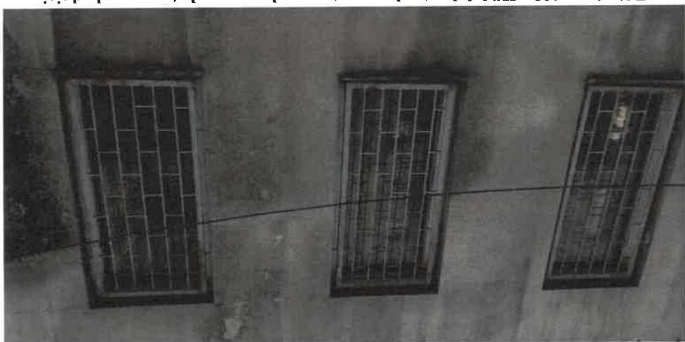
Zdjęcie nr 102. Widok kraty okna piwnicy pod rampą od strony wschodniej - mocna korozja, zalegające liście.
