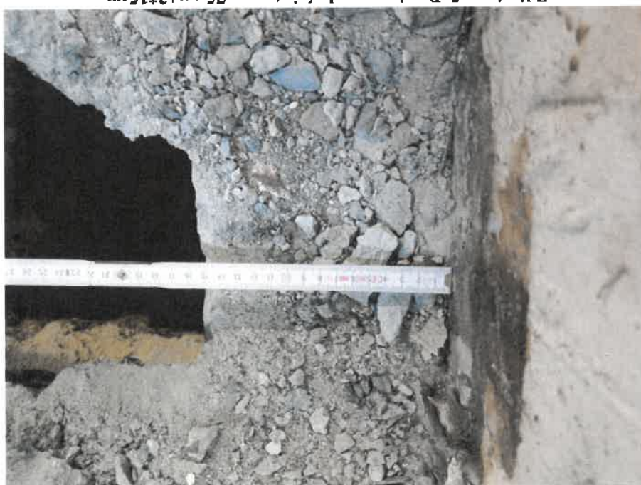
Zdjęcie nr 5. Pomiar szerokości stopy – 75 cm+2*15cm.
