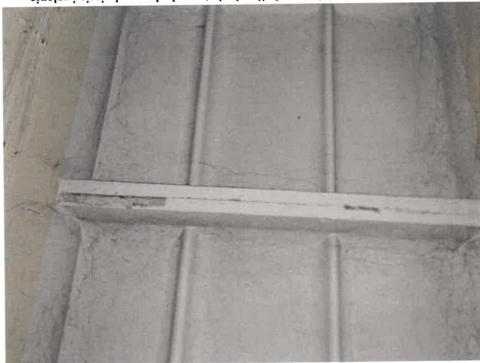
Zdjęcie nr 20. Widok konstrukcji nośnej stropodachu - po lewej strona wschodnia widoczne płyty dachowe korytkowe, po prawej od strony zachodniej widoczne płyty kanałowe mocno ugięte od strony północnej.
