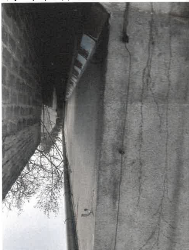
Zdjęcie nr 95. Widok parapetu od strony wschodniej - mocno skorodowany, nieszczelności połączeń.
