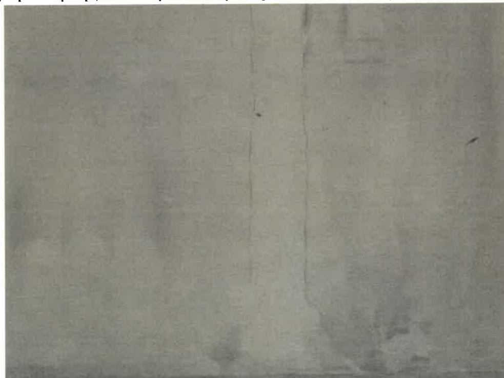
Zdjęcie nr 32. Widok ściany wewnątrz – połączenie muru z pionem wentylacyjnym z kształtek ceramicznych – występują pionowe, częściowo ukośne spękania. Występują rysy, zalania i wykwyty.
