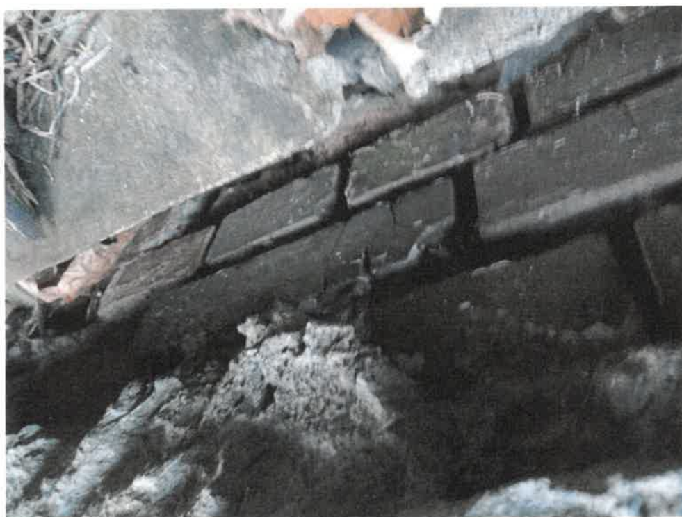
Zdjęcie nr 89. Widok muru ścian piwnicy od strony zachodniej - fragment muru bez tynku i izolacji przeciwwilgociowej pionowej ściany z właściwym odprowadzeniem wody deszczowej, opaska oberwana, teren zapadnięty w środkowej części.
