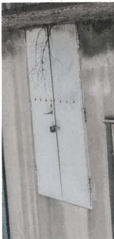
Zdjęcie nr 92. Widok drzwi stalowe na rampie do magazynu na parterze od strony wschodniej - ogniska korozji w dolnej części, duże nieszczelności.
