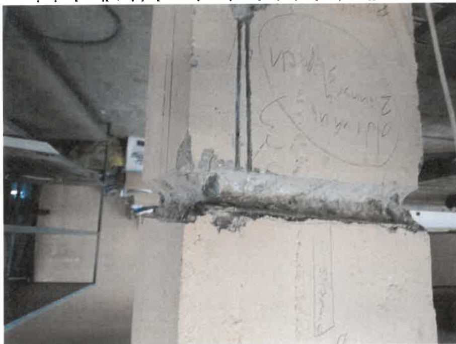
Zdjęcie nr 13. Widoczna odkrywka zbrojenia słupa i pomiar grubości otuliny zbrojenia wynoszący od 2 do 4,5 cm.
