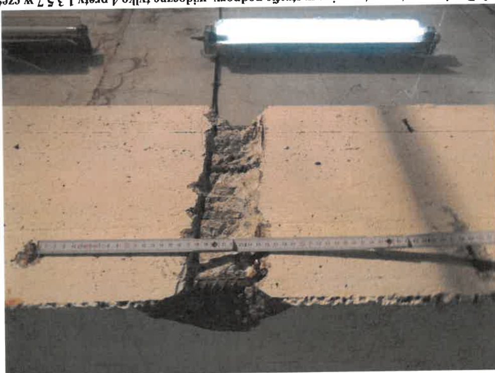
Zdjęcie nr 9. Pomiar rozstawu strzemion w strefie podpory, widoczne tylko 4 pręty 1,3,5,7 w części dolnej, widoczna odkrywka zbrojenia słupa, otulina zbrojenia wynosząca od 0,5 do 2,5 cm.
