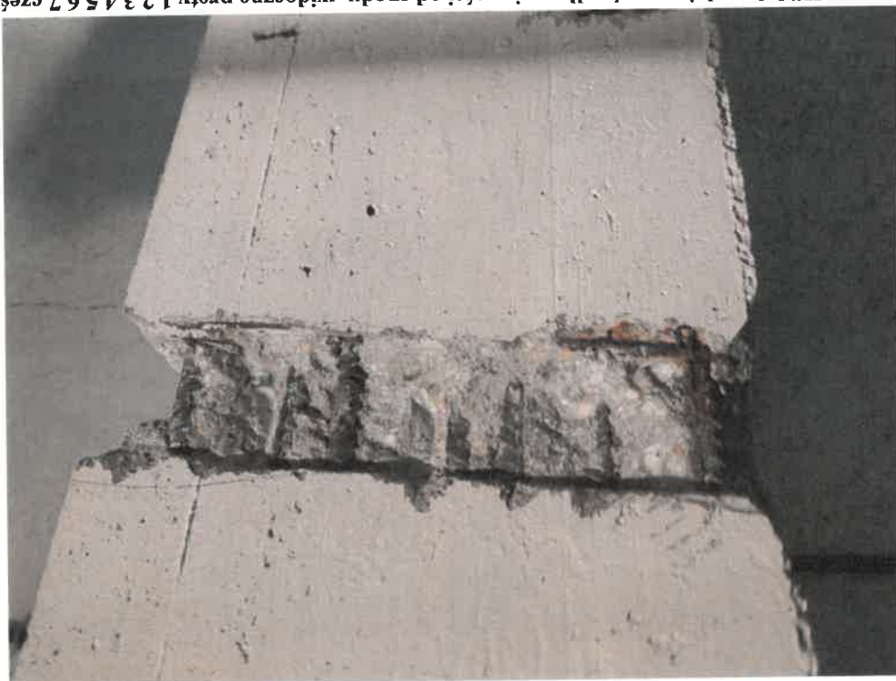
Zdjęcie nr 9. Pomiar rozstawu strzemion w strefie podpory, widoczne tylko 4 pręty 1,3,5,7 w części dolnej, widoczna odkrywka zbrojenia słupa, otulina zbrojenia wynosząca od 0,5 do 2,5 cm.
