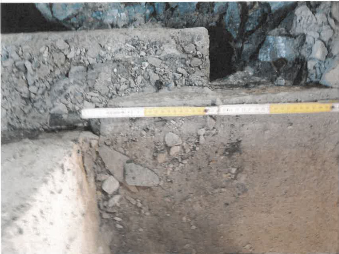
Zdjęcie nr 4. Pomiar długości stopy – 75 cm+2*20cm.
