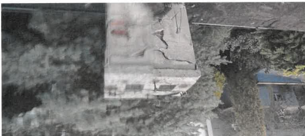
Zdjęcie nr 49. Widok komina wentylacyjnego – liczne ubytki cegły, odspojenia tynku – w trybie pilnym skuć komin należy rozebrać.
