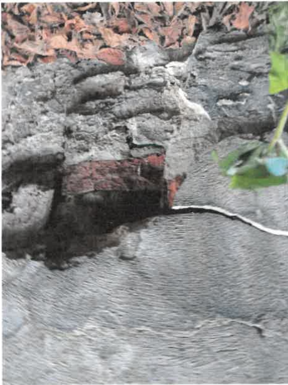
Zdjęcie nr 82. Widok ścian zewnętrznych - spękane tynki , miejscowe uszkodzona konstrukcja mury, odpadnięty kawałek cegły i tynku , zawilgocenie ścian.
