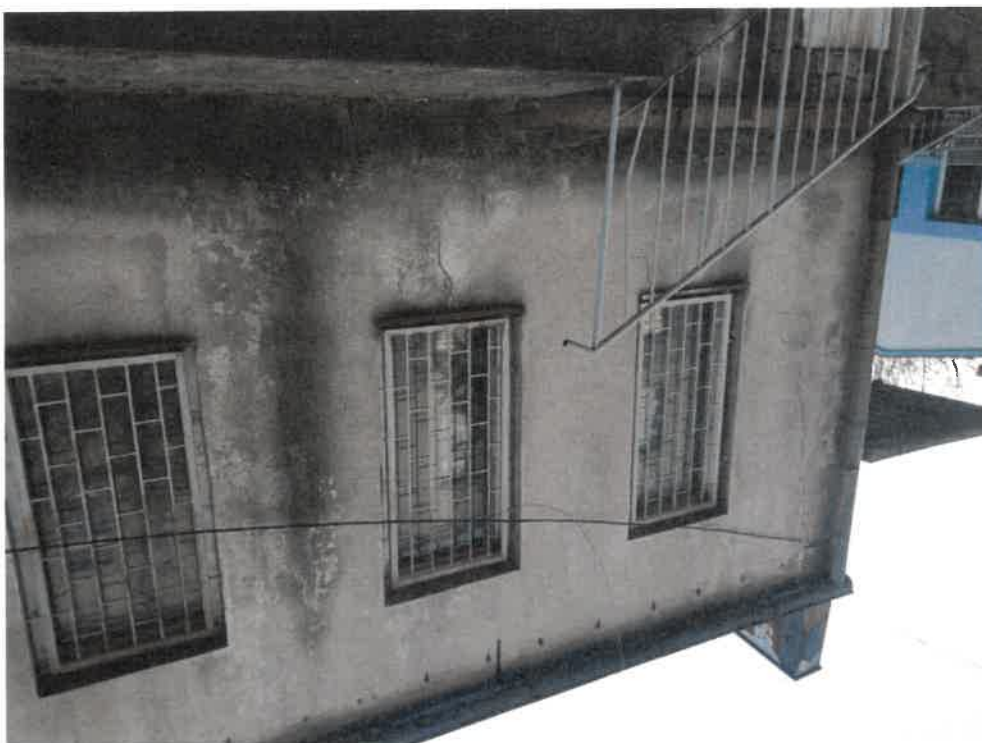
Zdjęcie nr 43. Widok naroża budynku wschodnio-południowego – występują pionowe, częściowo ukośne pęknięcia, zalania i wykwit.
