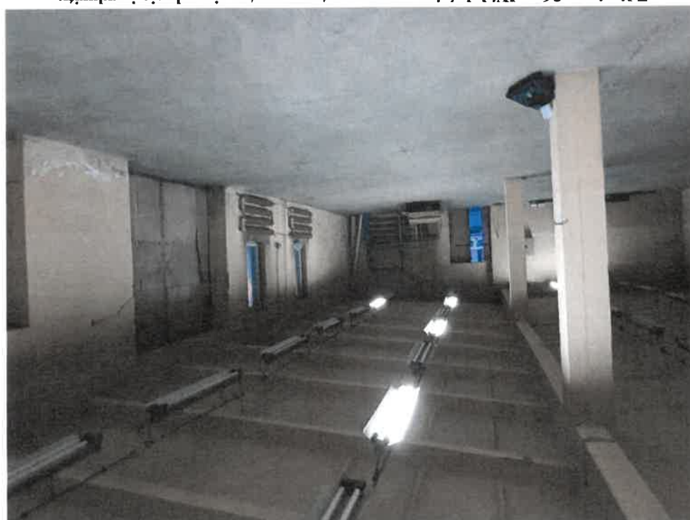
Zdjęcie nr 36. Widok ściany wewnątrz – występują zalania i wykwyty.
