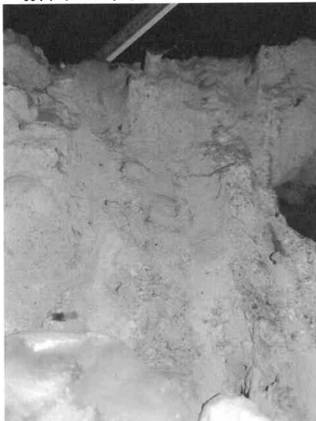
Zdjęcie nr 17. Widok płyty kanałowej stropowej stropodachu wysokości 22 cm, widoczne żebro zbrojone tyłko dołem 2 pręty D=10\text{mm} 34GS, otulina zbrojenia 1 cm
