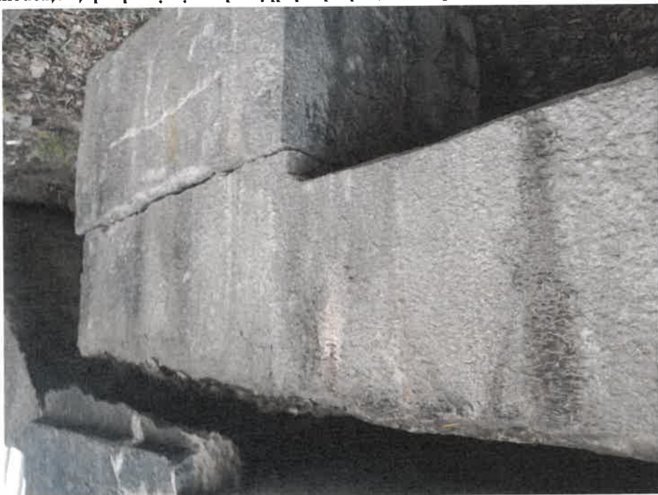
Zdjęcie nr 63. Widok mурowanych słupów, belkę podparcia i czoło płyty stropowej rampy – widoczne osiadanie i szczelina między płytą, a belką podparcia.
