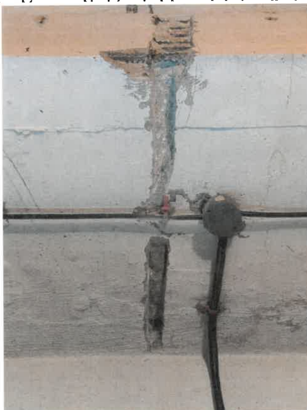
Zdjęcie nr 11. Widok podciągu w środkowej z boku, w dolnej części widoczny spód podciągu, widoczna odkrywka zbrojenia słupa: pręty 1,2,3,4,5,6,7 w części dolnej, jeden pręt w strefie środkowej oraz jeden pręt w części górnej, otulina zbrojenia wynosząca od 1,5 do 3 cm.
