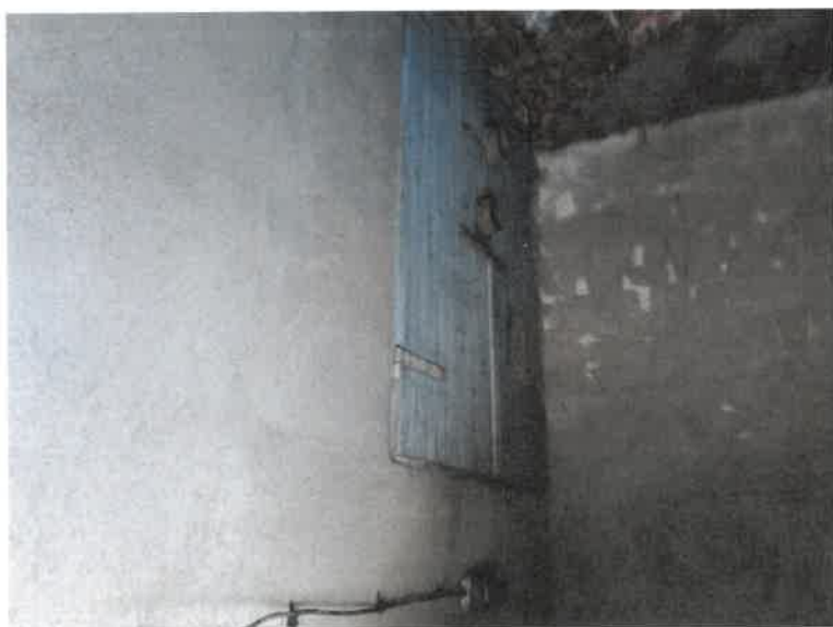
Zdjęcie nr 91. Widok drzwi drewniane do piwnicy od strony południowej - drzwi wypaczone, duże nieszczelności.
