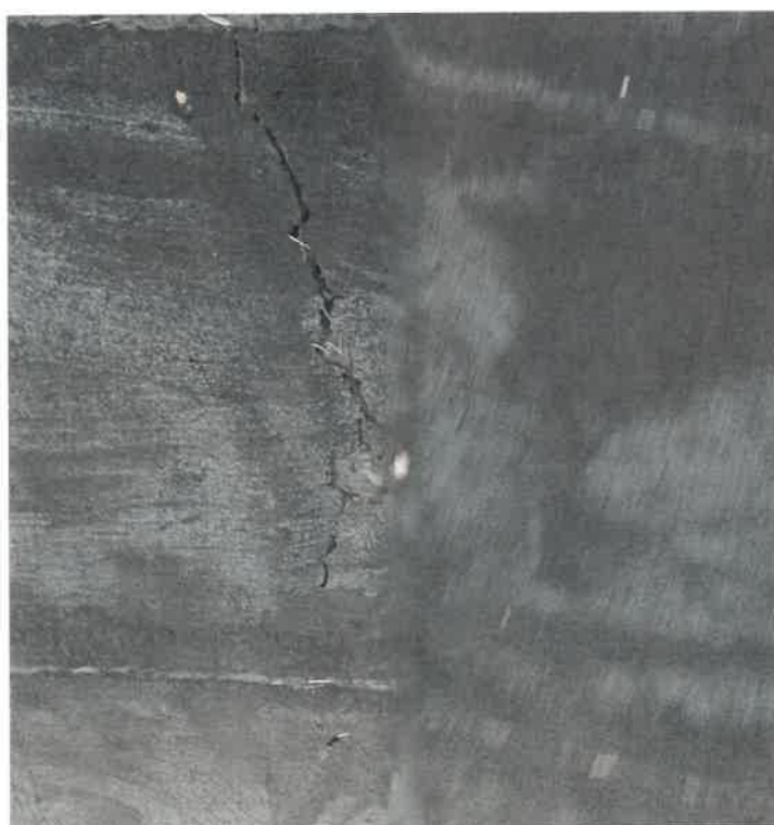
Zdjęcie nr 78. Widok poszycia stropodachu budynku - liczne spękanie poprzeczne, dziury w poszyciu.
