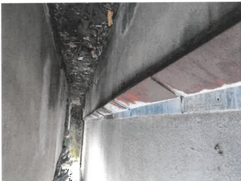
Zdjęcie nr 96. Widok obróbki okapu na murze ścian piwnicy od strony zachodniej - obróbki mocno skorodowane, miejscowe dziury w blasze, nieszczelności połączeń.
