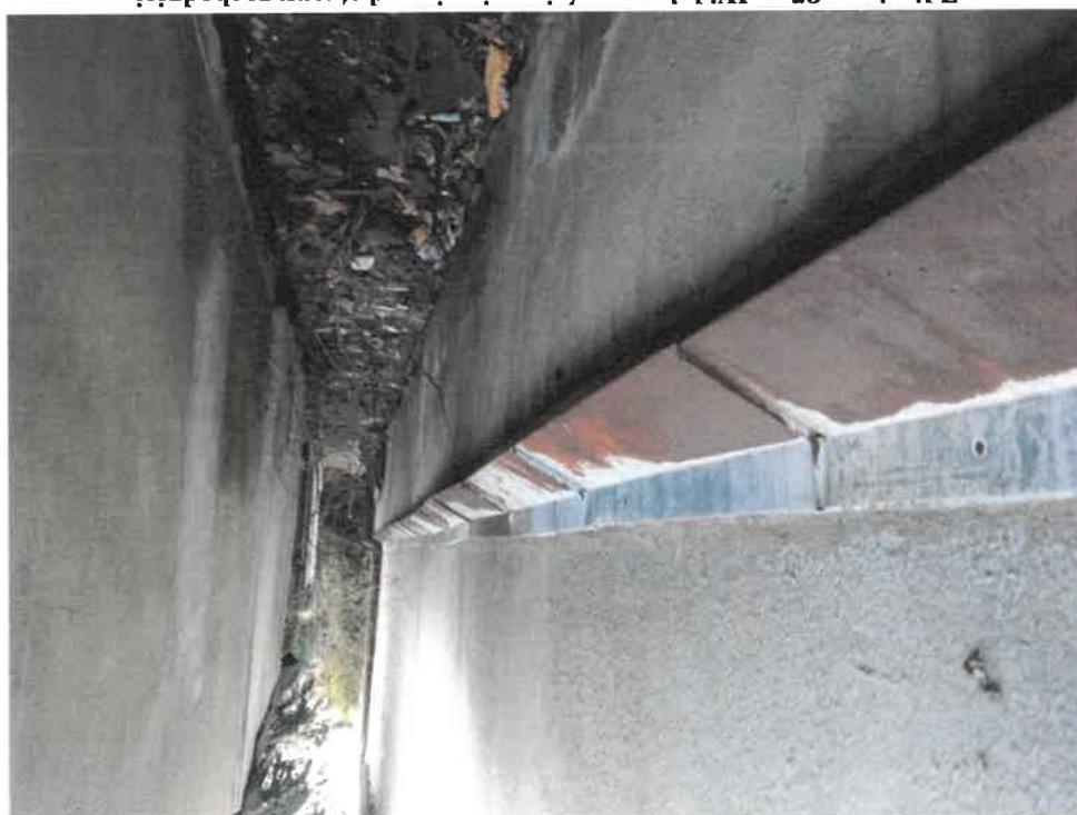
Zdjęcie nr 87. Widok muru ścian piwnicy od strony zachodniej - brak opaski z właściwym odprowadzeniem wody deszczowej, opaska oberwana, teren zapadnięty w środkowej części.
