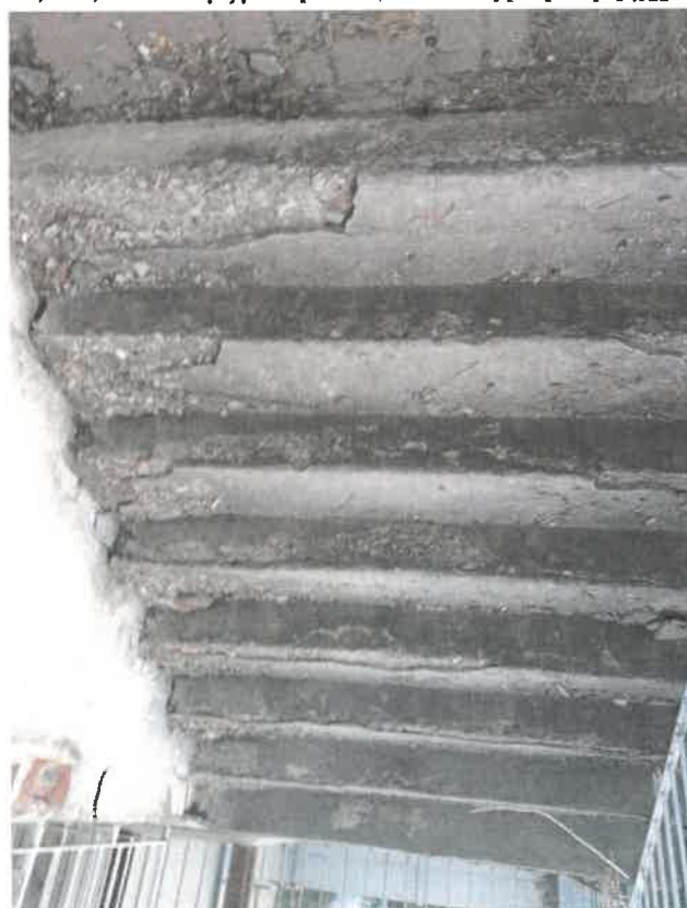
Zdjęcie nr 67. Widok schodów zewnętrznych wejścia na parter strona południowa – spękania, ubytki w stopniach schodów.
