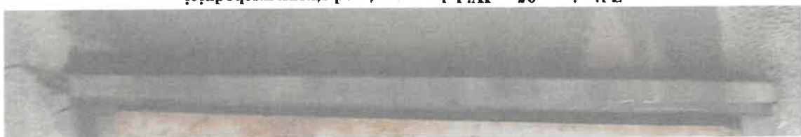
Zdjęcie nr 95. Widok parapetu od strony wschodniej - mocno skorodowany, nieszczelności połączeń.
