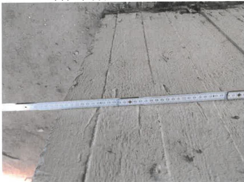
Zdjęcie nr 6. Pomiar szerokości dolnej części słupa.
