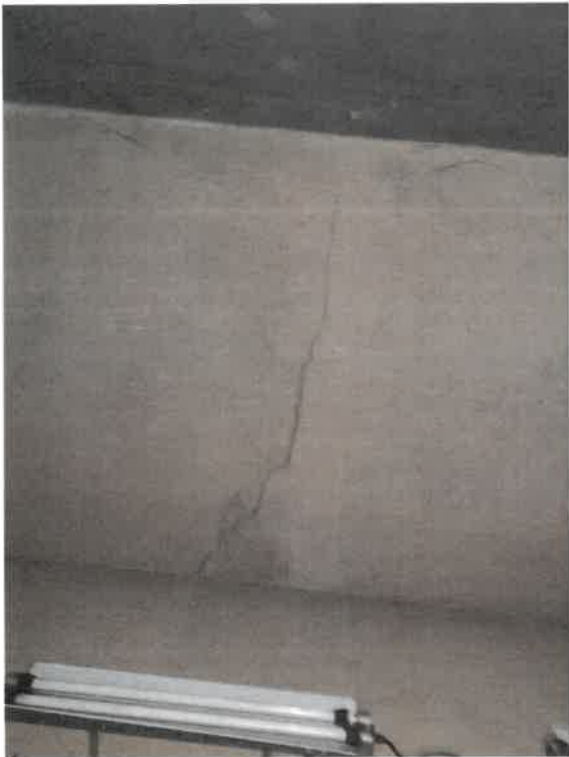
Zdjęcie nr 26. Widok ściany w wewnątrz – połączenie muru z pionem wentylacyjnym z kształtek ceramicznych – występują pionowe, częściowo ukośne spęknięcia. Występują rysy, zalania i wykwit.
