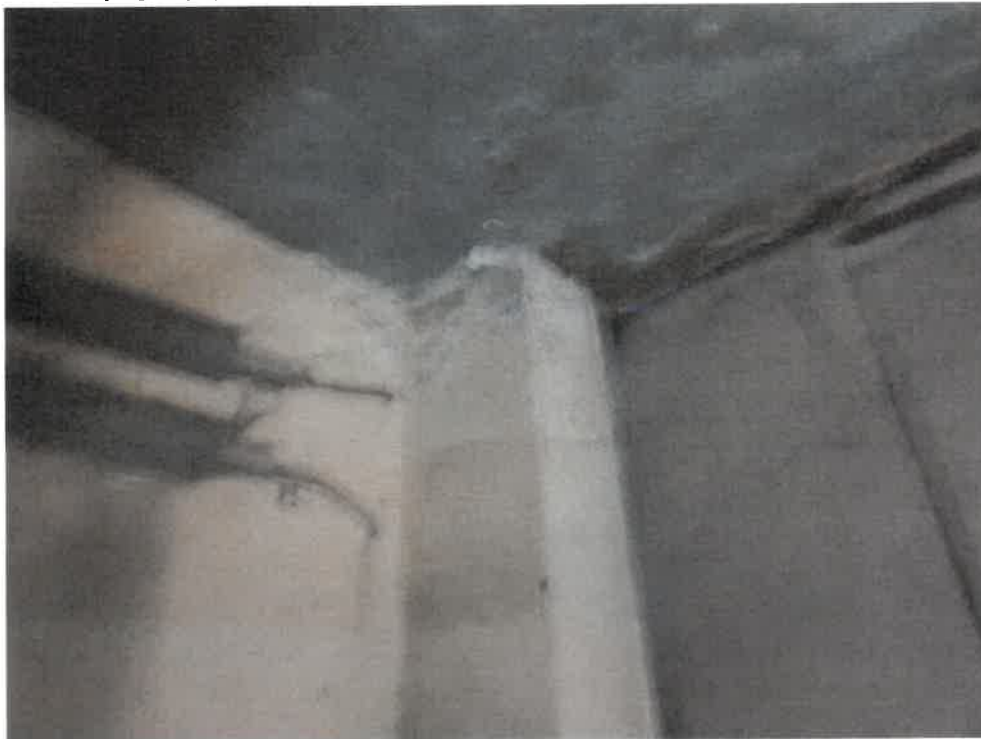
Zdjęcie nr 34. Widok ściany wewnątrz – występują rysy, zalania i wykwyty.
