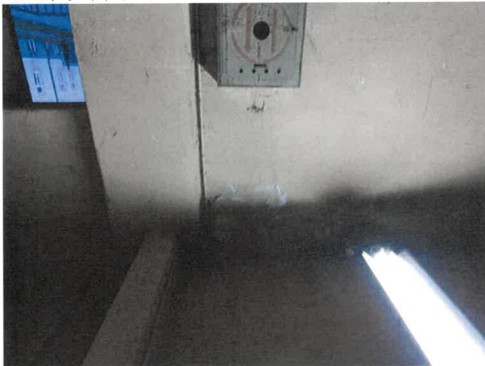
Zdjęcie nr 36. Widok ściany wewnątrz – występują zalania i wykwyty.
