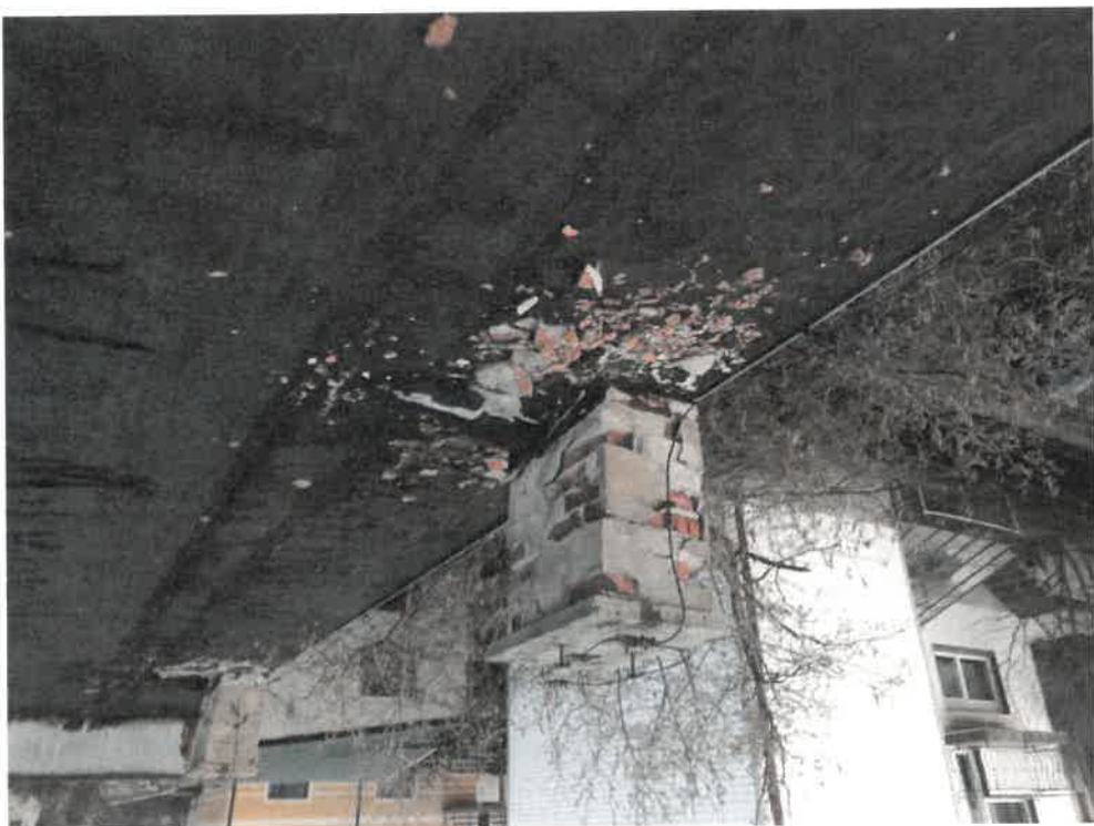
Zdjęcie nr 53. Widok komina wentylacyjnego – liczne ubytki cegły, odspojenia tynku – w trybie pilnym skuć komin należy rozebrać.
