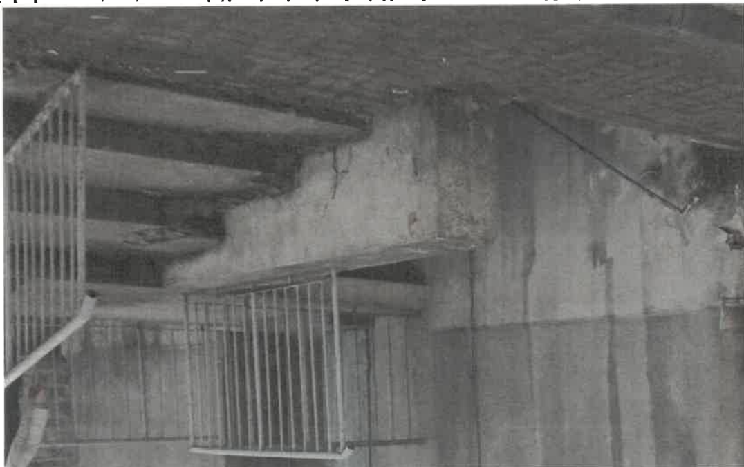
Zdjęcie nr 69. Widok schodów zewnętrznych zejścia do piwnicy i wejścia na parter strona południowa – spęknięcia, ubytki w stopniach schodów.
