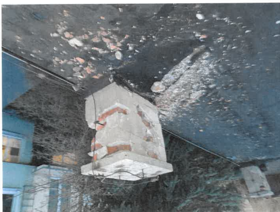
Zdjęcie nr 51. Widok komina wentylacyjnego – liczne ubytki cegły, odspojenia tynku – w trybie pilnym skuć komin należy rozebrać.
