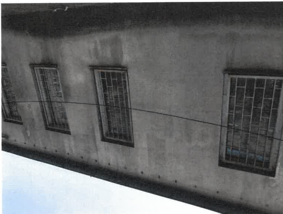
Zdjęcie nr 41. Widok ściany z zewnątrz – wzdłuż rampy – występują zalania i wykwyty.
