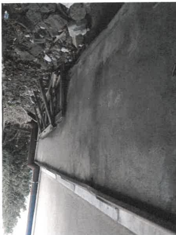
Zdjęcie nr 90. Widok muru ścian piwnicy od strony zachodniej - brak opaski z właściwym odprowadzeniem wody deszczowej, opaska oberwana, teren zapadnięty w środkowej części.
