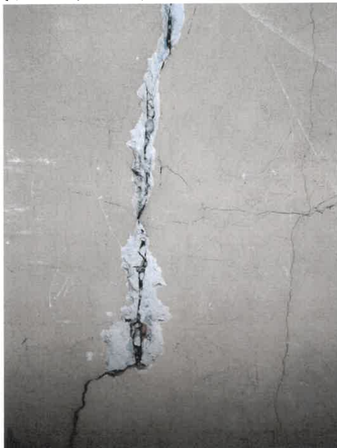
Zdjęcie nr 28. Widok ściany wewnątrz – połączenie muru z pionem wentylacyjnym z kształtek ceramicznych – występują pionowe, częściowo ukośne spękania.
