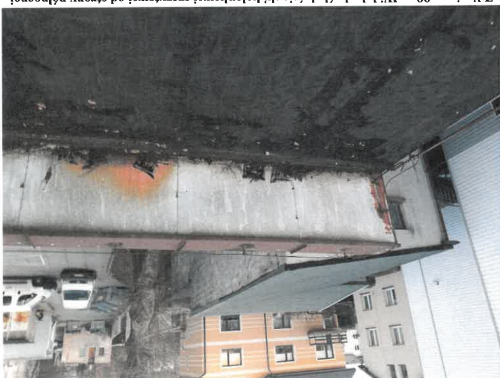
Zdjęcie nr 98. Widok obróbek ścianki kolankowej szczytowej od strony północnej - obróbki mocno skorodowane, miejscowe dziury w blaszce, nieszczelności połączeń.
