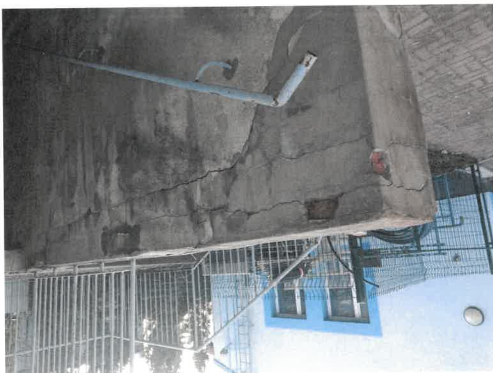
Zdjęcie nr 55. Widok od strony północno-zachodniej ścian zewnętrznych schodów i płyty wejścia do budynku strona południowa budynku – liczne ubytki cegły, odspojenia tynku – w trybie pilnym skuć odspojone tynki i uszkodzone cegły.
