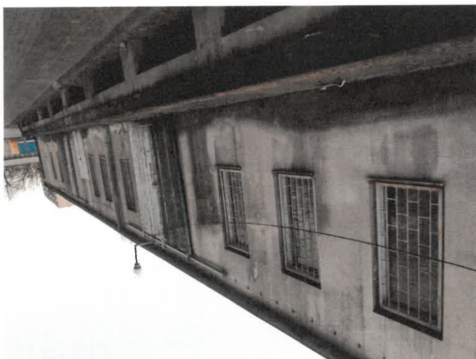
Zdjęcie nr 42. Widok ściany z zewnątrz – wzdłuż rampy – występują zalania i wykwit.
