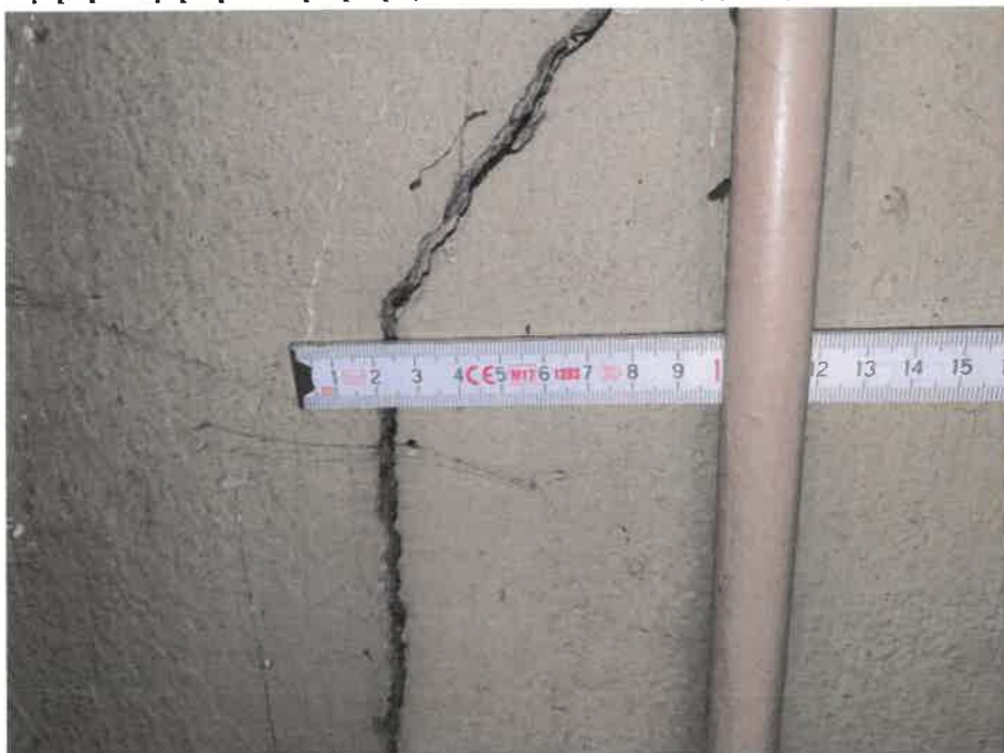
Zdjęcie nr 39. Widok ściany wewnątrz naroże budynku wschodnio-południowe – występują pionowe, częściowo ukośne pęknięcia o szerokości do 4 mm.
