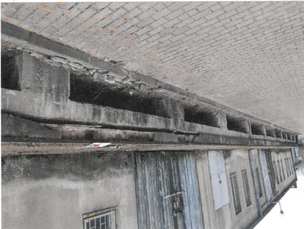
Zdjęcie nr 66. Widok mурowanych słupków, belkę podparcia i czoło płyty stropowej ramy – widoczne osiadanie i szczelina między płytą, a belką podparcia.
