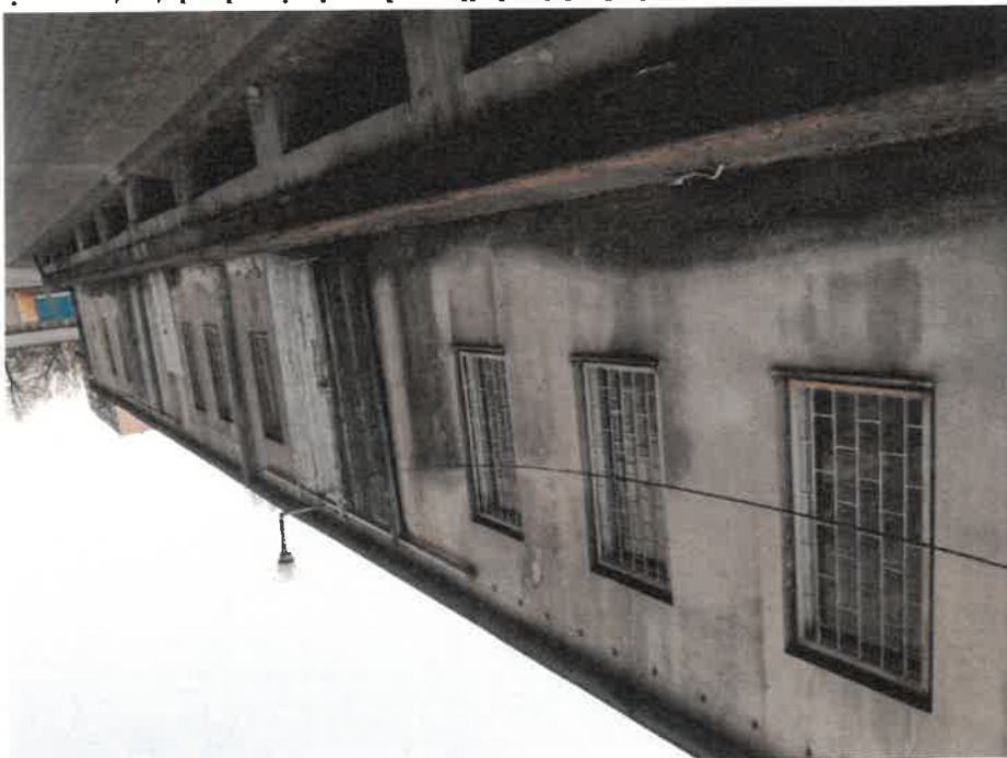
Zdjęcie nr 63. Widok mурowanych słupów, belkę podparcia i czoło płyty stropowej rampy – widoczne osiadanie i szczelina między płytą, a belką podparcia.
