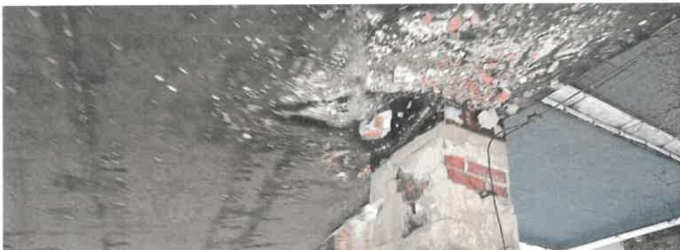
Zdjęcie nr 49. Widok komina wentylacyjnego – liczne ubytki cegły, odspojenia tynku – w trybie pilnym skuć komin należy rozebrać.
