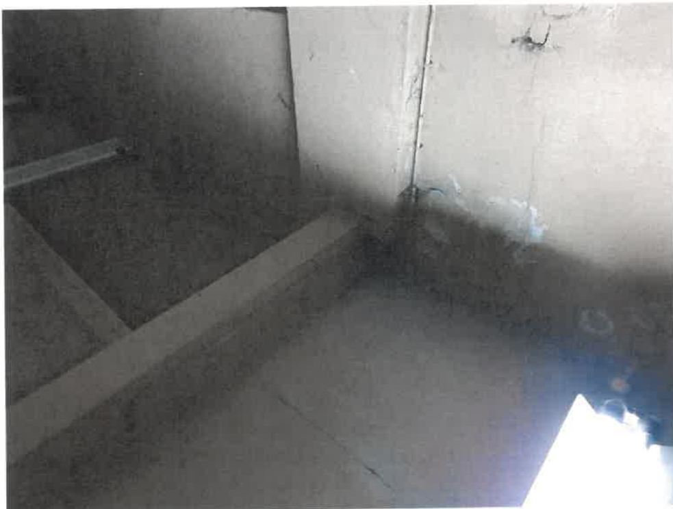
Zdjęcie nr 18. Widok konstrukcji nośnej stropodachu - po lewej strona wschodnia widoczne płyty dachowe korytkowe, po prawej od strony zachodniej widoczne płyty kanałowe.
