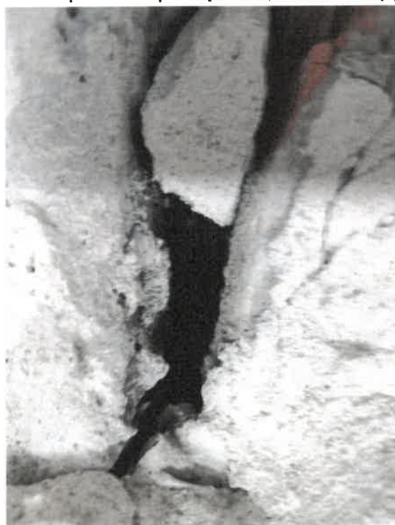
Zdjęcie nr 30. Widok ściany w wewnątrz – połączenie muru z pionem wentylacyjnym z kształtek ceramicznych po skuciu tynku – występują szczeliny złego powiązania muru o szerokości do 12 mm.
