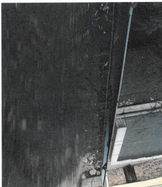
Zdjęcie nr 100. Widok ryny od strony zachodniej - odcinki korozji, zalegające liście oraz zastój wody.
