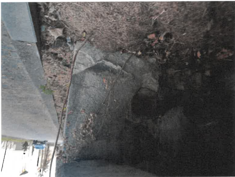
Zdjęcie nr 58. Widok murywanego słupka – liczne ubytki cegły, odsłonięcia tynku – w trybie pilnym skuć odsłonięte tynki i uszkodzone cegły.
