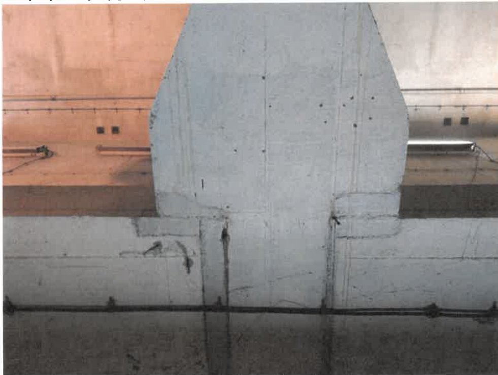
Zdjęcie nr 7. Pomiar szerokości górnej części słupa, widoczna odkrywka zbrojenia słupa i pomiar grubości otuliny zbrojenia wynoszący od 2 do 4,5 cm.
