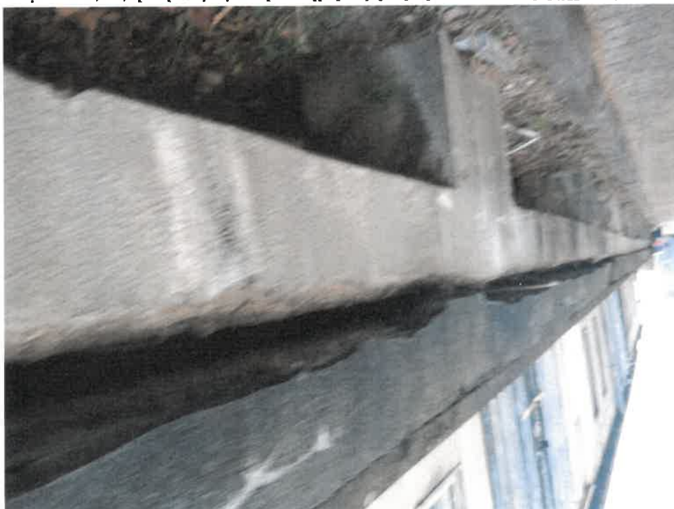
Zdjęcie nr 65. Widok mурowanych słupków, belkę podparcia i czoło płyty stropowej ramy – widoczne osiadanie i szczelina między płytą, a belką podparcia.
