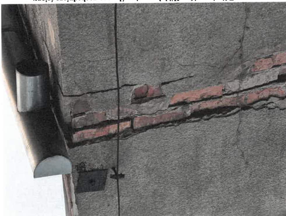
Zdjęcie nr 46. Widok naroża północno-zachodniego ściany – liczne ubytki cegły w murze, odspojenia tynku – w trybie pilnym skuć odspojone tynki i uszkodzone cegły.
