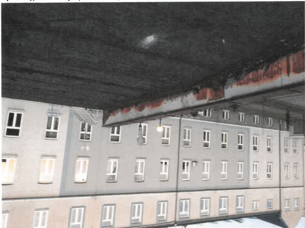
Zdjęcie nr 98. Widok obróbek ścianki kolankowej szczytowej od strony północnej - obróbki mocno skorodowane, miejscowe dziury w blaszce, nieszczelności połączeń.
