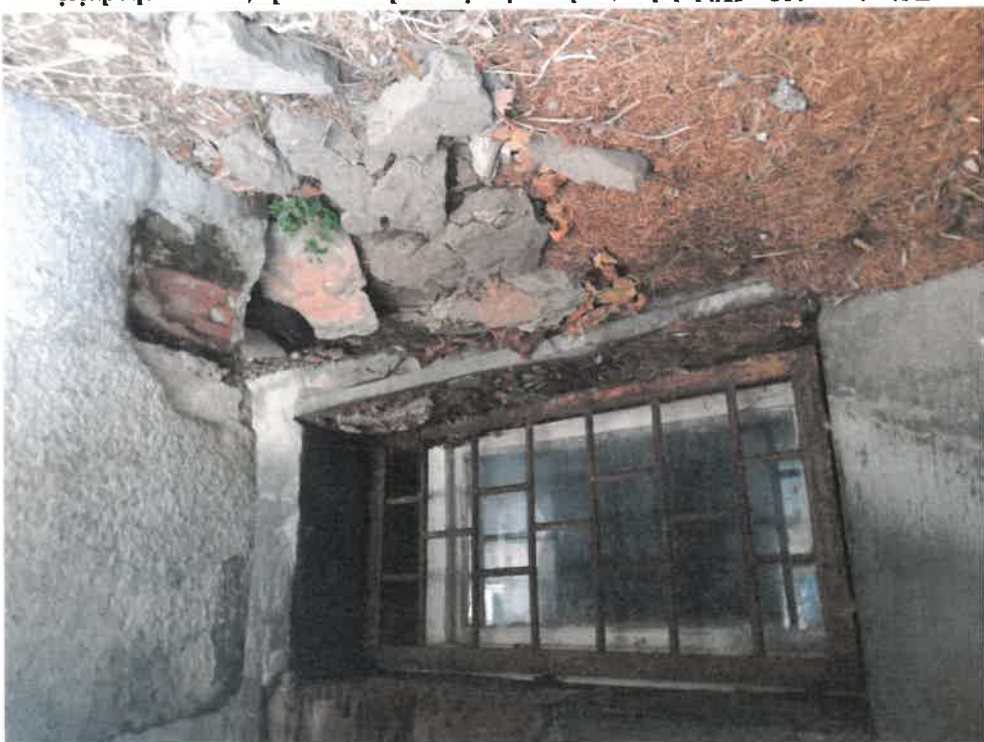
Zdjęcie nr 102. Widok kraty okna piwnicy pod rampą od strony wschodniej - mocna korozja, zalegające liście.
