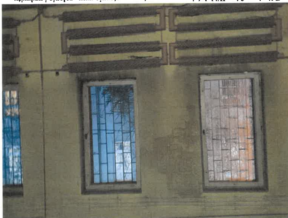
Zdjęcie nr 34. Widok ściany wewnątrz – występują rysy, zalania i wykwyty.
