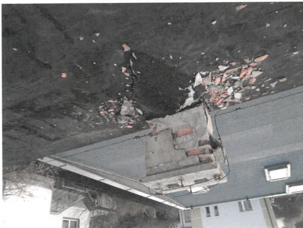
Zdjęcie nr 52. Widok komina wentylacyjnego – liczne ubytki cegły, odspojenia tynku – w trybie pilnym skuć komin należy rozebrać.
