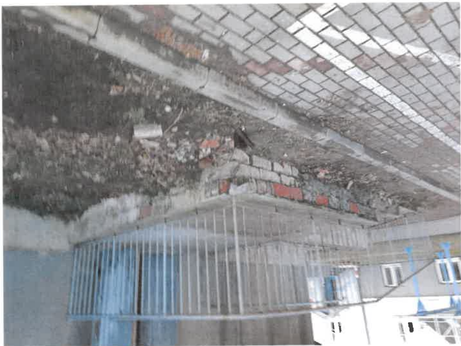
Zdjęcie nr 54. Widok ścian zewnętrznych schodów i płyty wejścia do budynku od strony północno-zachodniej – liczne ubytki cegły, odspojenia tynku – w trybie pilnym skuć odspojone tynki i uszkodzone cegły.
