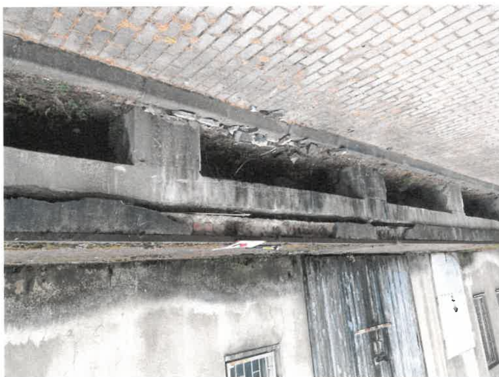
Zdjęcie nr 61. Widok mурowanych słupków, belkę podparcia i czoło płyty stropowej rampy—liczne ubytki cegły, odspojenia tynku – w trybie pilnym skuć odspojone tynki i uszkodzone cegły- widoczne osiadanie i szczelina między płytą , a belką podparcia.
