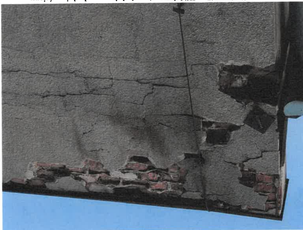
Zdjęcie nr 46. Widok naroża północno-zachodniego ściany – liczne ubytki cegły w murze, odspojenia tynku – w trybie pilnym skuć odspojone tynki i uszkodzone cegły.
