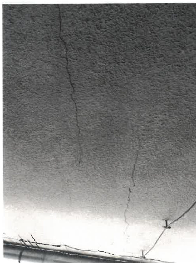
Zdjęcie nr 85. Widok ścian zewnętrznych - zarysowania i pęknięcia.
