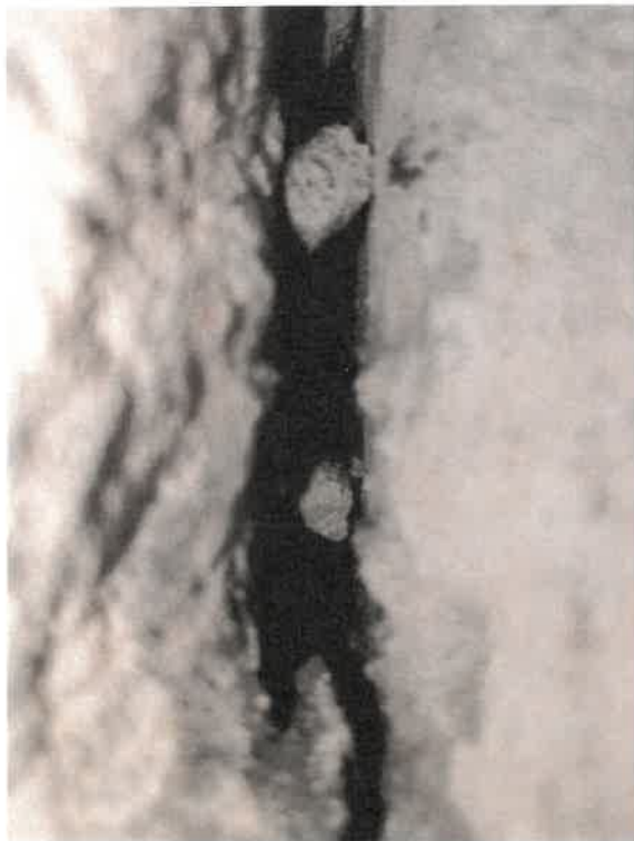
Zdjęcie nr 31. Widok ściany w wewnątrz – połączenie muru z pionem wentylacyjnym z kształtek ceramicznych po skuciu tynku – występują szczeliny złego powiązania muru o szerokości do 12 mm.
