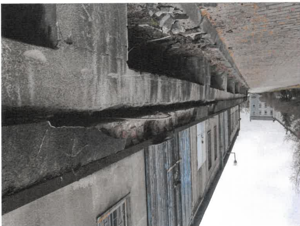
Zdjęcie nr 61. Widok mурowanych słupków, belkę podparcia i czoło płyty stropowej rampy—liczne ubytki cegły, odspojenia tynku – w trybie pilnym skuć odspojone tynki i uszkodzone cegły- widoczne osiadanie i szczelina między płytą , a belką podparcia.
