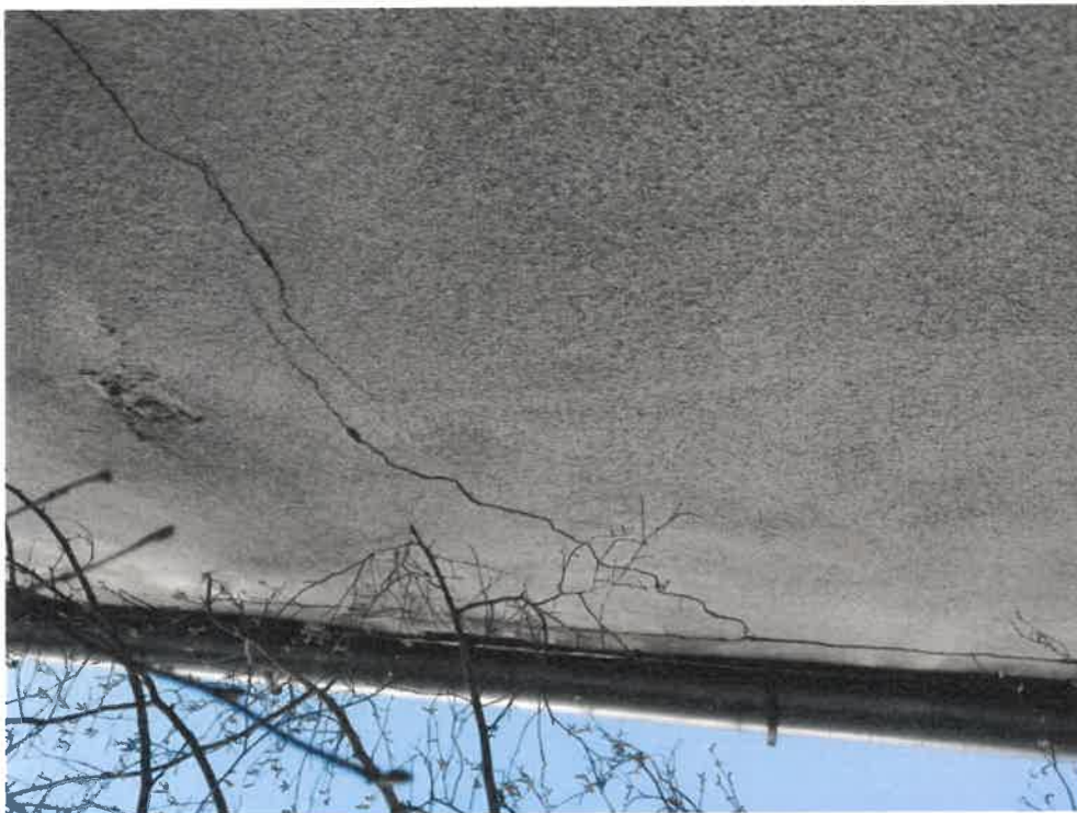
Zdjęcie nr 84. Widok ścian zewnętrznych - zarysowania i pęknięcia.
