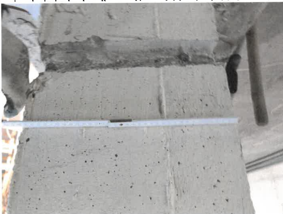
Zdjęcie nr 7. Pomiar szerokości górnej części słupa, widoczna odkrywka zbrojenia słupa i pomiar grubości otuliny zbrojenia wynoszący od 2 do 4,5 cm.
