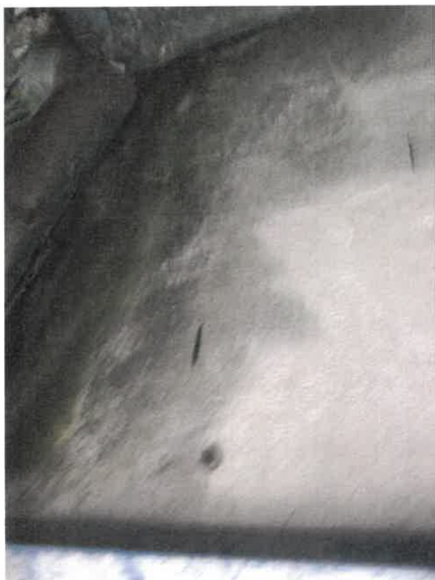
Zdjęcie nr 86. Widok ścian zewnętrznych - zarysowania i pęknięcia, zalanie i zawilgocenie ścian.
