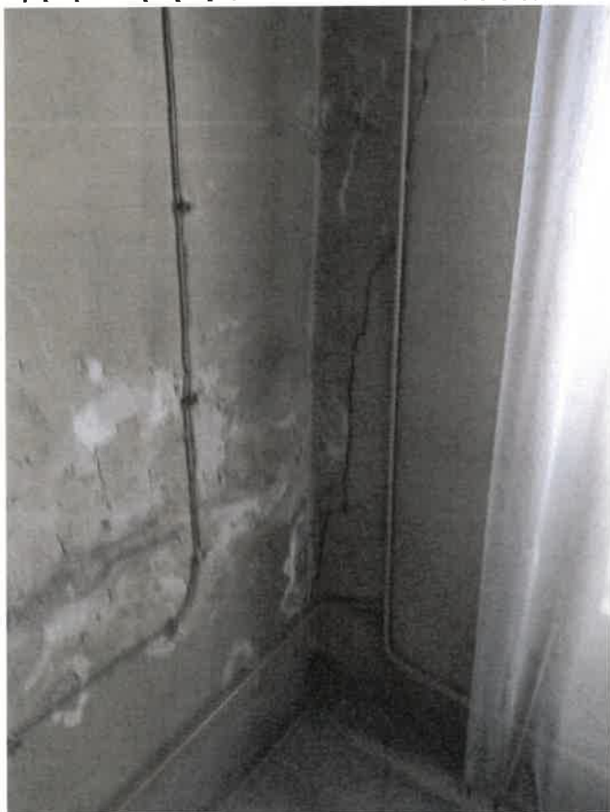
Zdjęcie nr 38. Widok ściany wewnątrz naroże budynku wschodnio-południowe – występują pionowe, częściowo ukośne pęknięcia, zalania i wykwyty.
