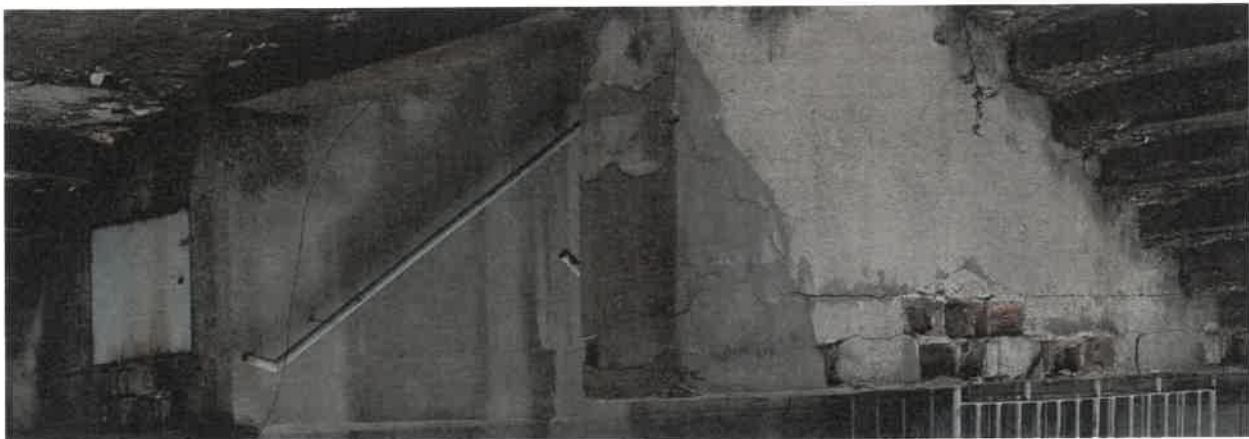
Zdjęcie nr 57. Widok ścian zewnętrznych schodów i płyty wejścia do budynku od strony południowo-wschodniej – liczne ubytki cegły, odsłonięcia tynku – w trybie pilnym skuć odsłonięte tynki i uszkodzone cegły.
