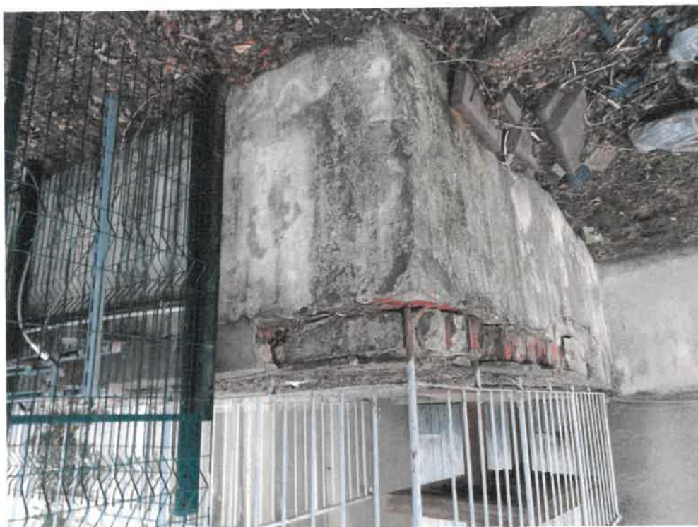
Zdjęcie nr 56. Widok ścian zewnętrznych schodów i płyty wejścia do budynku od strony południowo-zachodniej – liczne ubytki cegły, odspojenia tynku – w trybie pilnym skuć odspojone tynki i uszkodzone cegły.
