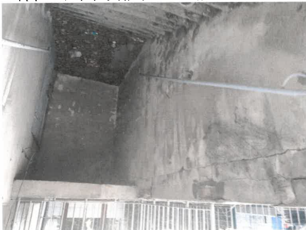
Zdjęcie nr 67. Widok schodów zewnętrznych wejścia na parter strona południowa – spękania, ubytki w stopniach schodów.
