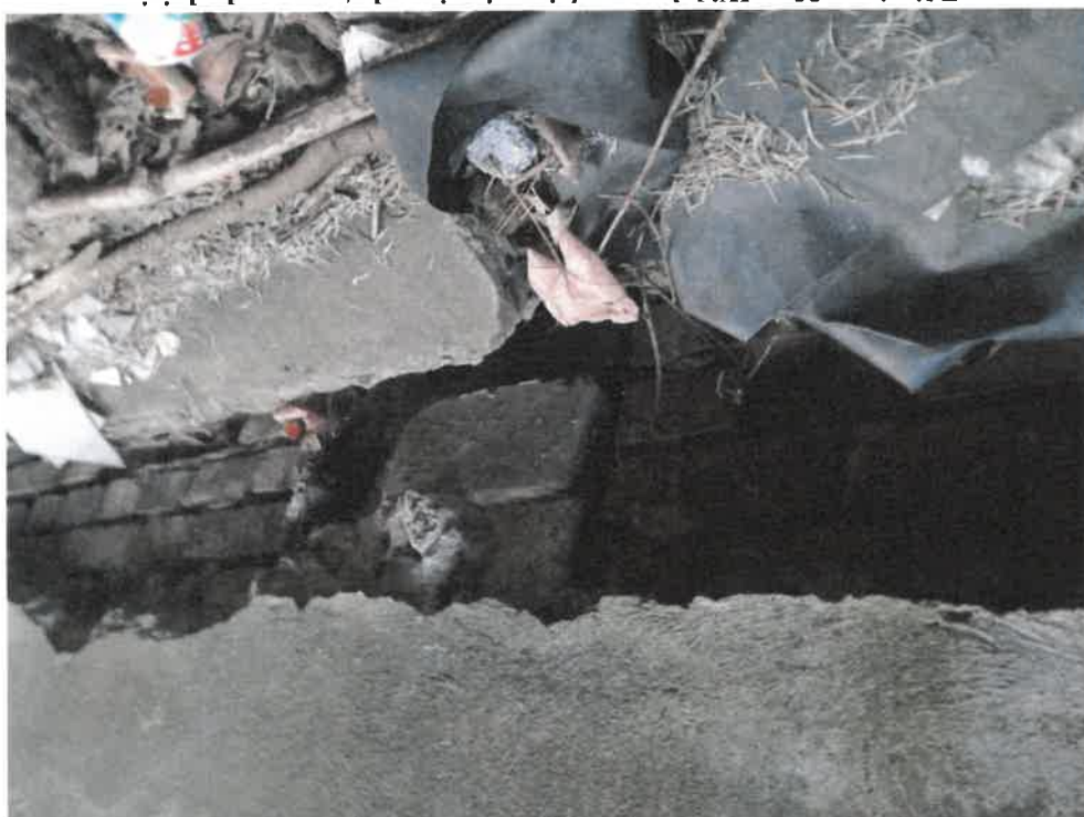
Zdjęcie nr 87. Widok muru ścian piwnicy od strony zachodniej - brak opaski z właściwym odprowadzeniem wody deszczowej, opaska oberwana, teren zapadnięty w środkowej części.
